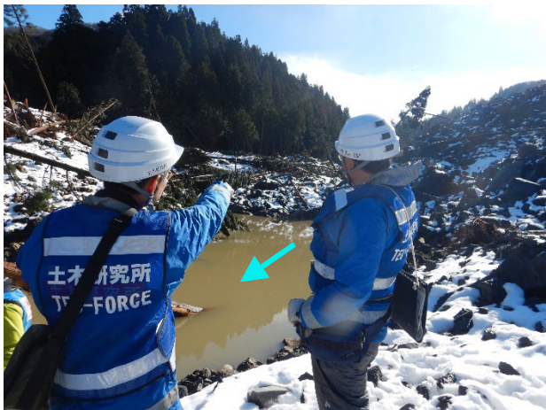
閉塞部下流の土砂堆積状況（11日）
