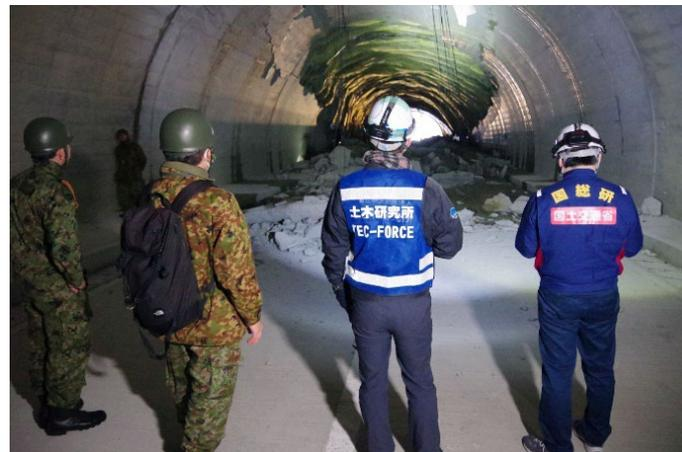
写真2 覆工崩落箇所での被害調査状況
