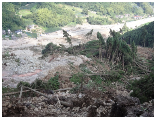
地すべりの崩壊状況【7月13日撮影】
