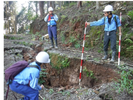
崩壊上部の地すべり亀裂【7月13日撮影】
