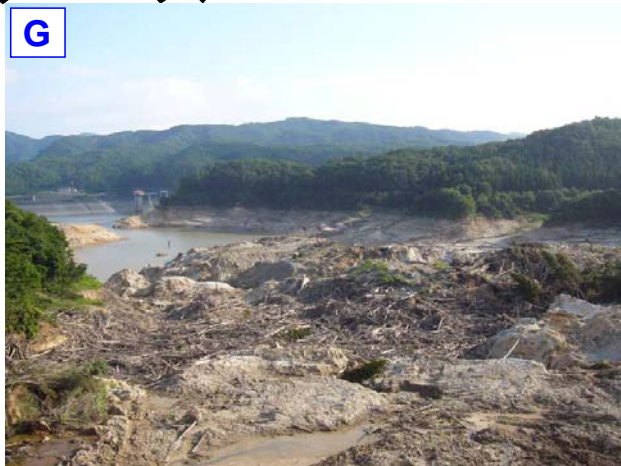
大規模地すべり末端部は二次すべりが発生し、地すべり土塊は乱れている (H20.8.9)
