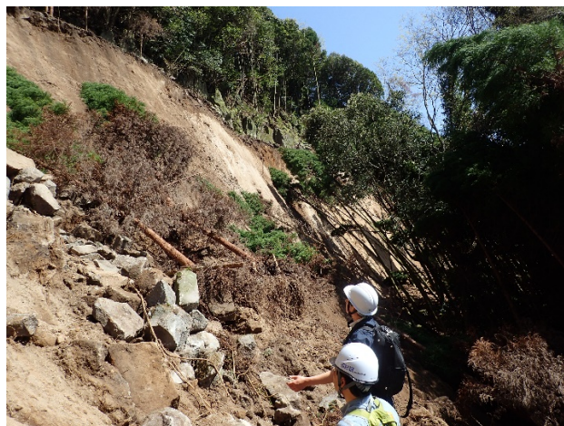
崩壊頭部の調査
