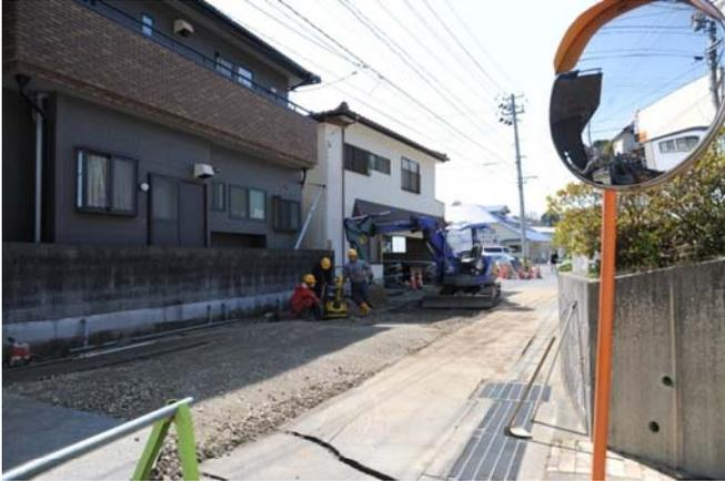
補修中の段差が生じた道路。奥の民家の基礎地盤にも段差が生じており、民家は半壊。写真の奥側(北西側)が約20cm沈下。
