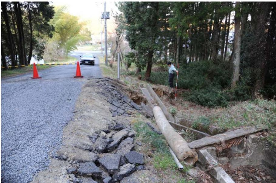
道路を通過する地表地震断層。道路と基礎地盤の段差。写真の手前側(南西側)が約50cm沈下。
