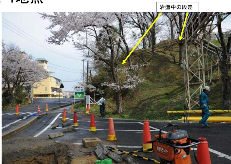
道路面とそれに連続する地山に生じた段差。写真の手前側(西側)が約50cm沈下。
