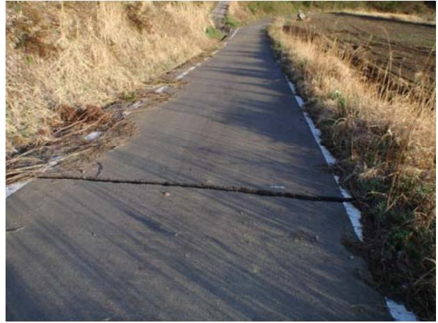
南東を望む。道路面に見られる開口亀裂。約10m間隔で4条、累積開口量15cm。垂直変位は見られない。
