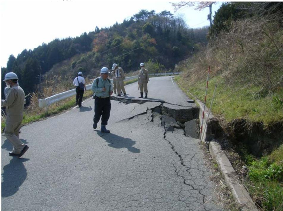
西を望む。走向N55E、垂直変位60cm、右横ずれ10~30cm(移動地塊が回転している可能性)。
