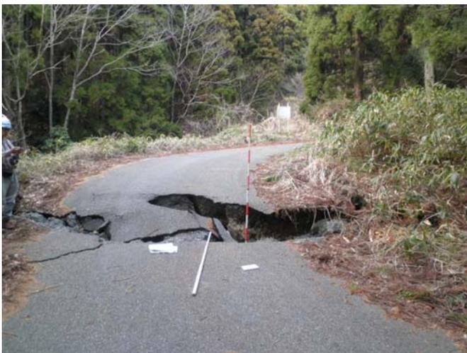
西側カーブ、北を望む。走向N61W、垂直変位量30cm以上。開口亀裂40cm。
