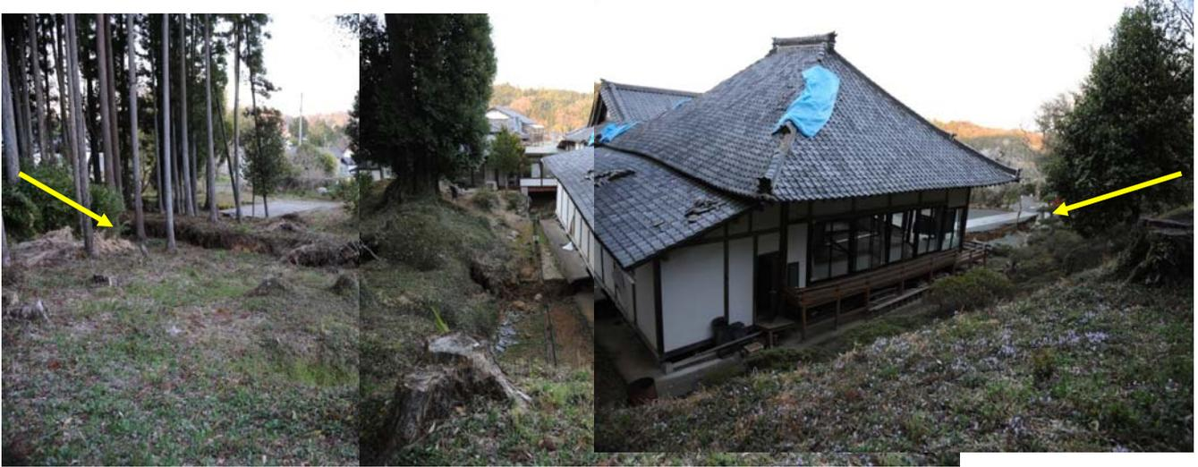
寺の本堂を通過した地表地震断層。本堂は手前側に傾斜しているが、屋根瓦はあまり落下していない。写真の左端の樹木の後ろに倒壊した山門がある。
