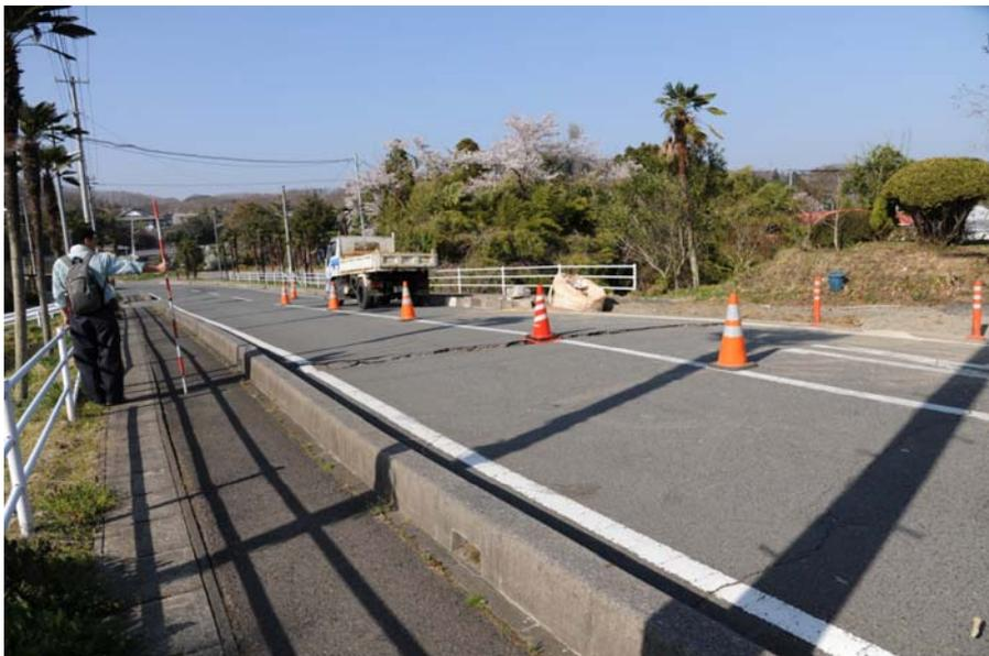
道路面の亀裂と段差。写真の手前側(南側)が約5cm沈下。
