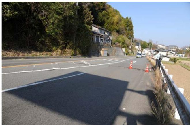
道路面の亀裂。手前側が沈下しているが、とう曲状にたわんでいるため、正確な変位量は不明。
