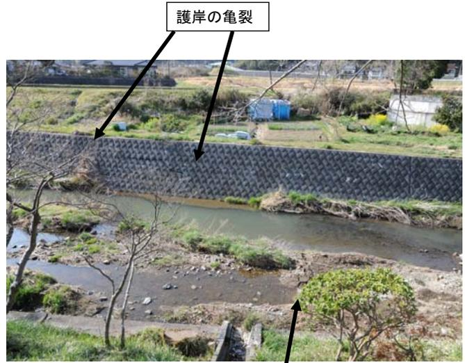
河床に生じた地割れと護岸の亀裂。
