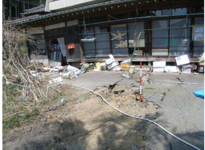
北を望む。とう曲幅2m、垂直変位量西落ち60cm。右手の開口亀裂は開口幅30cm、右ずれ5cm。
