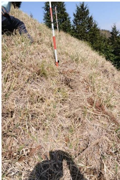
ポールとポールの間に地割れが生じている。
