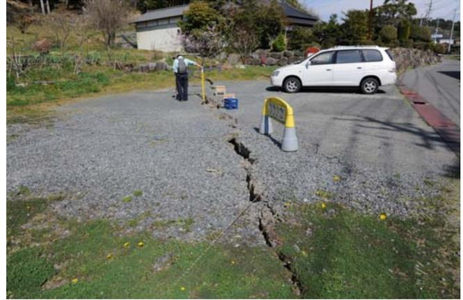
右の写真の道路の北東側に連続する段差のある地割れ。写真の左側(北西側)が約25cm沈下。
