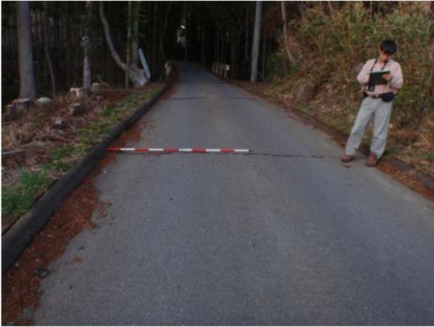
北東を望む。道路面に見られる開口亀裂。約7m間隔で3条、累積開口量6cm、累積横ずれ量左ずれ12cm。垂直変位は見られない。
