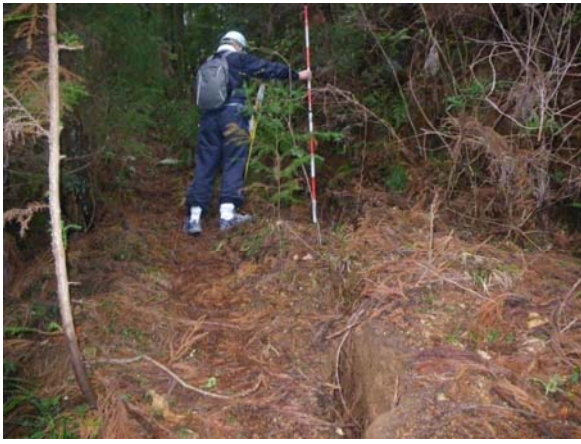
林道に出現した段差。北を望む。走向N20W。垂直変位量20cm程度。 延長方向への連続性は不明瞭。
