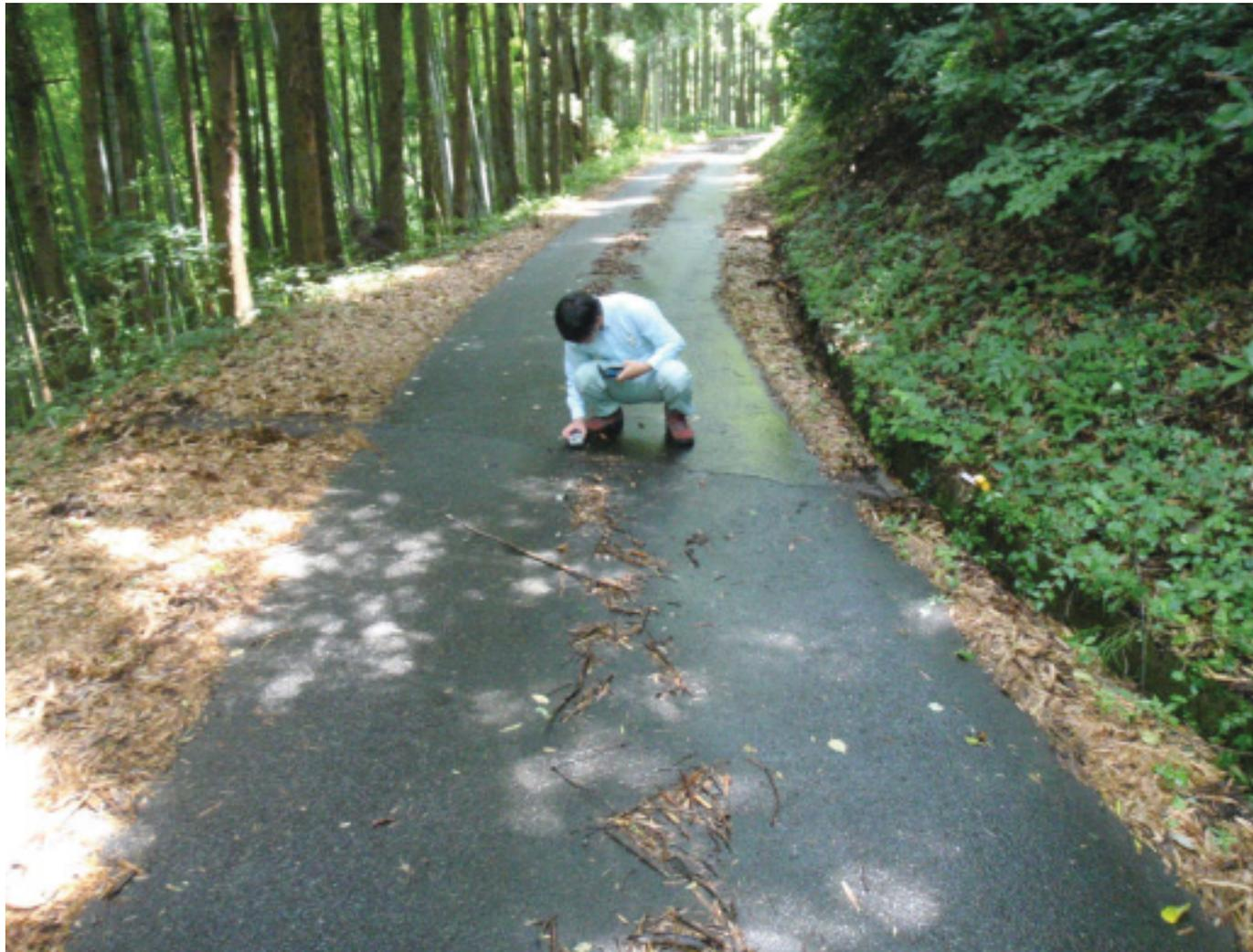
南を望む。亀裂の走向N55E、開口幅0.6cm、開きの方向N45W。
