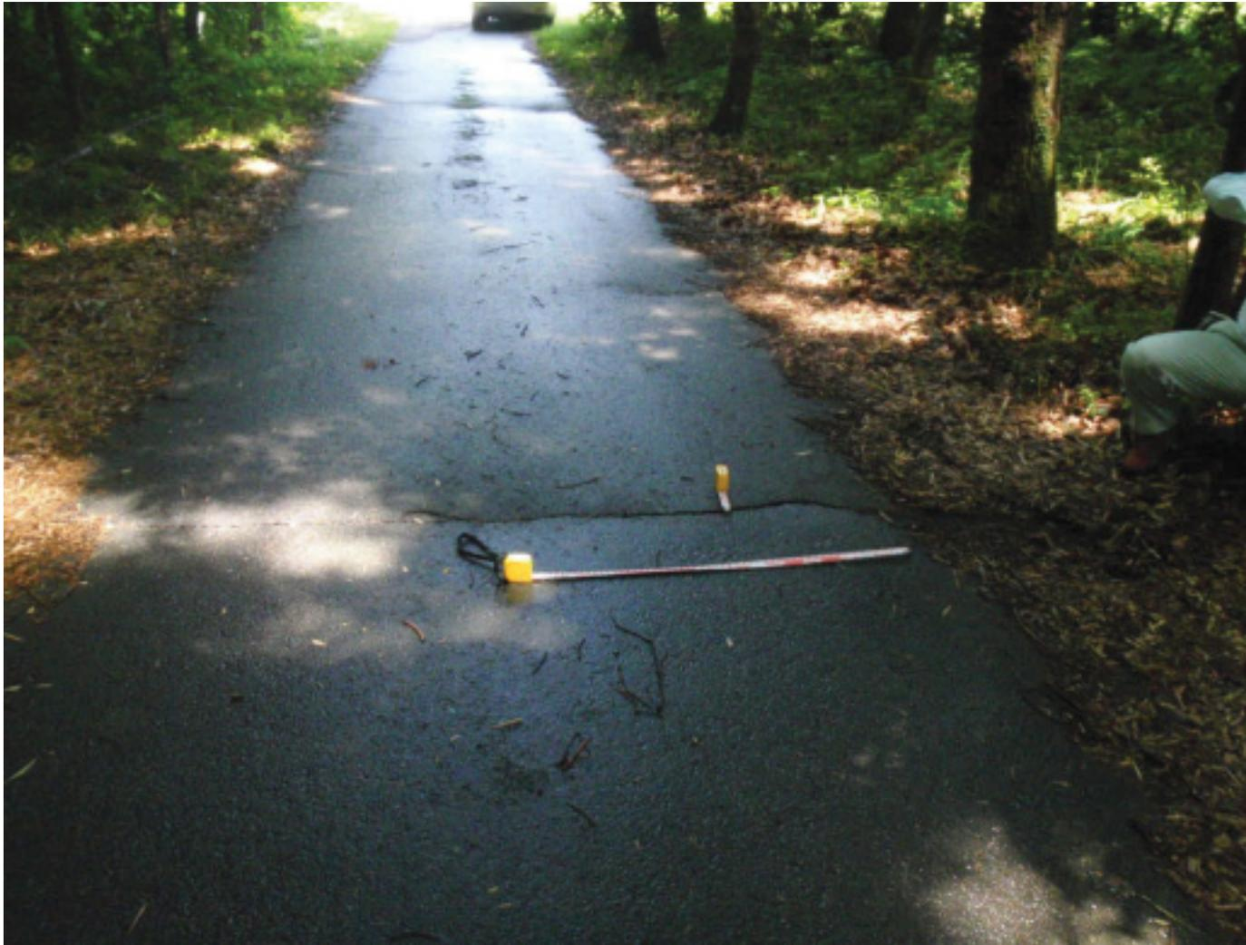
東を望む。亀裂の走向N10E、開口幅0～1cm。
