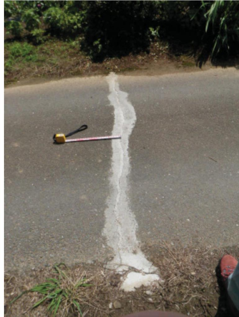
谷底平野。IdW-19地点の東方約70m。南を望む。亀裂の走向N5W、開き2cm(セメントで補修済み。)
