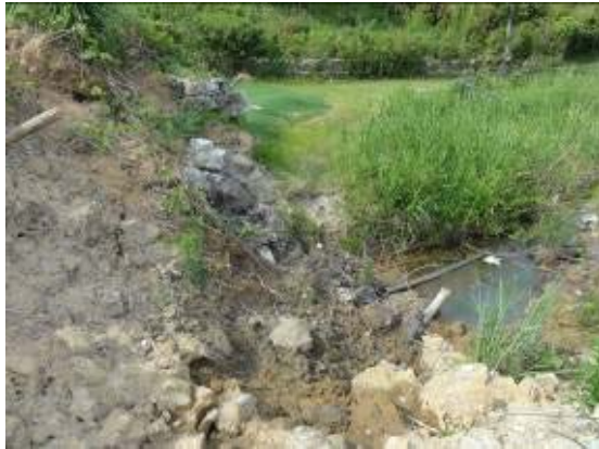
写真-10.21 崩壊下部の側方の状況 (公園内の周囲ののり尻部がふとんかごで補強されている)
