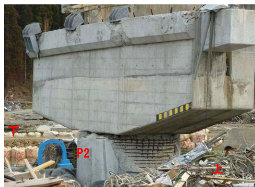
写真-9.124 P 2 橋脚の損傷状況
