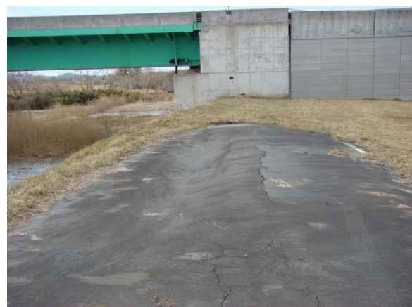
写真-9.56 A 2 橋台付近の液状化痕跡
