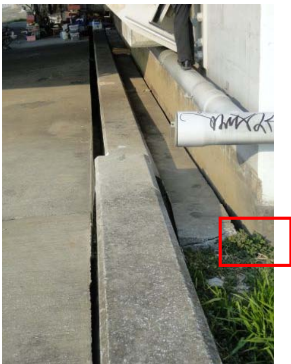
(g) 橋台前面・側面と周辺地盤の間に生じた隙間
