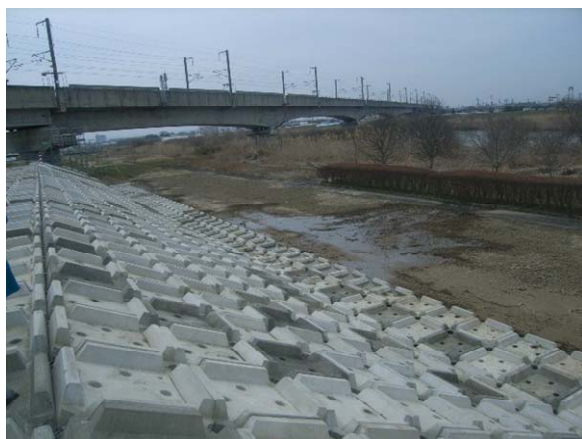
写真-6.51 護岸下部からの水のしみ出し
