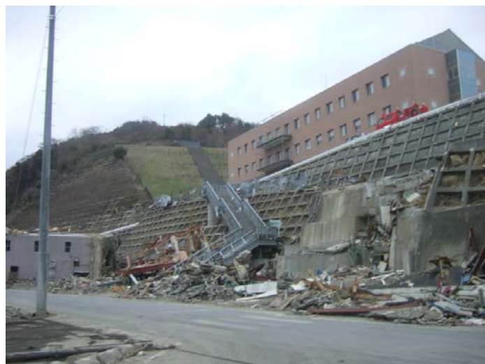
写真-4.5.15 津波避難用鋼製階段
