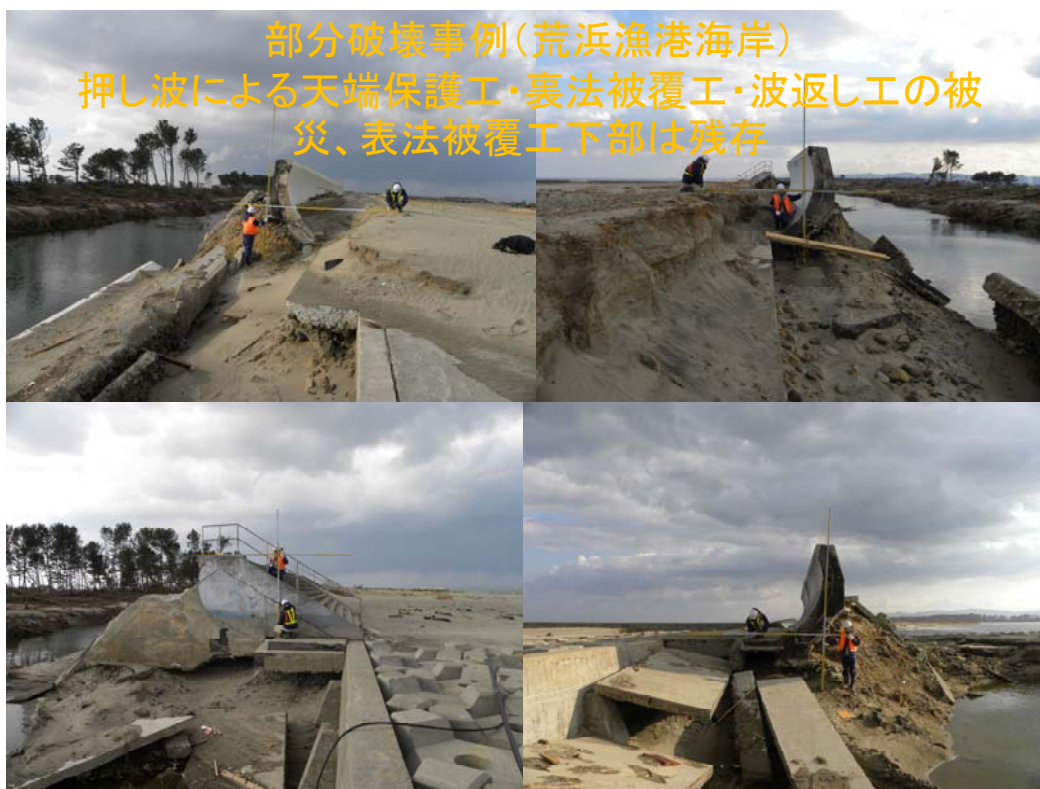
図-5. 4. 54 表法被覆工下部残存（荒浜漁港海岸）
