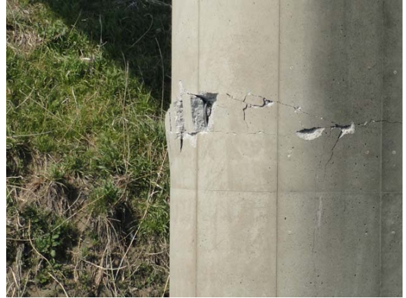
(b) コンクリートの曲げ損傷
