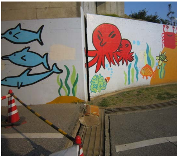
(b) 橋台躯体とそで擁壁との間に生じた隙間
