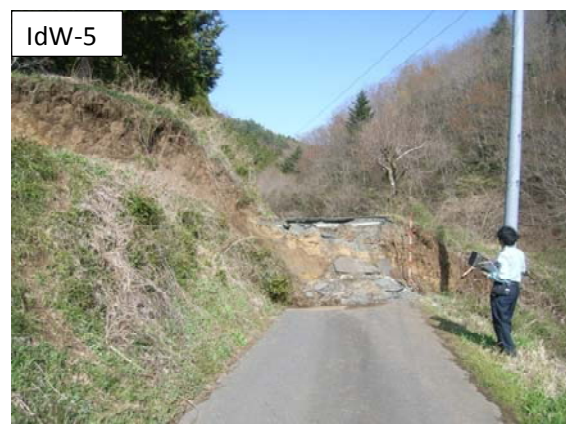
東を望む。道路および斜面の変状。断層走向傾斜 N13E75W、垂直変位量190cm。
