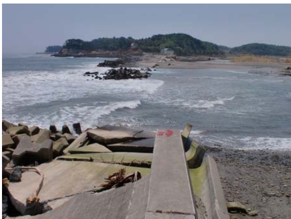
写真-5.4.105 破堤・全壊と海岸線後退
