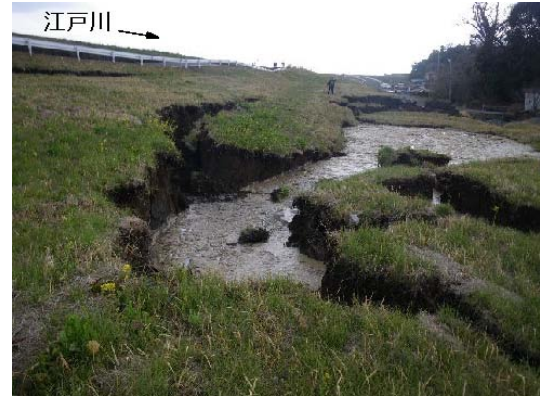
写真-6.95 裏のり尻付近の亀裂と高含水の粘性土 (関東地方整備局提供)
