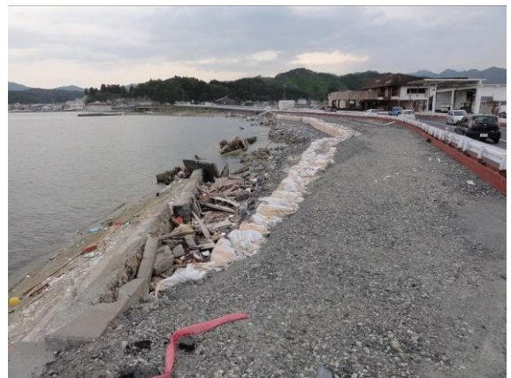
写真-10.61 擁壁の倒壊 (山田町山田) (津波が擁壁の上端を越え、擁壁が倒壊した)
