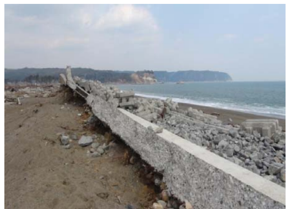
写真-5.4.21 海側堤防の被災状況
