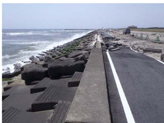
写真-5. 4. 138 護岸天端被災（野手海岸）
