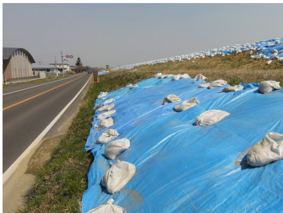
写真-6.3 裏のり尻部の噴砂痕（ブルーシートの下に複数の縦断亀裂）
