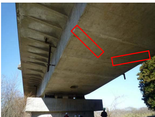
写真-9.15 箱桁の斜めひび割れ（底面）
