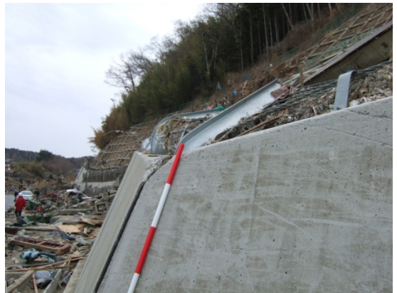
写真-4.5.8 擁壁工擦過痕
