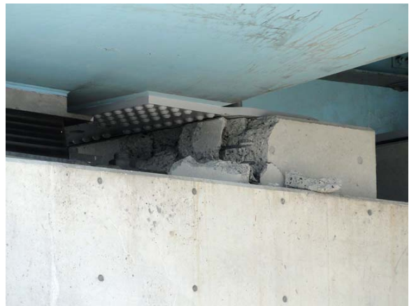
写真-9.41 上り線の P 5 橋脚の変位制限構造の損傷状況
