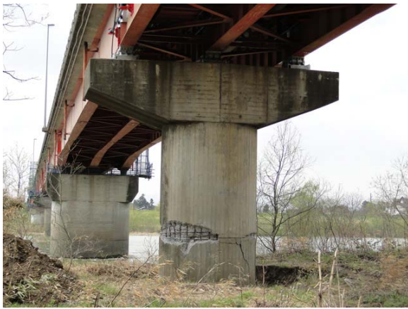
写真-9.107 藤橋の P 6 橋脚の段落し部の損傷
