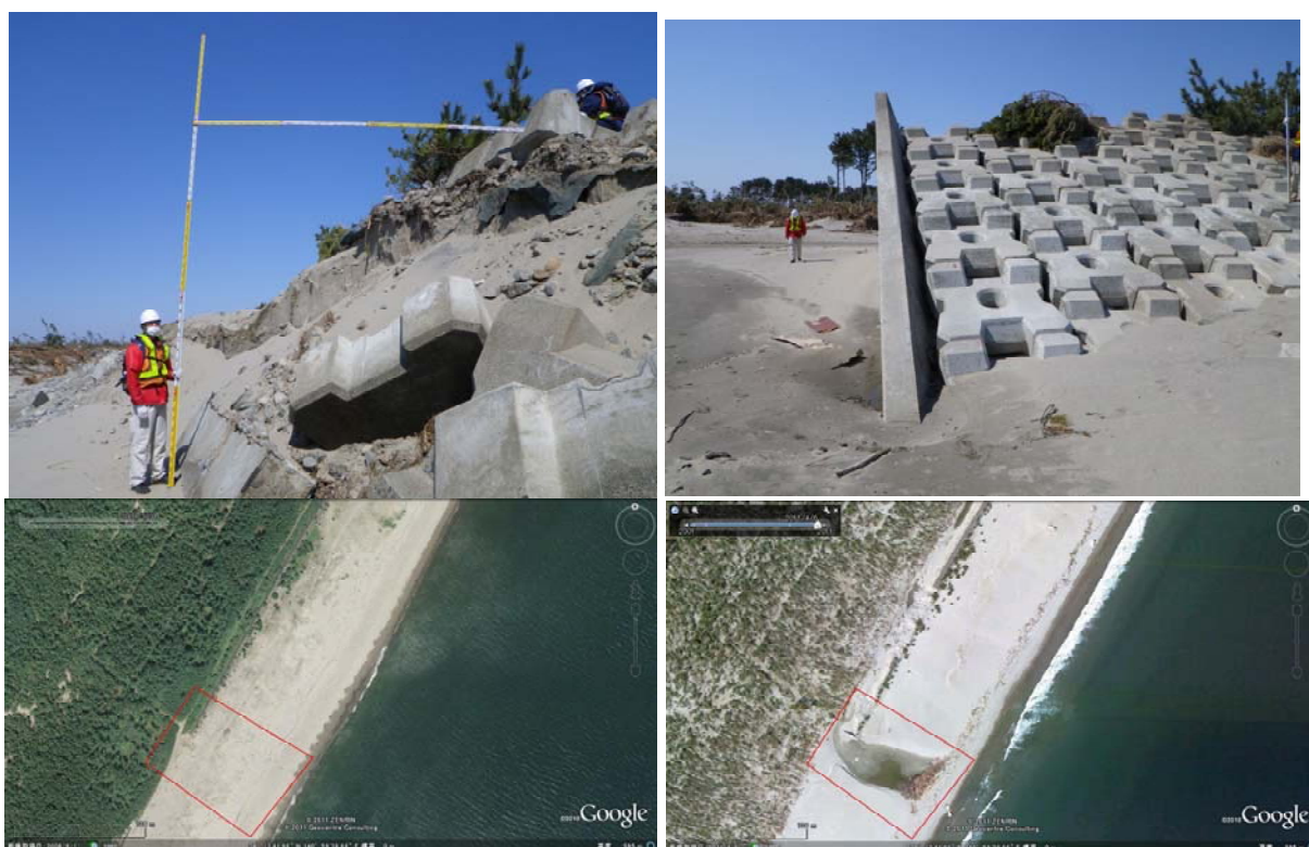
図-5.4.32 堤防施工端の流路跡
