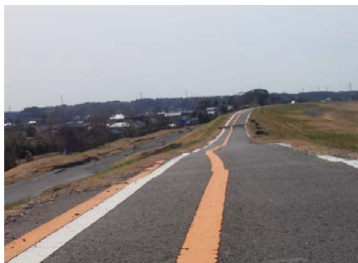
写真-6.63 天端の沈下(関東地方整備局提供)
