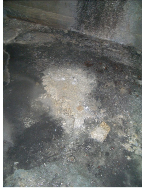
写真-7.15 継目排水孔からの流出物と思われる 堆積物(今回の地震によるものかは不明) (蔵王ダム)
