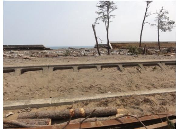
写真-5.4.19 陸側堤防から見た海側堤防被災箇所(堤防高が異なっている)
