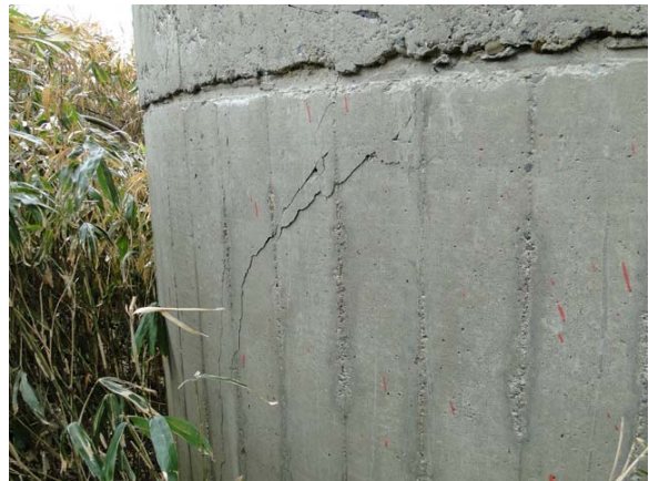
写真-9.108 藤橋の P 5 橋脚の損傷
