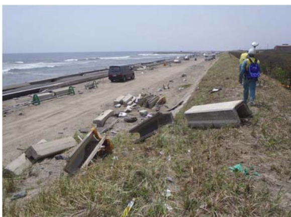
写真-5. 4. 140 護岸天端被災（野手海岸）
