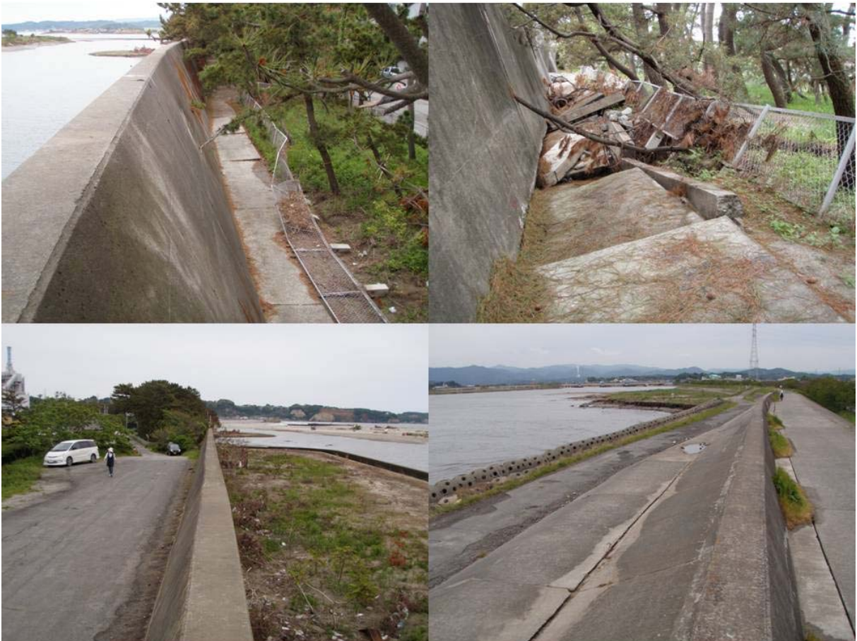
図-5.4.72 高い直立堤区間でも一部で法尻被覆工が沈下。背後地盤が高くなった区間では被災なし(植田佐糠地区海岸)
