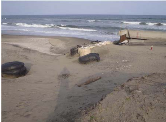
写真-5.4.147 護岸施工端被災（木戸海岸）
