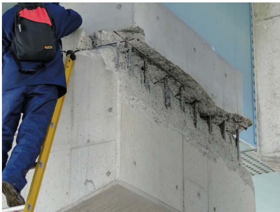
写真-9.41 上り線の P 5 橋脚の変位制限構造の損傷状況
