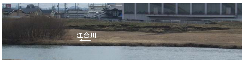
写真-6.44 表のり下部の崩壊(高橋章浩東京工業大学大学院准教授提供。対岸より撮影)
