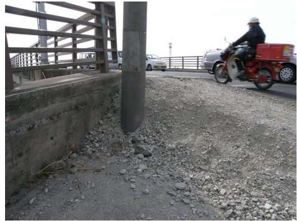
写真-9.156 橋台背面段差(左岸A 2側)
