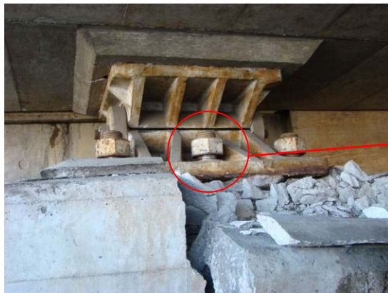
写真-9.34 アンカーボルトの引き抜き (上り線A 2 橋台)
