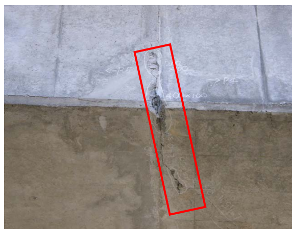
写真-9.16 箱桁の斜めひび割れ、欠け落ち
