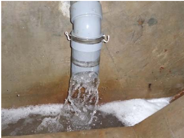
写真-7.8 継目(J8)排水状況(月山ダム)
