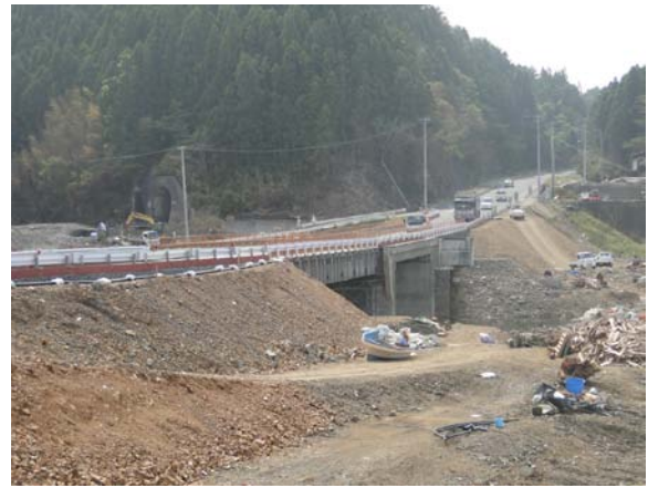
写真-9.139 応急復旧橋設置状況 (6月4日撮影)
