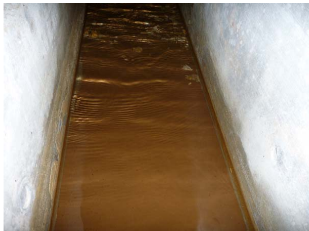
写真-7. 17 監査廊内排水溝の茶褐色のシルト状 堆積物(小山ダム)
