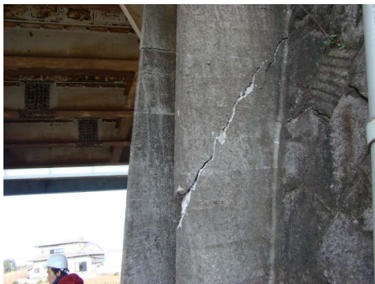
写真-9.30 A 1 橋台左側面のひび割れ
