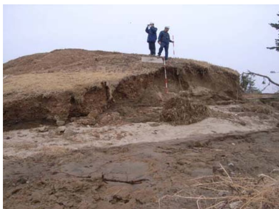
◆河口市：堤防先端部分の侵食状況
