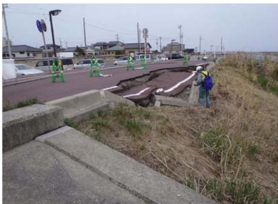
写真-5. 4. 133 天端表法被災（飯岡海岸）
