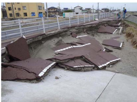
写真-5. 4. 134 天端表法被災（飯岡海岸）
