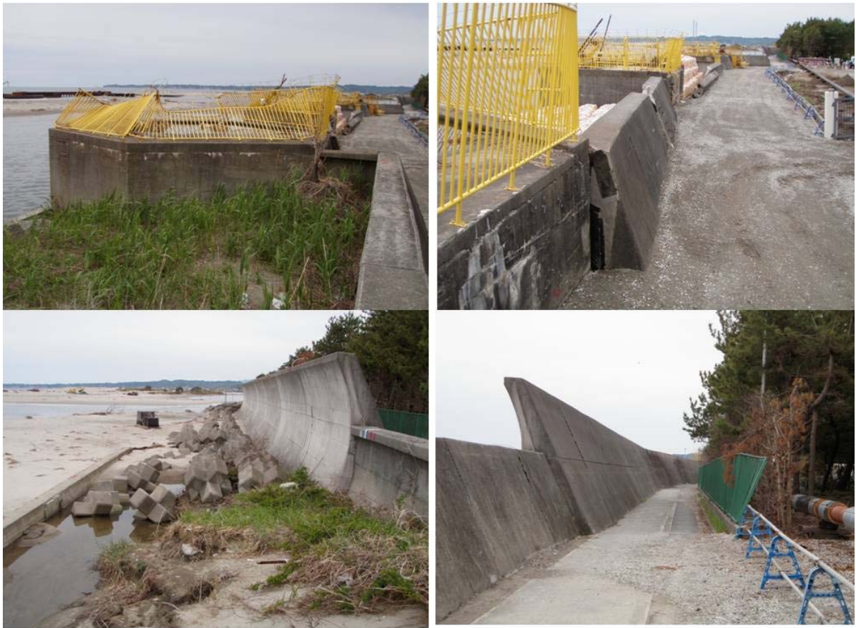
図-5.4.71 堤防高が変化。直立堤倒壊は低い直立堤の区間で発生。(植田岩間地区海岸)
