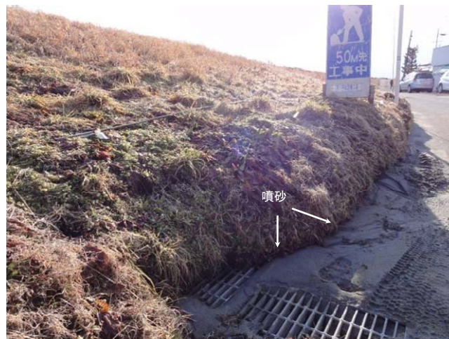
写真-6.42 裏のり尻のはらみ出しおよび噴砂
