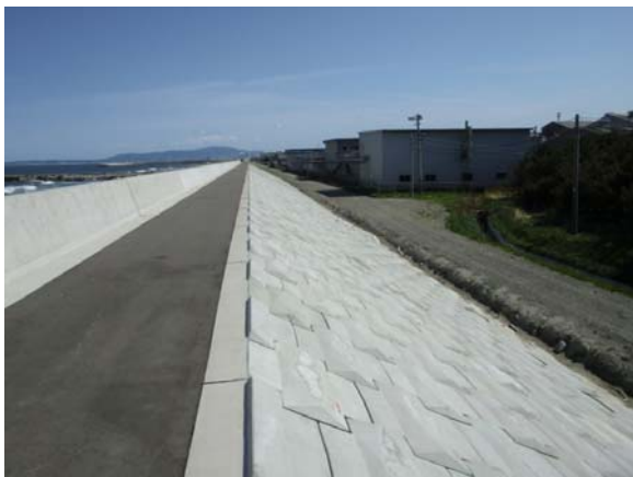
写真-5.4.1 連節ブロック裏法被覆工
