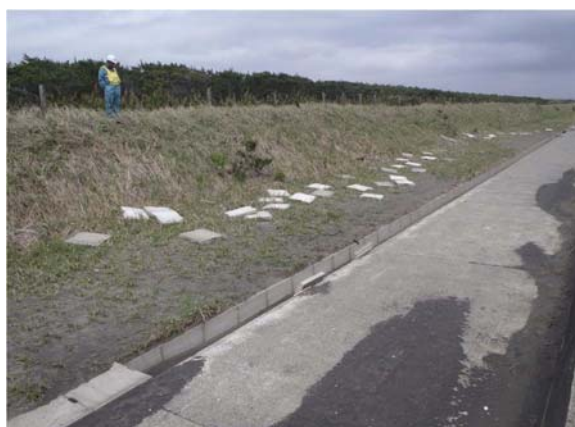
写真-5. 4. 155 護岸裏排水溝蓋散乱（東浪見）
