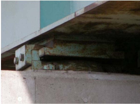
写真-9.166 P 1 橋脚 G 1 桁支承：固定 支承とみられるが、大きな 変状はない
