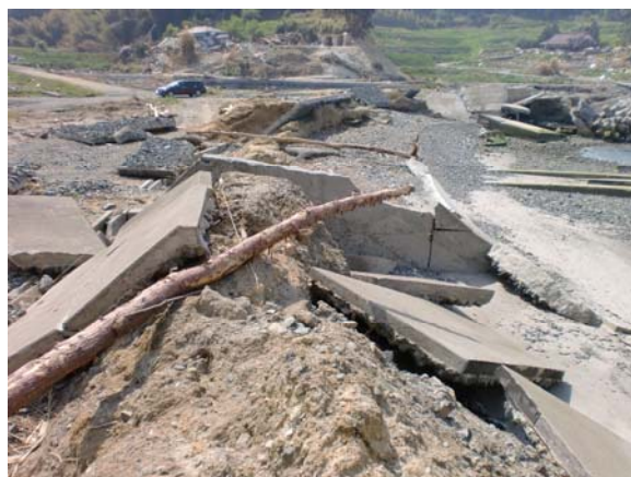
写真-5.4.108 堤防の全壊・破堤状況
