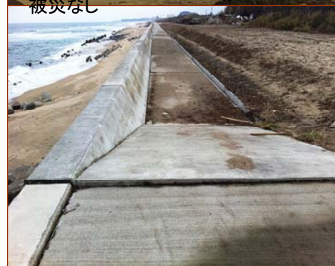
写真-5. 4. 129 天端の沈下・ずれ
