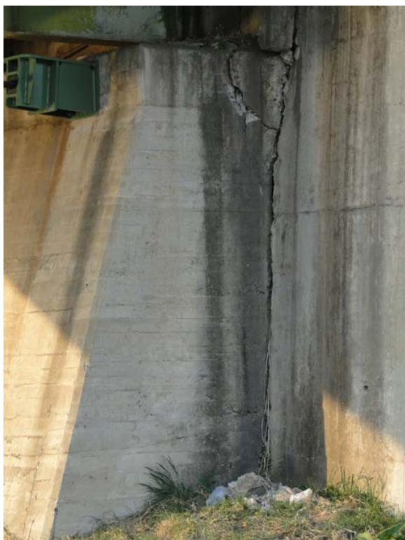
写真-9.102 A 1 橋台下流側ひび割れ部
