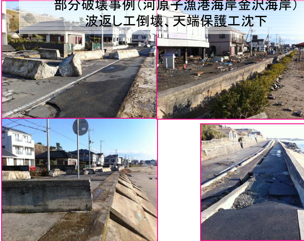
写真-5. 4. 125 波返し工倒壊（金沢海岸）
