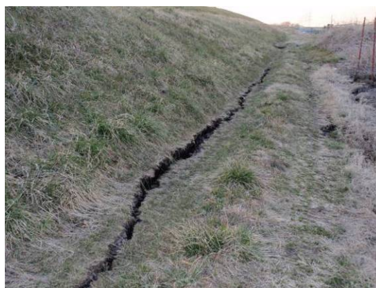
写真-6.81 裏小段の亀裂(関東地方整備局提供)
