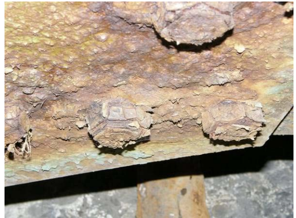
写真-9.163 主桁と横鋼接合部の腐食状況
