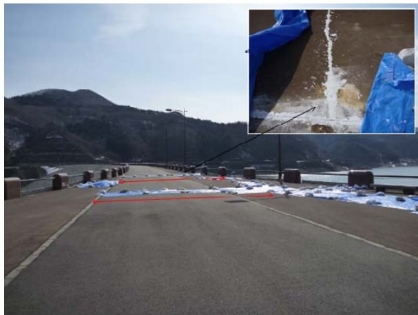
写真-7.1 ダム天端の左岸取付け部における クラック (摺上川ダム)
