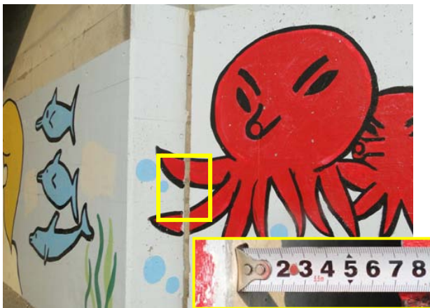
(c) 橋台躯体とそで擁壁との間に生じた隙間 拡大写真(たこの足の部分の隙間：約 7cm)
