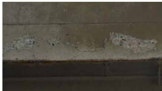
(j) 床板裏側の剥離部拡大写真
