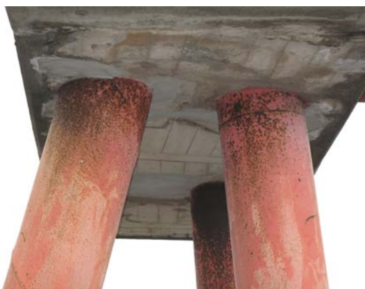
写真-9.62 上横梁の下面（補修痕有り）
