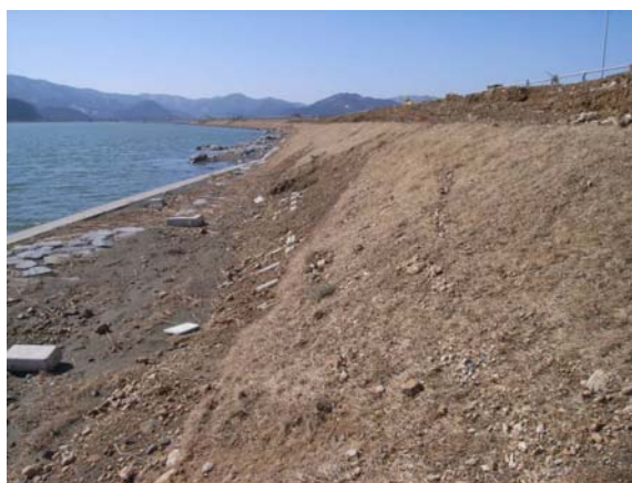
◆川側のり面の侵食：覆土下から護岸ブロックが露出
