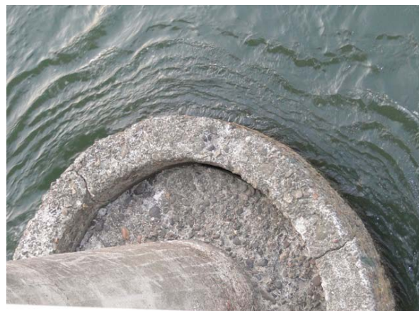
写真-9.93 P 4 橋脚のケーソン基礎(上流側)の天端の状況(路面から望遠撮影)
