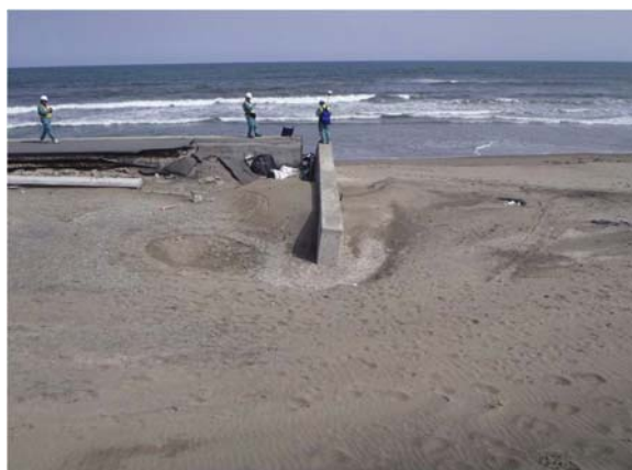
写真-5. 4. 144 護岸施工端被災（川辺海岸）
