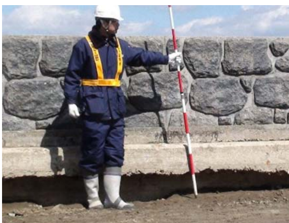
写真-6.11 パラペット背後の沈下
