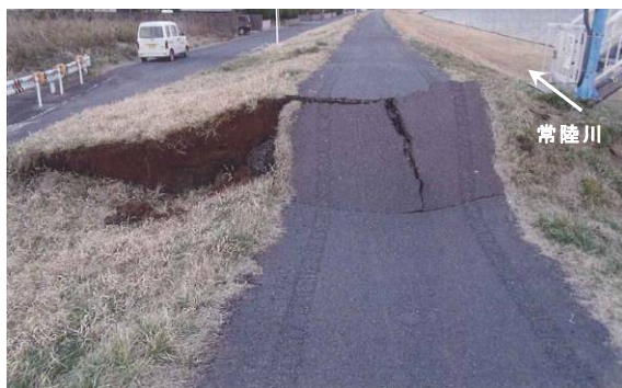
写真-6.67 天端の沈下および縦断亀裂(関東地方整備局提供)
