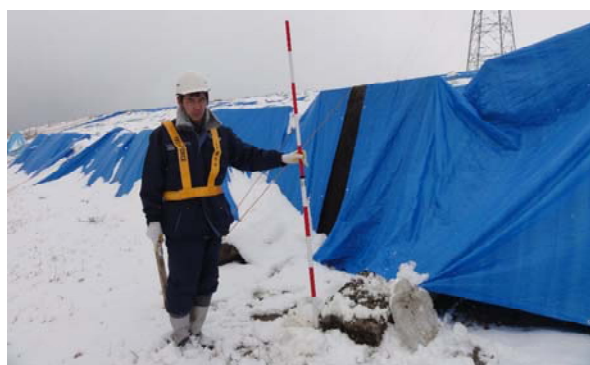
写真-6.55 護岸下部の前傾
