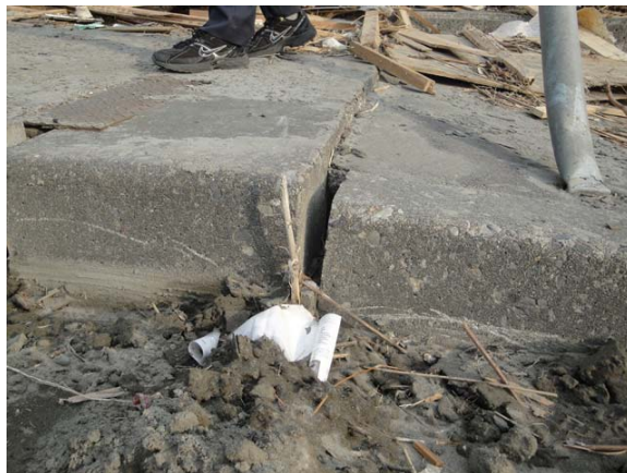
写真-9.142 橋台背面土の沈下による段差 (A 1 橋台周辺の歩道部)
