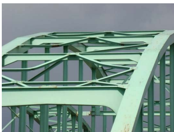
写真-9.47 上横溝座屈（遠景）
