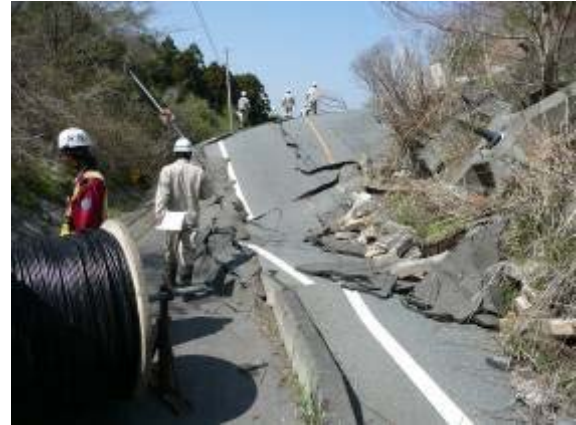
写真-10.42 末端部の路面の隆起
