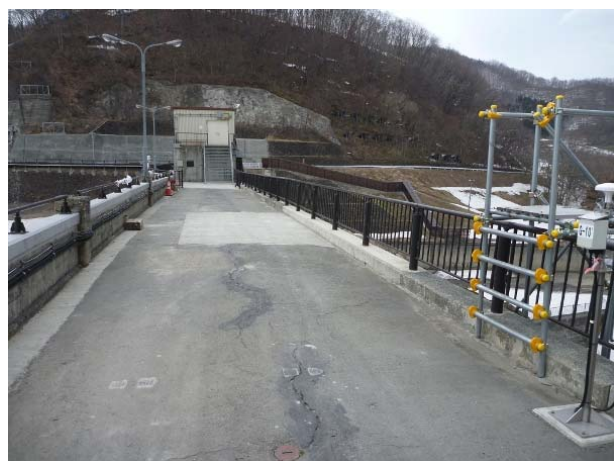
写真-7.4 石淵ダム天端(今回(2011年)の地震) *舗装の補修跡は2008年の地震によるもの
