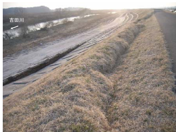
写真-6.26 護岸上部の沈下および表のり肩付近の沈下
