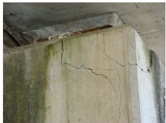
写真-9.35 橋脚のひび割れ (左：上り線P 1 4 橋脚、右：上り線P 1 7 橋脚)
