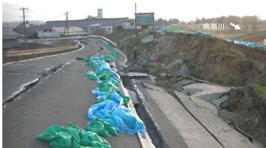
写真-6.18 堤防および道路盛土の崩壊
