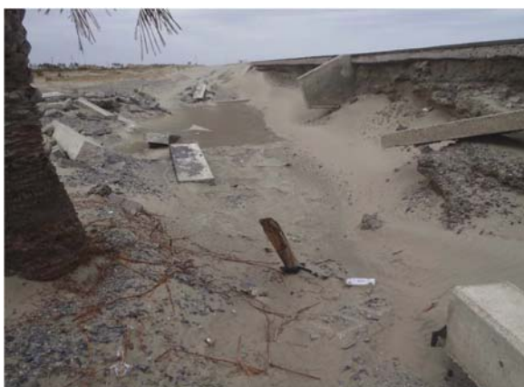
写真-5. 4. 152 護岸裏法被災（白幡海岸）
