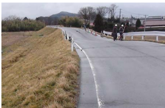
写真-6.29 天端の沈下
