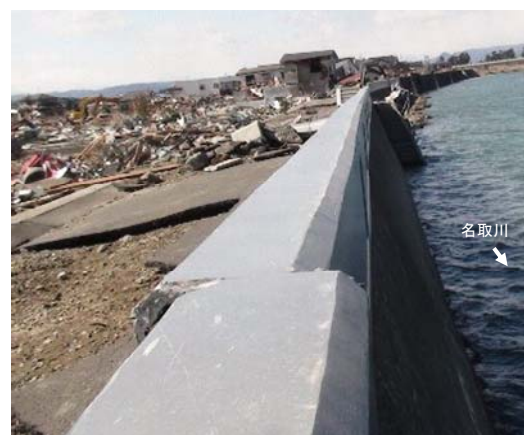
写真-6.12 パラペットの目地ずれ
