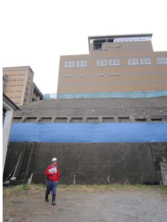
写真-4.4.6 擁壁工、のり砕工、積ブロック（擁壁に特に異常は見られず）
