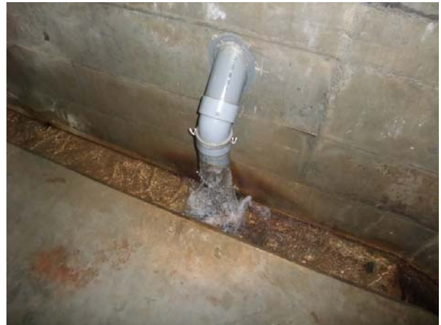
写真-7.9 継目(J17)排水状況(月山ダム)
