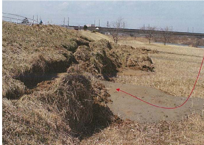
写真-6.45 表のり尻部の噴砂(東北地方整備局提供)
