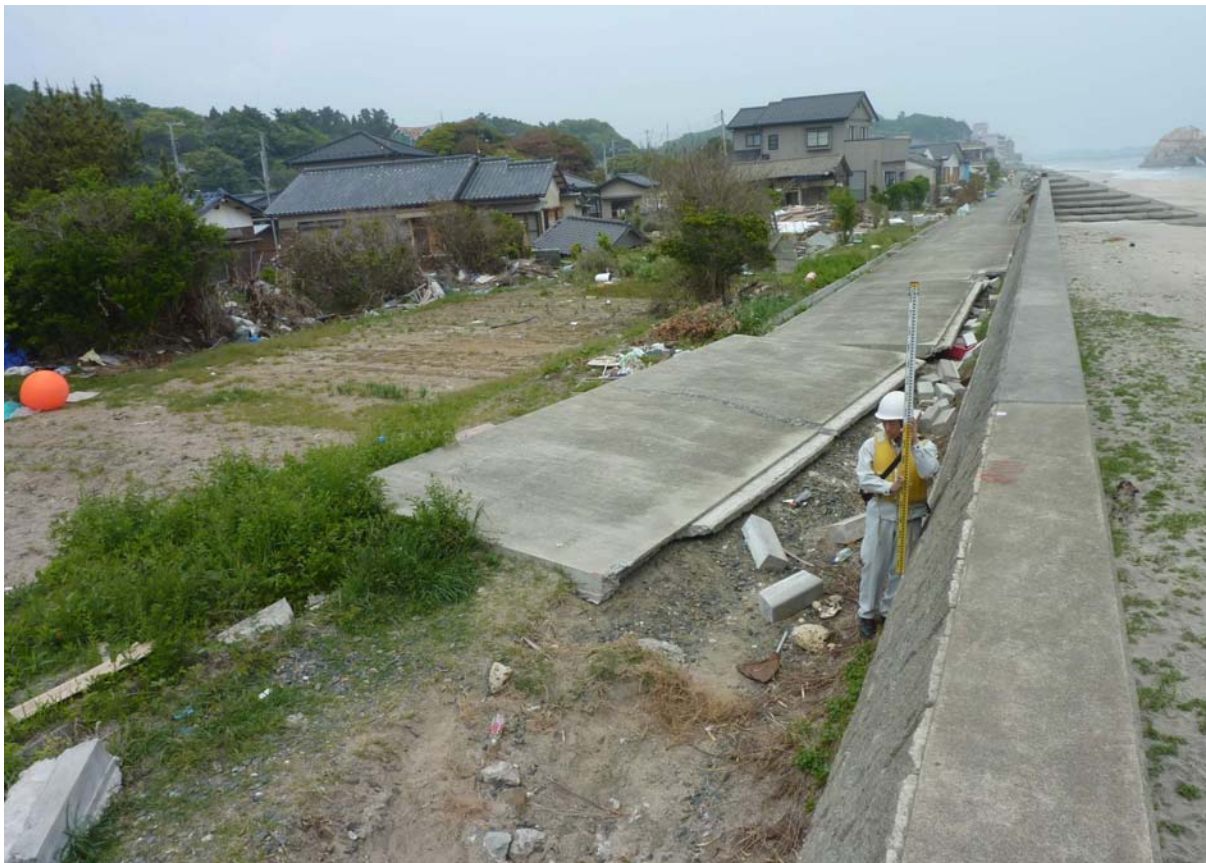
写真-5. 4. 127 天端保護工ずれ（磯原海岸）
