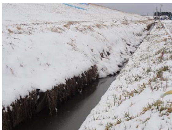
写真-6.53 裏のり尻部の水路内に落下した土砂
