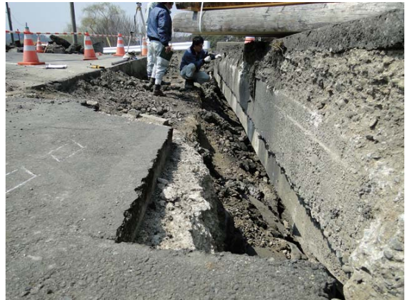
写真-9.87 橋台背面の補修の状況
