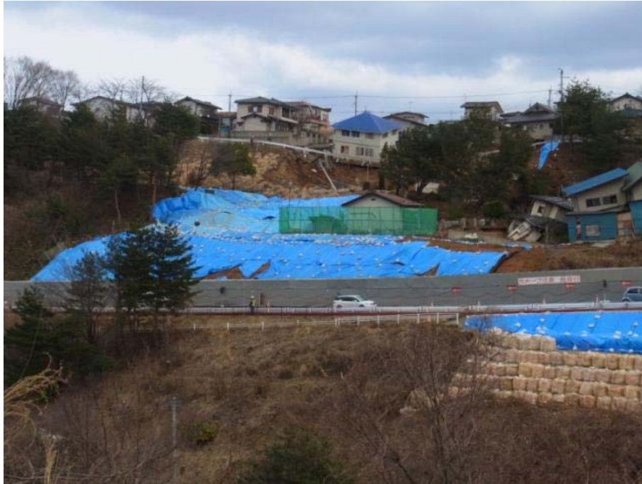
図-2.7 住宅地の谷埋め盛土の崩壊（国道4号沿い、福島市伏拝）
