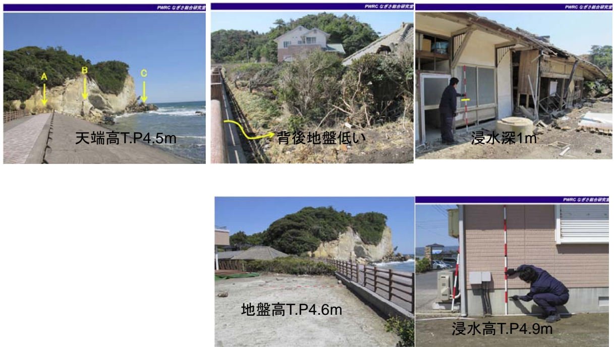
写真-5. 4. 132 地盤高による被害の違い（写真提供：（財）土木研究センターなぎさ総合研究室）
