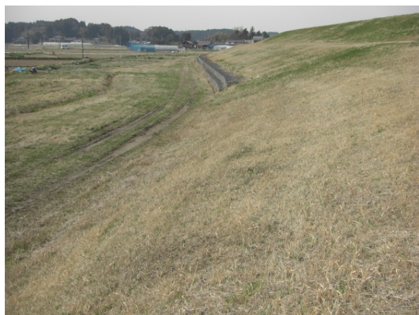
写真-6.102 対策区間（写真奥ののり尻にドレーンが設置されている区間）
