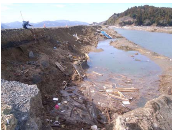
◆堤内側への越水によると考えられるのり面の侵食と落堀の形成
