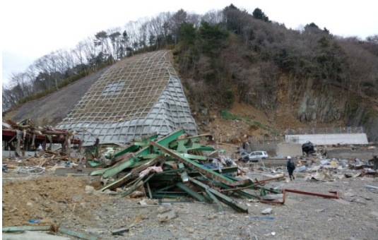
写真-4.5.1 法枠工右側の崩落（女川町）
