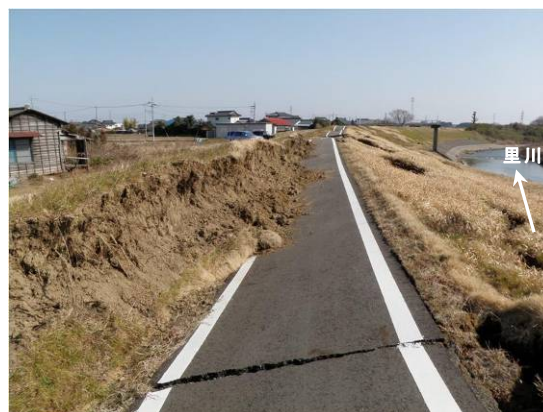
写真-6.58 裏のり肩の段差を伴う天端の沈下(関東地方整備局提供)
