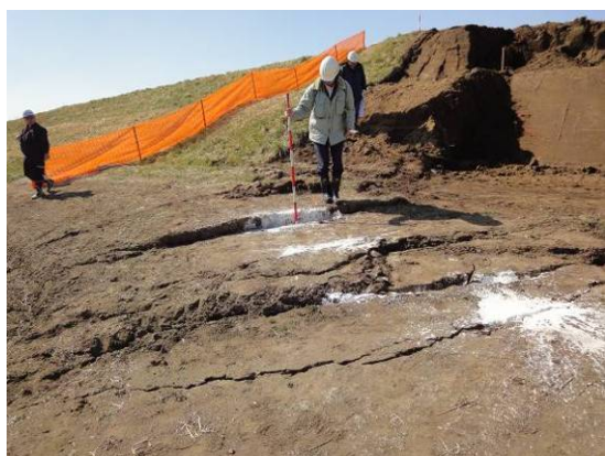
写真-6.82 裏のり尻付近の亀裂
