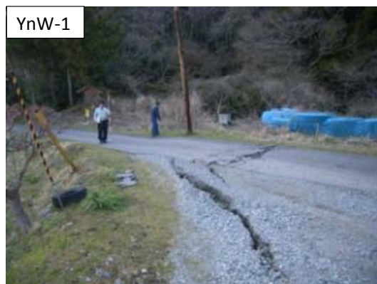
西を望む。道路面に亀裂、若干南にたわんでいるように見える。
