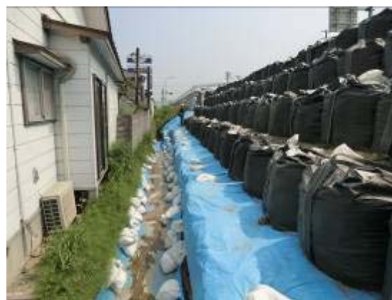
写真-10.29 のり尻部の状況 （近傍の家屋には変状は見られない）
