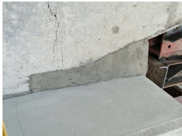
(b) はり部の下端部のコンクリートによる補強
