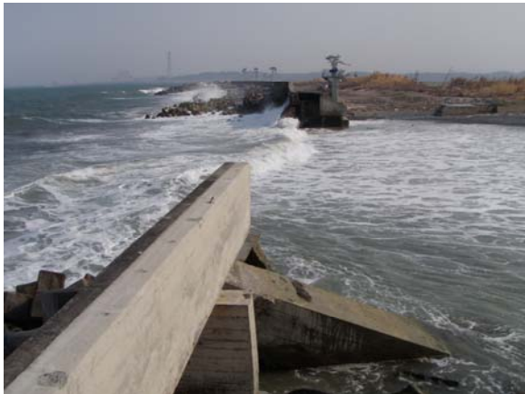
写真-5.4.115 破堤・全壊、海岸線後退
