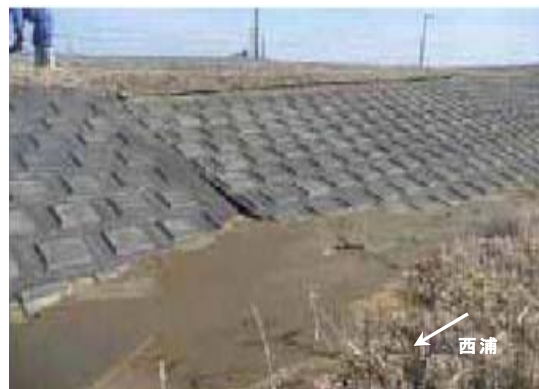
写真-6.76 表のり護岸の変状および噴砂痕(関東地方整備局提供)
