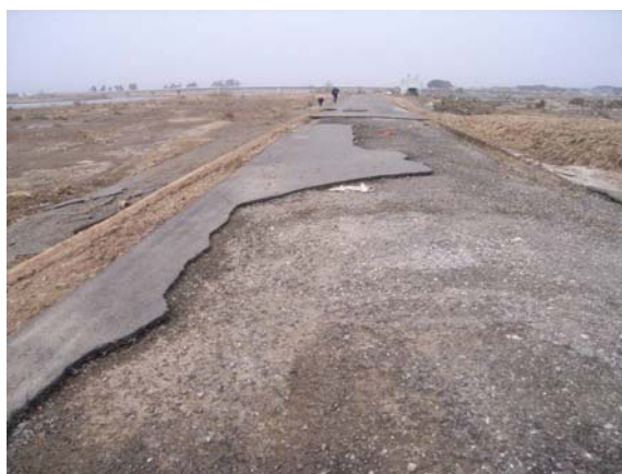
◆天端のアスファルト舗装が剥離し、川側（写真左側）へ流送されていた。
