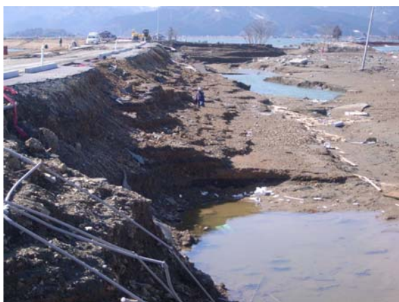
◆堤内側への越流によると考えられるのり面の侵食と落堀の形成
