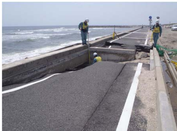
写真-5. 4. 142 護岸天端被災（野手海岸）
