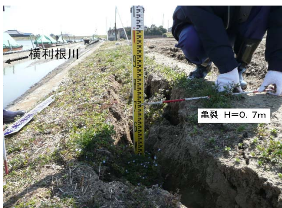
写真-6.73 天端に生じた亀裂(関東地方整備局提供)
