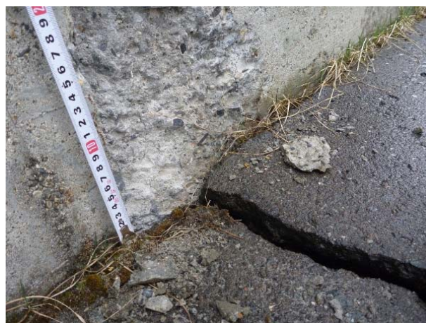
写真-7.6 天端舗装の継目の段差(田瀬ダム)
