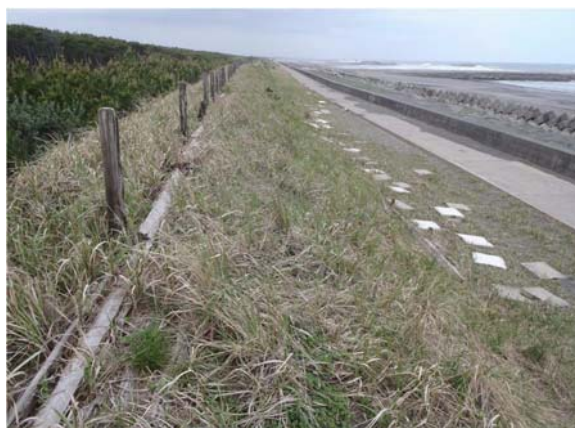
写真-5. 4. 154 護岸裏排水溝蓋散乱（東浪見）
