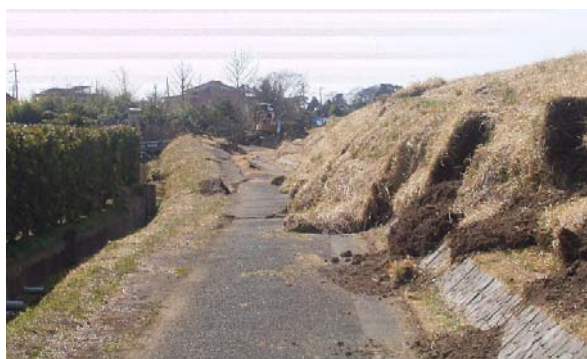
写真-6.65 裏のりの崩壊および裏のり尻部の隆起(関東地方整備局提供)
