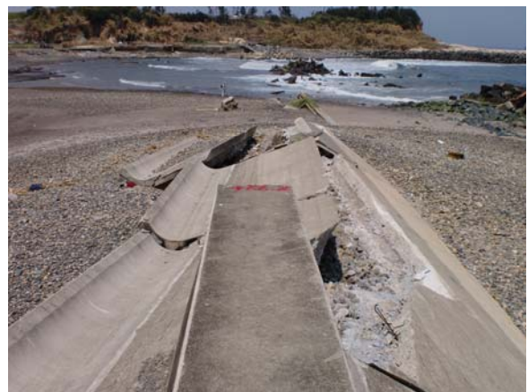
写真-5.4.106 破堤・全壊状況
