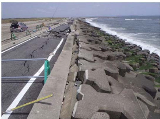
写真-5. 4. 139 護岸天端被災（野手海岸）
