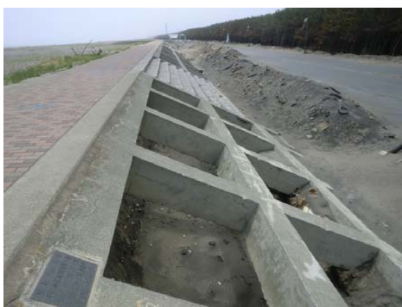
写真-5.4.10 格子枠工裏法被覆工の被災
