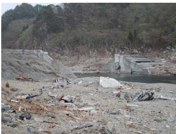
写真-5.4.40 全壊した接待水門
