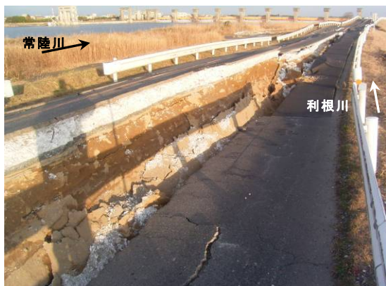
写真-6.61 天端の段差を伴う沈下（関東地方整備局提供）
