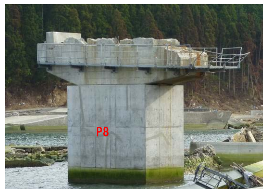
写真-9.126 P 8 橋脚の損傷状況
