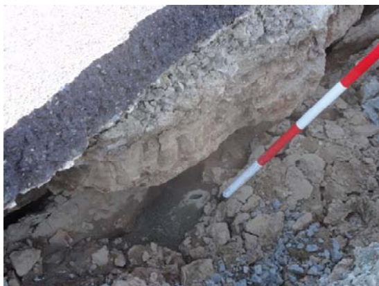
写真-6.9 天端アスファルトの下に見られた噴砂
