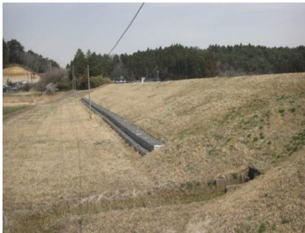
写真-6.106 ドレーン工設置状況
