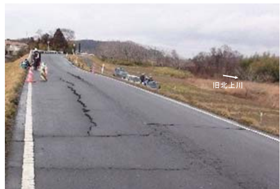
写真-6.30 天端の縦断亀裂
