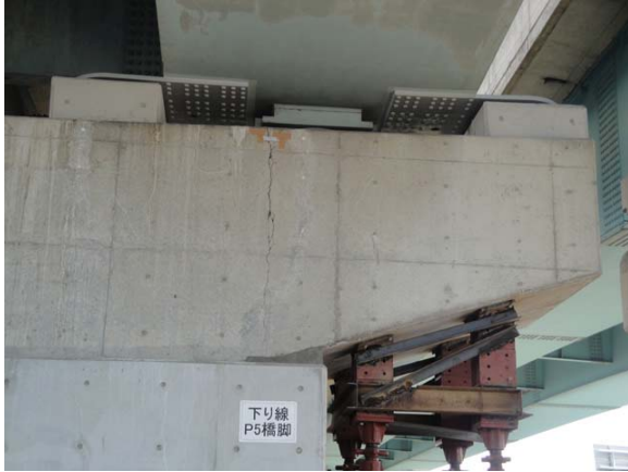
(a) 横ばりの損傷
