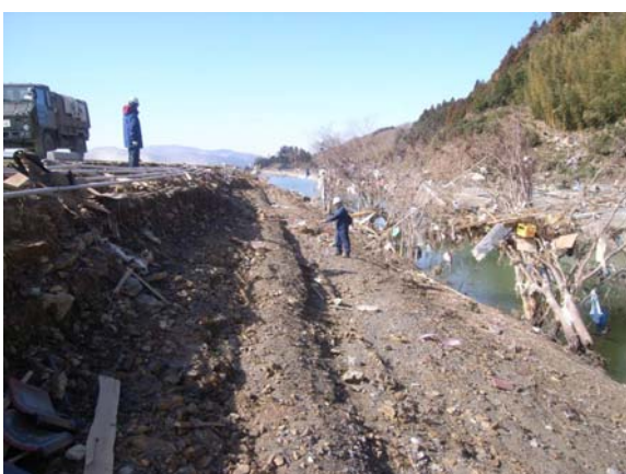
◆堤内側のり面の侵食：のり尻部には山脚・堤防間を流下する水路あり
