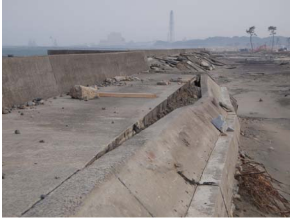
写真-5.4.119 堤防の裏法・天端被災
