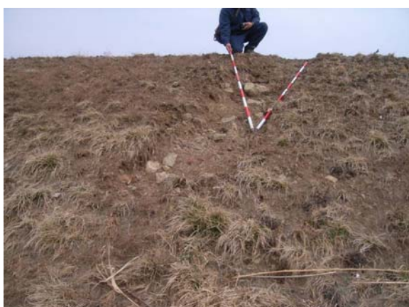
◆川側のり面：植生がのり尻方向に倒伏しており堤内側からの越水を示唆。のり肩部のガリ状侵食は流下物の擦れによる損傷の可能性あり
