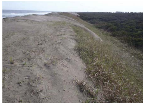
写真-5.4.146 土堤越流していない（川辺海岸）
