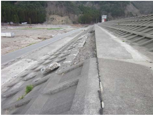
写真-5.4.36 北側堤防小段法肩の被災
