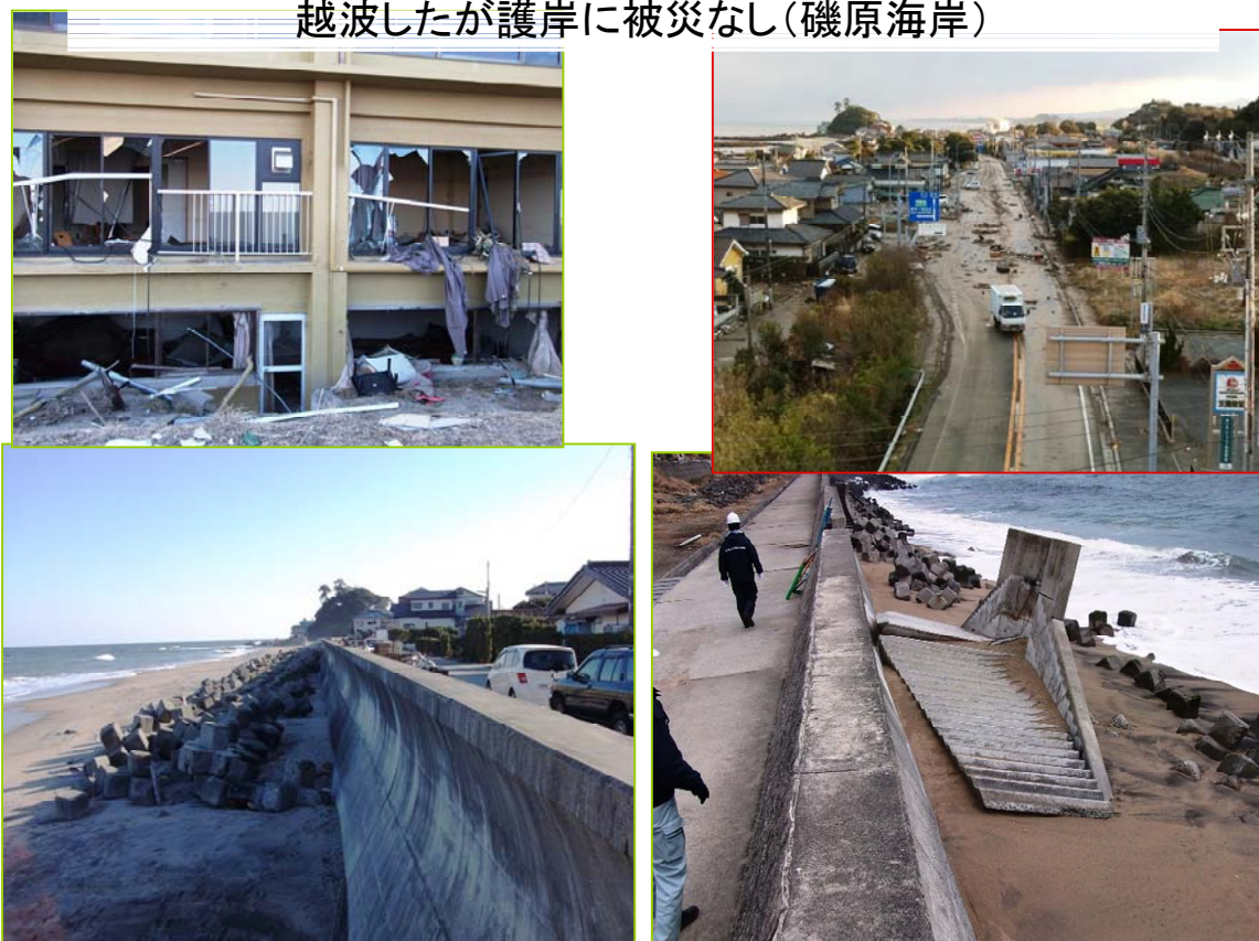
写真-5. 4. 124 被災軽微な護岸背後の被害
