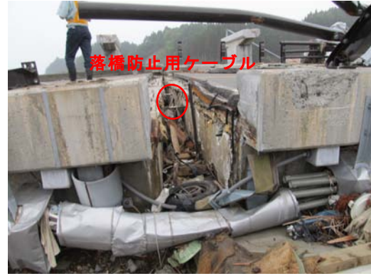
写真-9.130 桁間の落橋防止用ケーブル
