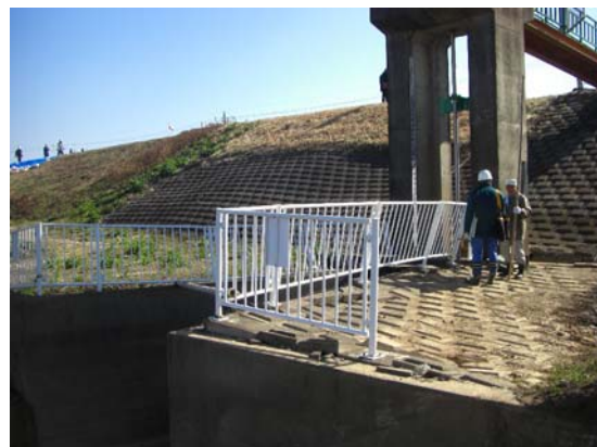
写真-6.90 翼壁天端部の沈下
