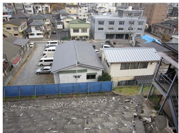
写真-4.4.2 斜面上端から斜面下方をのぞむ（のり砕工の破片が散乱している）
