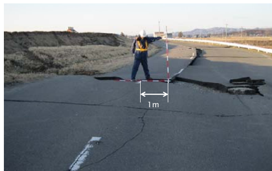
写真-6.8 道路のセンターラインのずれ
