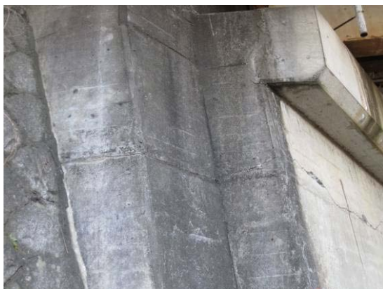
写真-9.28 A 1 橋台右側面のひび割れ
