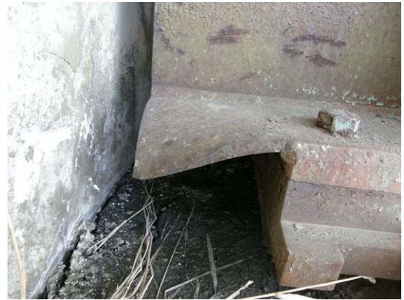
写真-9.171 A 2 橋台上G 1 桁端部の変 形
