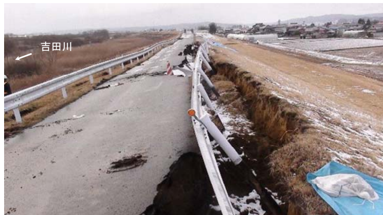
写真-6.23 天端の傾斜・沈下および裏のり肩の縦断亀裂の開口
