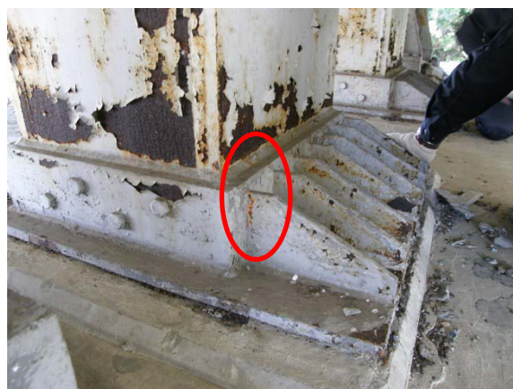
写真-9.12 P 5 橋脚上のストッパー（両方向固定）の塗膜剥がれ
