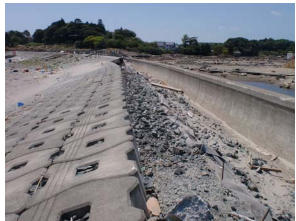
写真-5.4.98 緩傾斜堤天端被災状況
