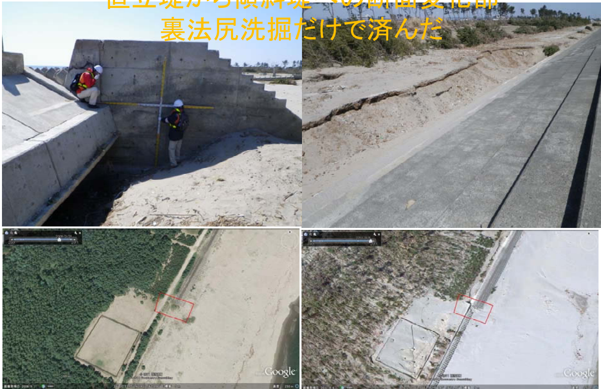
図-5.4.39 断面変化部分だが裏法洗掘で済んだ。隔壁工の効果か。
