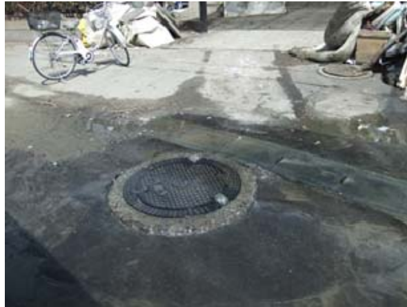
写真-8.6 マンホールからの溢水の状況（宮城県七ヶ浜町内）（資料：国土交通省） ※処理場への導水対策により現地調査時点では溢水は解消していた
