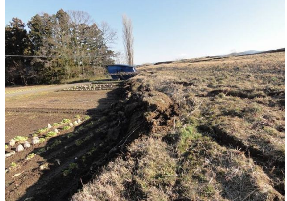
写真-6.5 裏のり尻部に隣接する農地を覆った崩土
