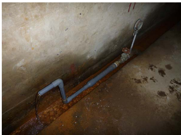
写真-7. 16 基礎排水孔(No. 11)からの漏水 (藤井川ダム)
