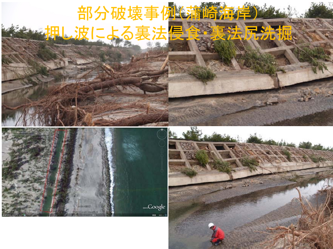
図-5.4.51 裏法尻洗掘・裏法被覆工沈下変形（蒲崎海岸）
