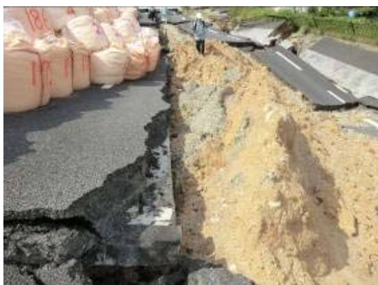
写真-10.19 旧コンクリート舗装盤境 (拡幅盛土部が大きく崩落)
