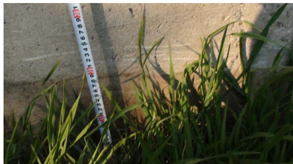
(b) A2 橋台周辺地盤((a)の四角部位置)の沈下量(約 20cm)
