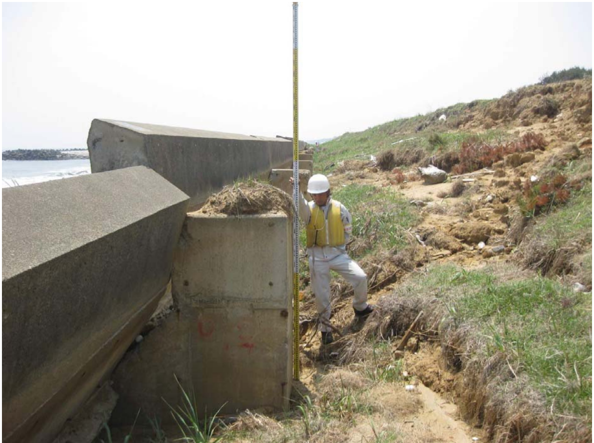
写真-5. 4. 131 護岸裏のすべり（成田海岸）
