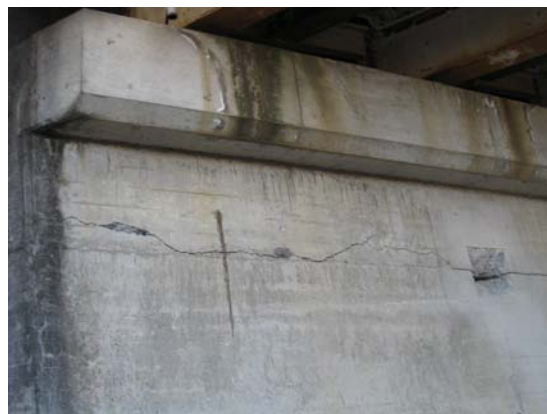
写真-9.27 A 1 橋台前面のひび割れ
