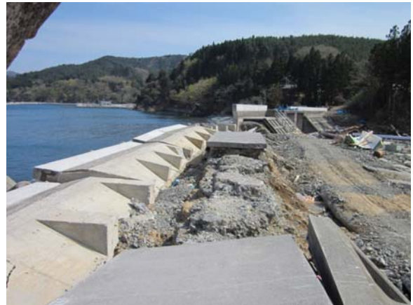
写真-5. 4. 70 表法被覆工海側への倒壊
