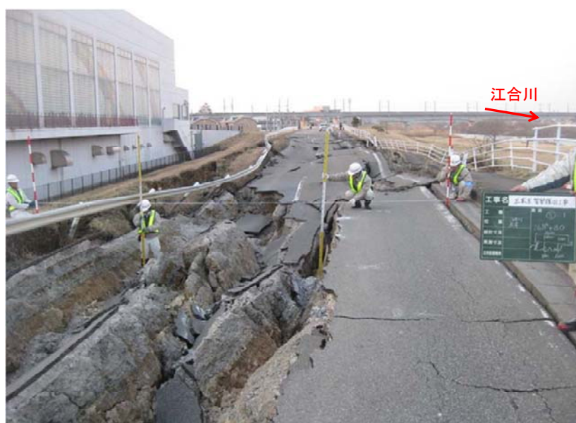
写真-6.43 天端の状況(東北地方整備局提供)
