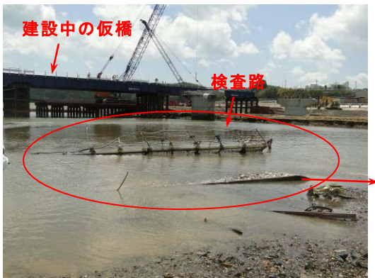
写真-9.114 流出した P 3 橋脚の状況
