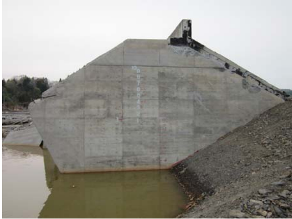
写真-5. 4. 54 隔壁工による破堤の拡大防止
