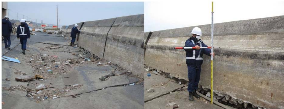
写真-5. 4. 123 天端陥没 (鉾田海岸)
