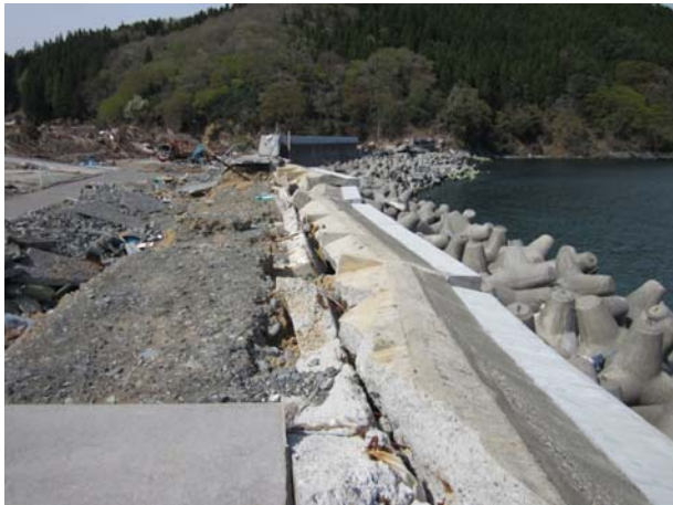
写真-5. 4. 69 表法被覆工海側への倒壊
