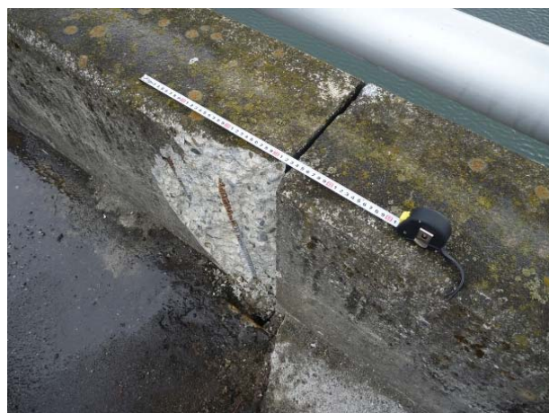
写真-7.5 天端高欄コンクリートの剥落(田瀬ダム)
