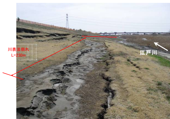
写真-6.97 表のり尻部の噴砂痕（関東地方整備局提供）
