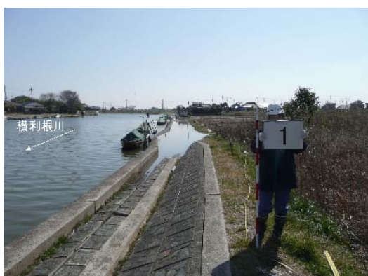
写真-6.71 矢板護岸の水平変位と天端の沈下(関東地方整備局提供)
