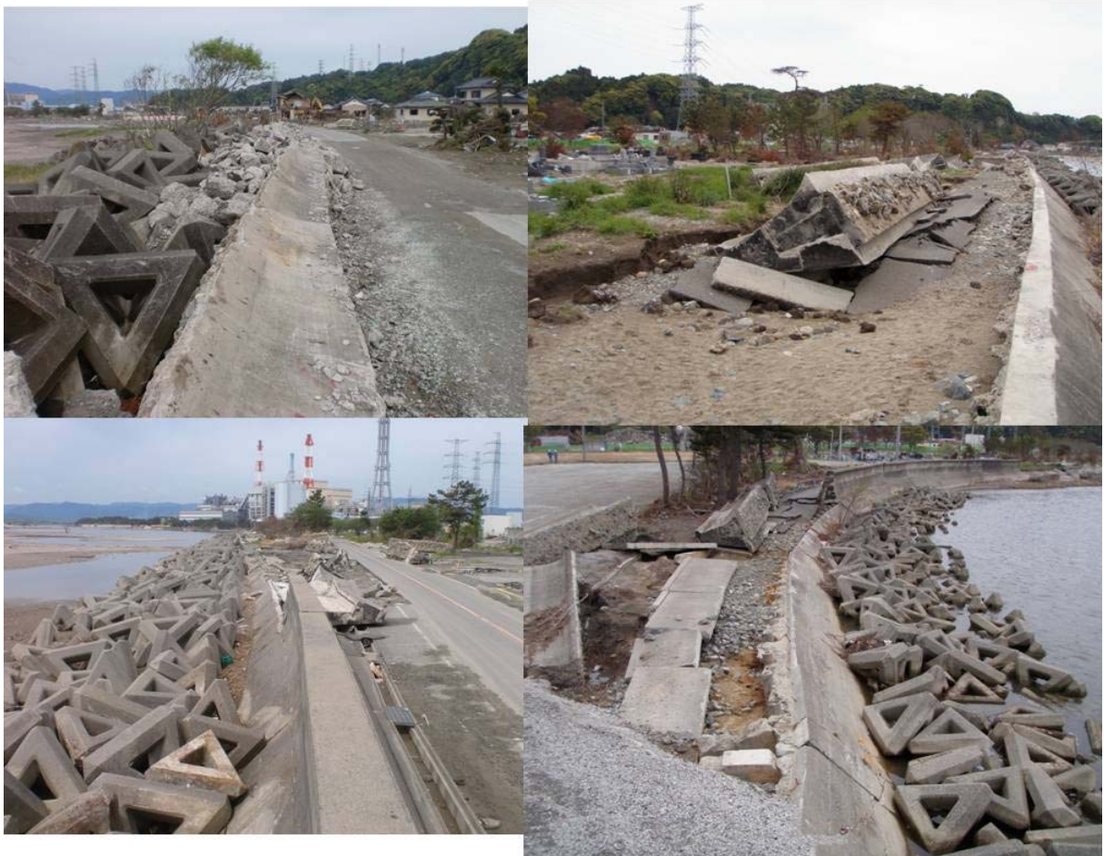
図-5.4.70 直立堤の倒壊（植田岩間地区海岸）
