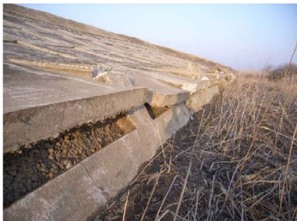
写真-6.27 護岸下部の破損
