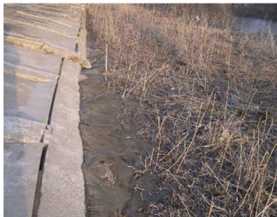
写真-6.28 のり尻周辺に見られた噴砂痕
