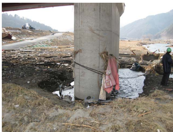
写真-9.146 P 1 橋脚基部の津波による 洗掘
