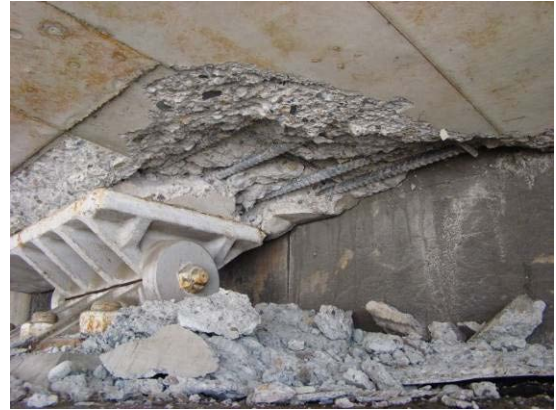
写真-9.33 支承が取り付け上部構造側の損傷 (下り線A 2 橋台)
