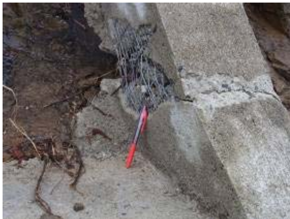
写真-10.52 のり枠下部の損傷 （金網型枠内のモルタルも破砕）
