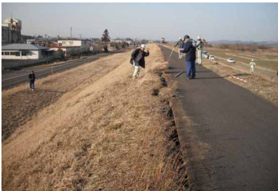
写真-6.1 天端の縦断亀裂(東北地方整備局提供)
