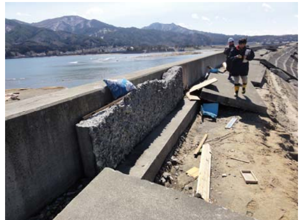
写真-5. 4. 57 天端保護工被災状況
