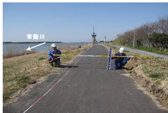
写真-6.68 天端の沈下(関東地方整備局提供)
