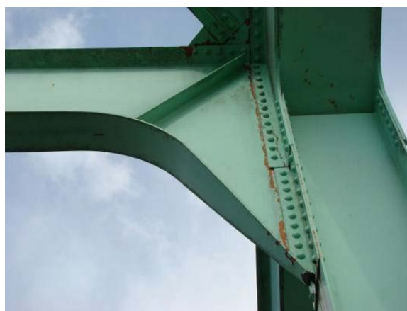
写真-9. 52 橋門構の塗膜割れ
