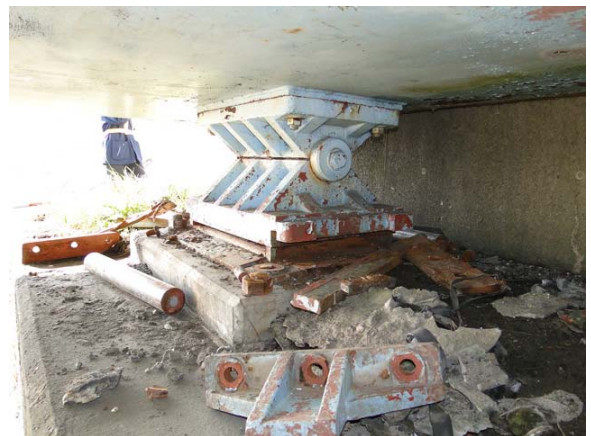
写真-9.22 A 2 橋台の可動支承の損傷
