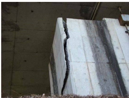
写真-9.35 橋脚のひび割れ (左：上り線P 1 4 橋脚、右：上り線P 1 7 橋脚)
