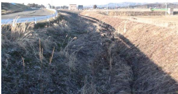
写真-6.7 水路を閉塞した崩土
