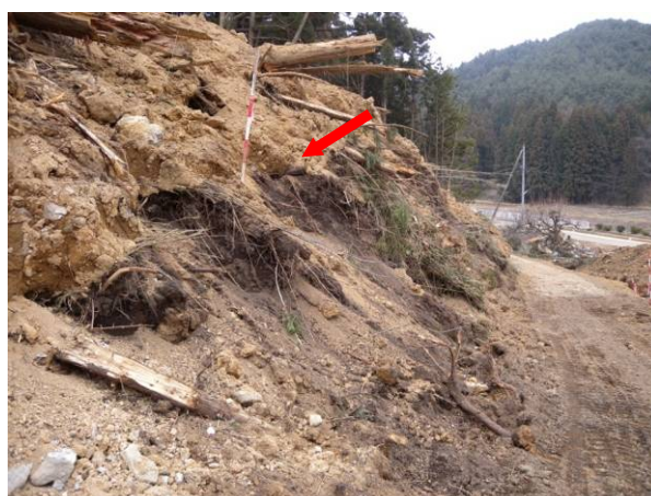
(f) 土砂が地すべりを横切る道を覆う状況 （土砂が植生と表土の黒土を覆っている）
