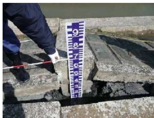
写真-6.72 矢板護岸背後のブロックの変状(関東地方整備局提供)
