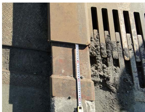
写真-9.14 A 2 橋台伸縮装置の水平移動の擦過痕（約5cm）
