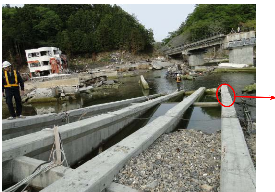
写真-9.127 流出している桁の状況
