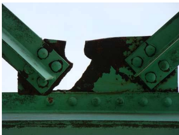
写真-9.45 ガセット部の破断
