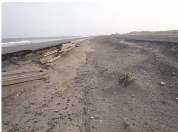
写真-5.4.148 護岸裏法被災（木戸海岸）
