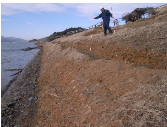
◆川側のり面：植生が剥離するとともに、筋状に堤体が侵食されていた（上流を望む）
