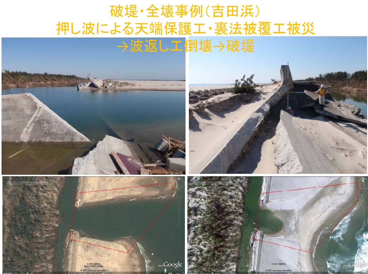
図-5.4.56 歯抜け破堤とその後のバーム形成による閉塞（吉田浜）
