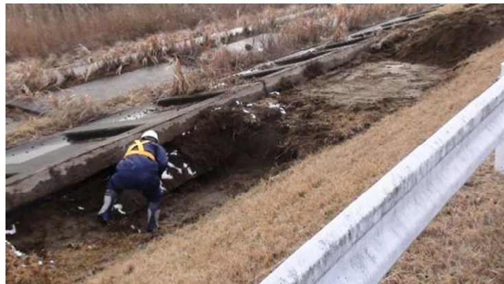
写真-6.24 護岸頂部の前傾
