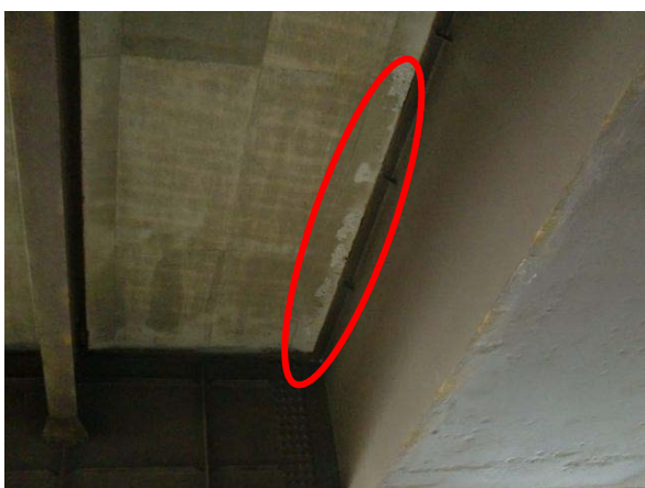
(i) 床板裏面にみられた剥離
