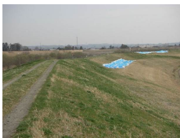
写真-6.103 対策区間に隣接する堤防の沈下（写真手前は対策区間）
