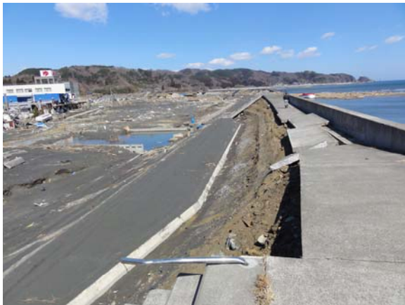
写真-5. 4. 56 天端保護工被災状況
