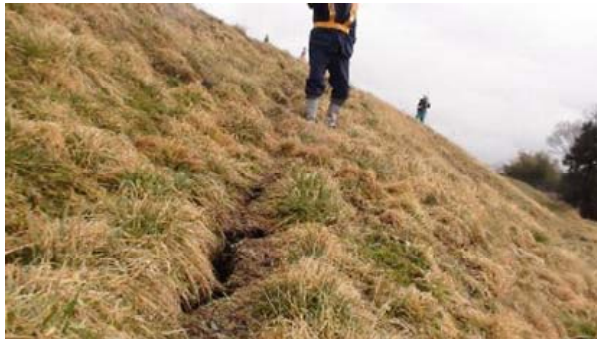
写真-6.31 裏のりの亀裂
