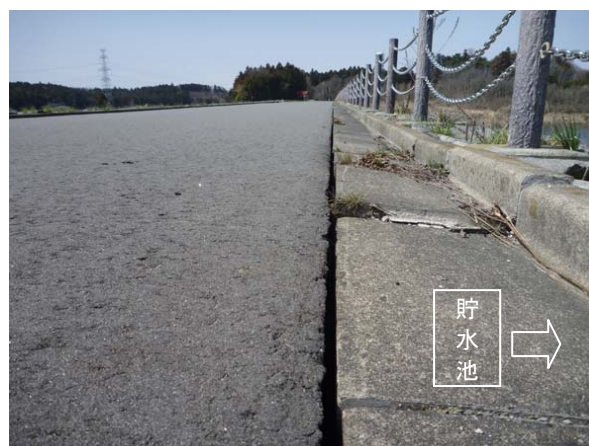
写真-7.11 天端中央部の縁石と舗装の開き (化女沼ダム)
