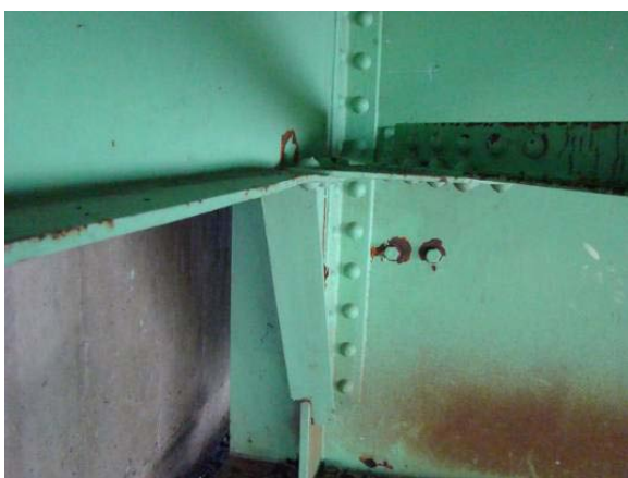
写真-9. 51 支承横桁フランジの変形
