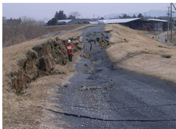
写真-6.13 天端の沈下
