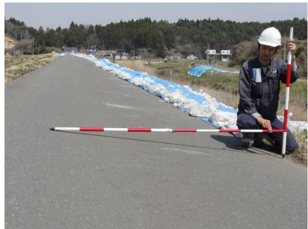
写真-6.107 天端の傾斜（写真奥がドレーン工設置区間。手前より傾斜が緩い）
