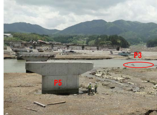
写真-9.113 P 3 橋脚の流出した位置
