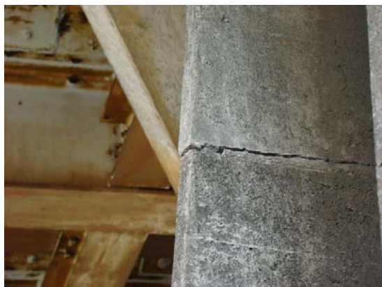
写真-9.29 A 1 橋台左側面のひび割れ
