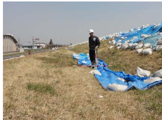
写真-6.2 裏小段の傾斜と縦断亀裂
