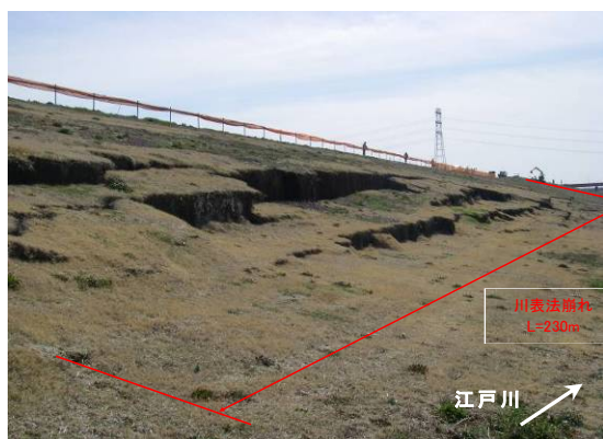
写真-6.96 表のりの段差を伴う沈下（関東地方整備局提供）
