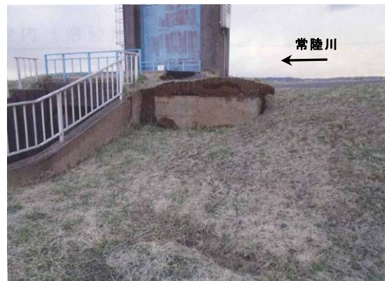
写真-6.70 樋門の抜け上がり(関東地方整備局提供)
