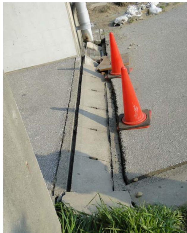
(c) 橋台周辺地盤の沈下により生じた、橋台側面の段差((a)のコーン設置位置)
