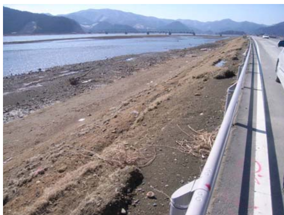
◆川側のり面：天端～のり肩部が侵食を受けている
