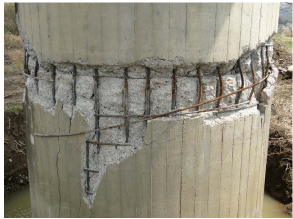
写真-9.107 藤橋の P 6 橋脚の段落し部の損傷
