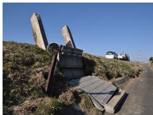
写真-6.66 階段工の変状(関東地方整備局提供)
