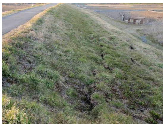
写真-6.80 裏のりの亀裂(関東地方整備局提供)
