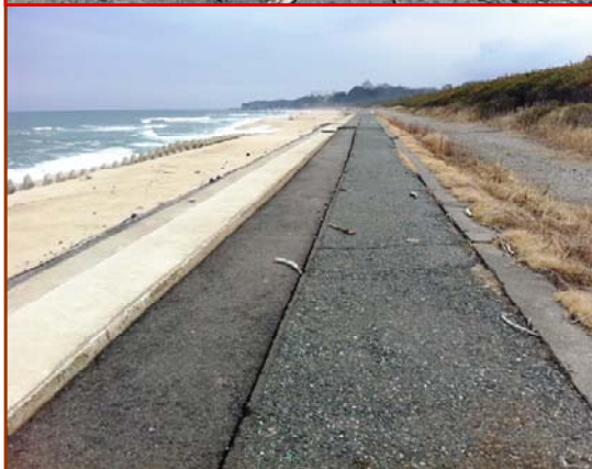
写真-5. 4. 130 天端のひび割れ
