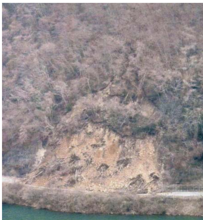
図-2.6 岩盤崩壊による国道の被災 (国道45号石巻北方、写真は東北地方整備局提供)
