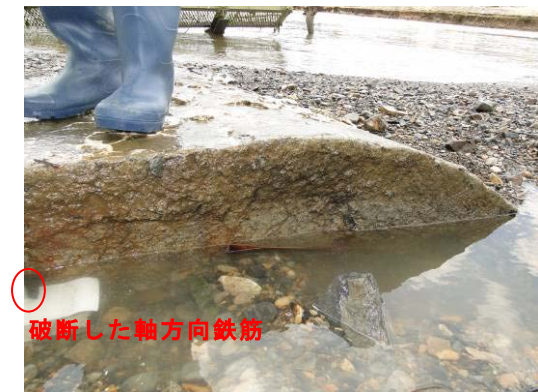
写真-9.115 P 3 橋脚の破壊面
