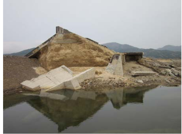
写真-5. 4. 55 堤防断面（嵩上げ拡大）
