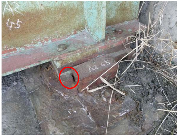
写真-9.170 A 2 橋台支承の状況：前側 サイドブロックとの間にす き間がある
