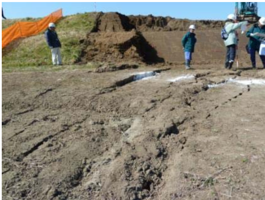
図-2.5 河川堤防の亀裂（小貝川）
