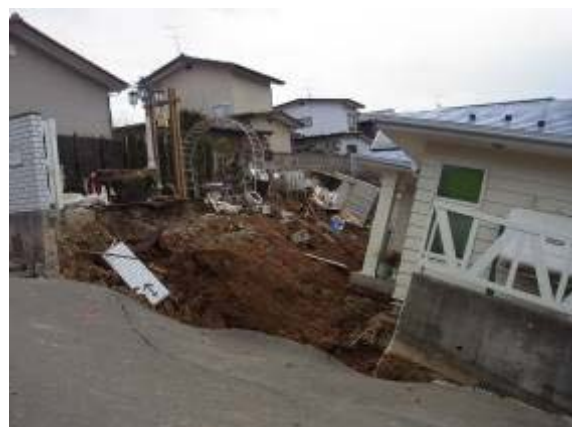
写真-10.3 崩壊頭部の状況
