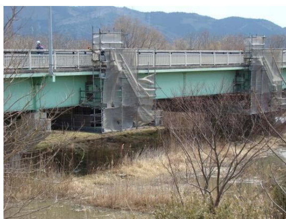
写真-9. 54 補修工事足場架設状況
