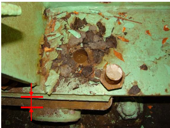
写真-9. 49 支承ボルト破断及び 支承横方向のズレ
