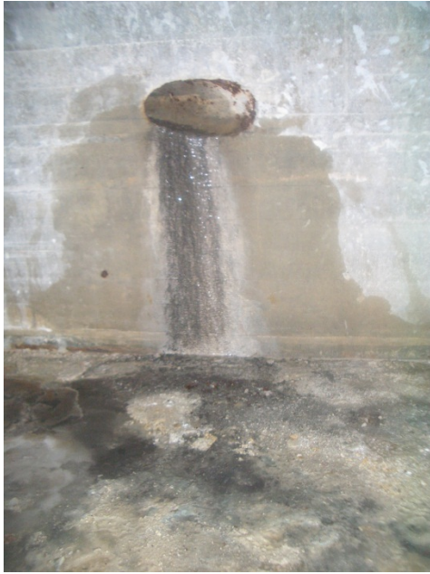
写真-7.14 継目(J8)排水孔 (蔵王ダム)
