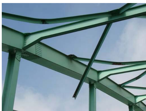
写真-9.46 上横構座屈及びガセット部破断
