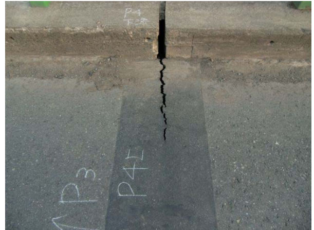
写真-9.95 P 4 橋脚上の路面に生じたひび割れ
