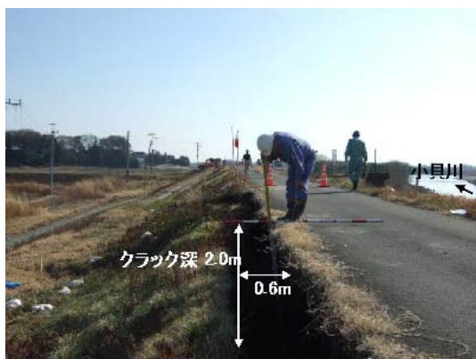
写真-6. 86 裏のり肩～裏のりの沈下(関東地方整備局提供)
