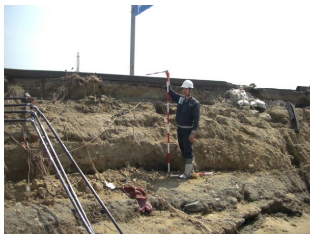
写真-6.99 対策区間下流の津波越流による浸食の状況
