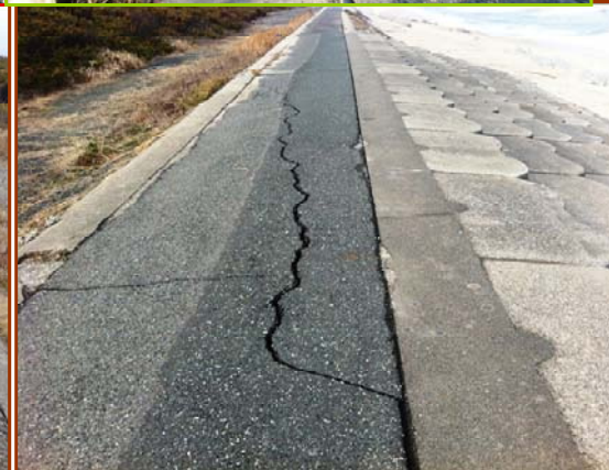
写真-5. 4. 130 天端のひび割れ
