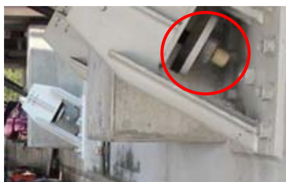
(l) 落橋防止構造のケーブル端部のゆるみ
