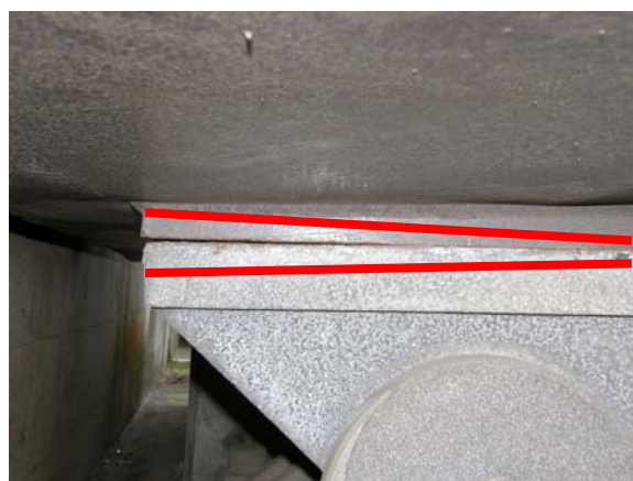
(g) 支承と桁のプレートとの間に生じた隙間
