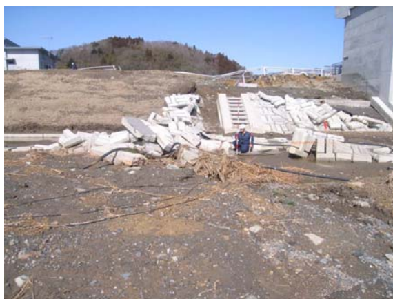
◆水門脇護岸ブロックの上流へのめくり上がり
