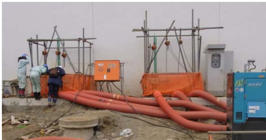
写真-8.7 流入渠からの仮設ポンプによる汚水くみ上げ（宮城県石巻東部浄化センター）
