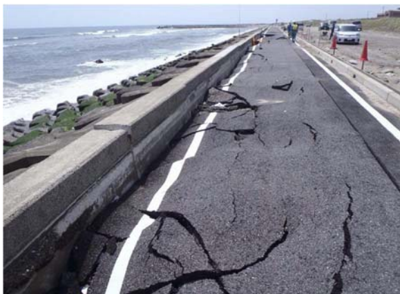
写真-5. 4. 141 護岸天端被災（野手海岸）
