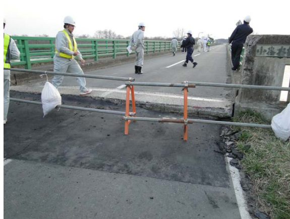
写真-9.105 A 1 橋台背面の段差の補修
