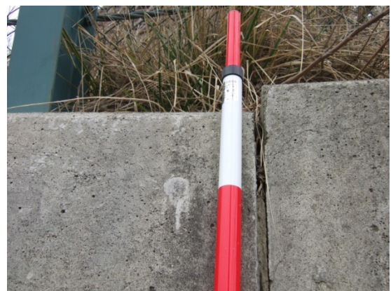
写真-4.5.4 擁壁工縦ズレ箇所（拡大）
