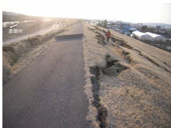
写真-6.25 天端の傾斜・沈下および裏のり肩の縦断亀裂の開口
