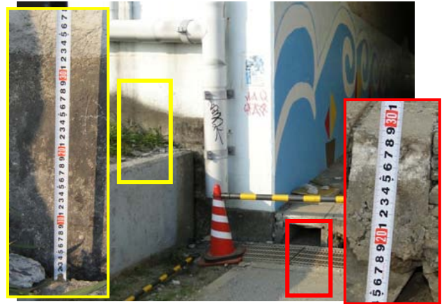
(d) 橋台と橋台前面護岸、橋台と一般部の鉛直変位差(約 30cm)
