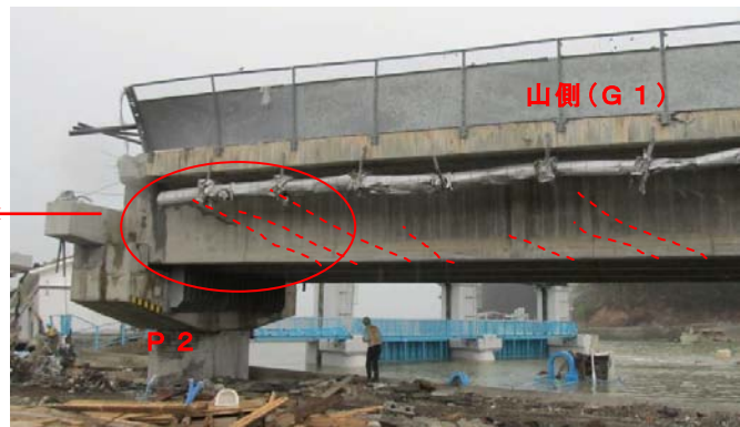
写真-9.131 斜めひび割れの発生状況 (P 1 ~ P 2 間 G 1 側)
