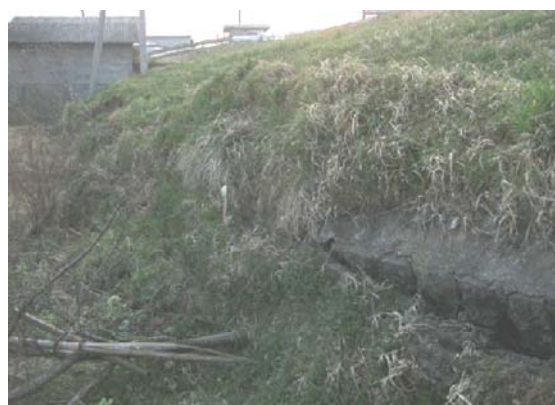
写真-6.20 裏のり尻のブロック積み擁壁の倒壊
