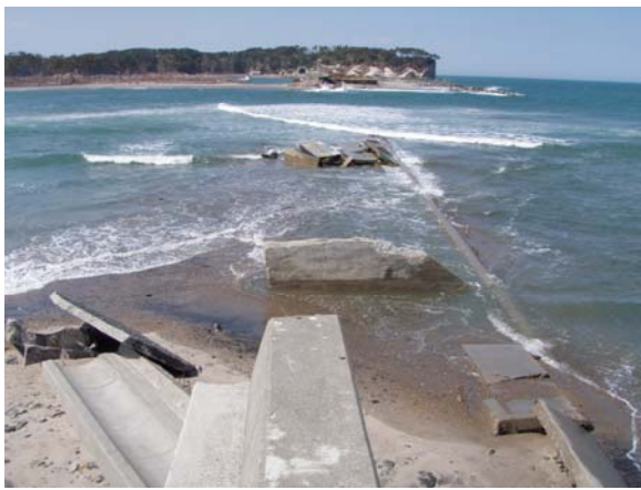
写真-5.4.87 破堤箇所（大浜地先海岸北部）
