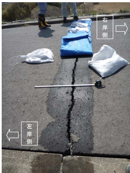
写真-7.10 上下流方向に発生したクラック (化女沼ダム)
