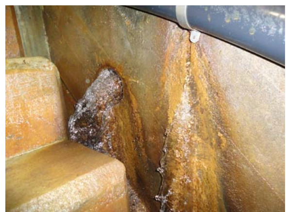
写真-7.13 横継目 (J9) からの漏水の状況 (高坂ダム)
