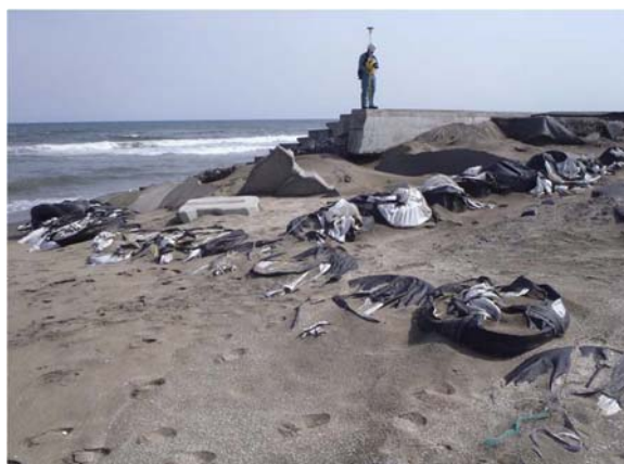
写真-5. 4. 143 護岸施工端被災（川辺海岸）
