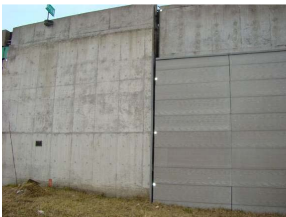
写真-9.55 A 2 橋台と背面盛土の遊間及び沈下
