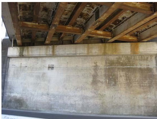
写真-9.26 A 1 橋台前面のひび割れ
