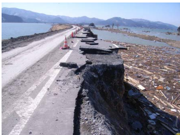
◆堤内側への越流による侵食：天端が一部流失している
