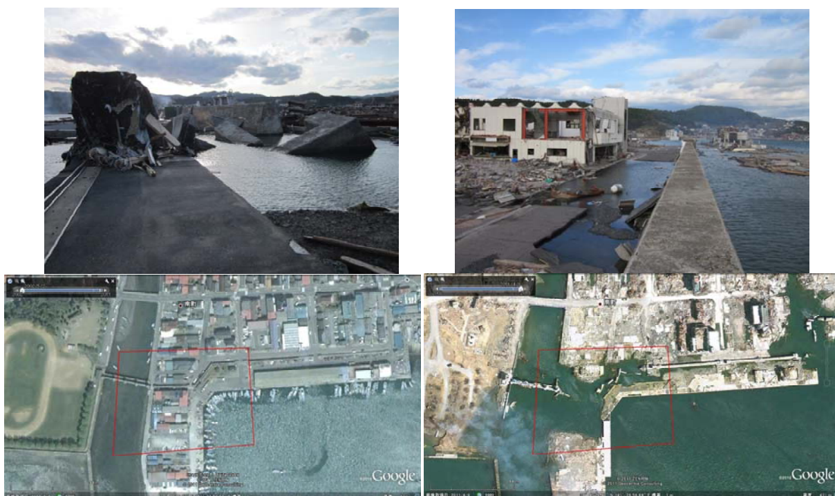
図-5.4.19 胸壁の破堤・洗掘
