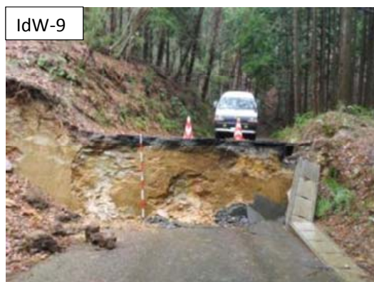
東を望む。左写真の北側延長にあたる道路上での 変位。垂直変位は約180cm。変位面の走向はN2W、 傾斜は81W。変位面には、厚さ2cm程度の断層粘 土が付着しており、80S～75N傾斜の条線も確認さ れる。
