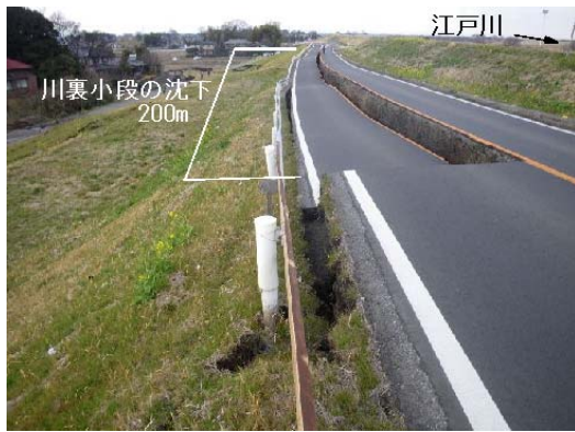
写真-6.94 裏小段の段差を伴う沈下 (関東地方整備局提供)
