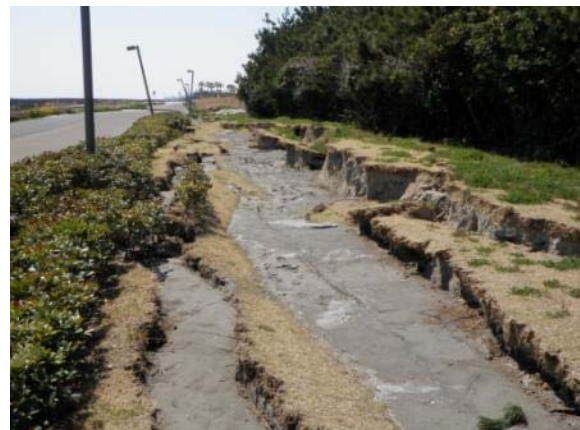
図-2.10 側方流動 （千葉県浦安市）
