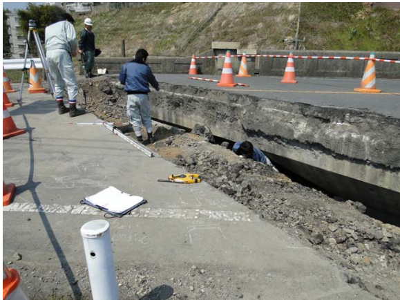
写真-9.87 橋台背面の補修の状況
