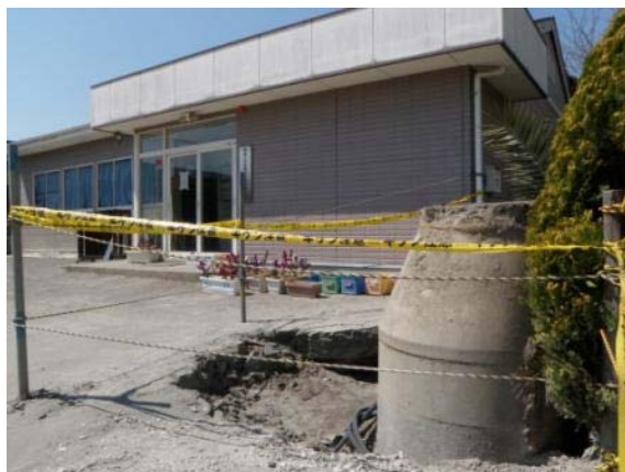
図-2.9 マンホールの浮き上がり （千葉県浦安市）
