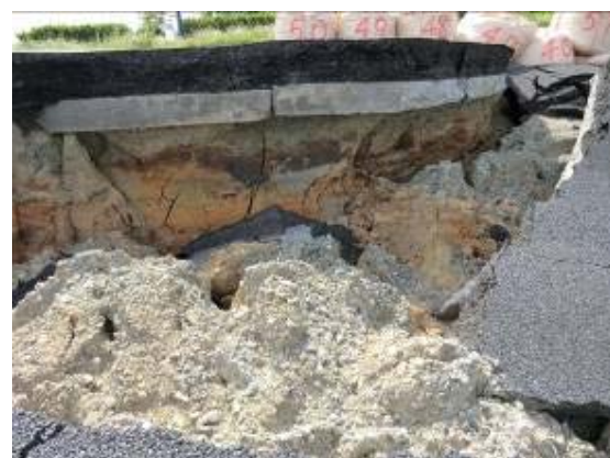
写真-10.20 切土部の舗装盤下の基岩 (盛土部の喪失により切盛り境で旧コン クリート舗装盤が破断している)
