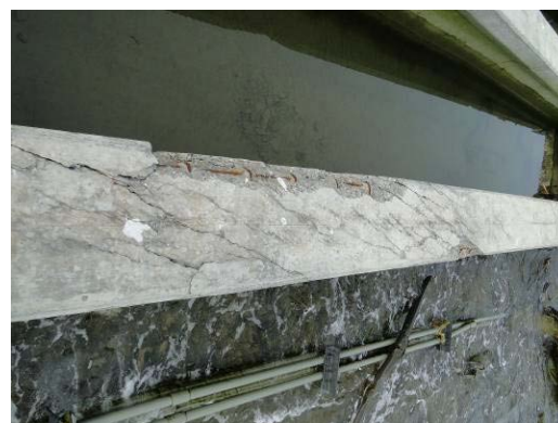
写真-9.128 桁のひび割れ状況
