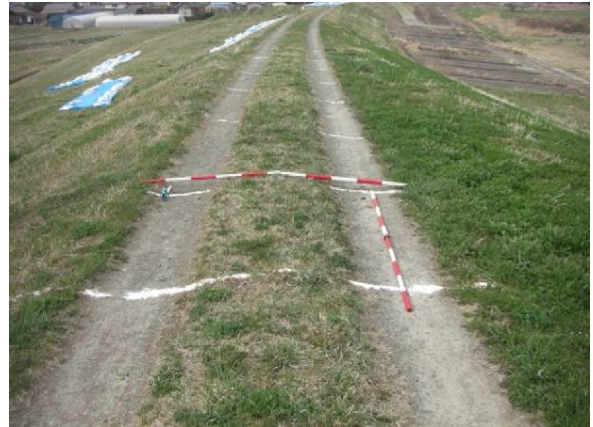
写真-6.105 対策・無対策区間の境界付近に発生した複数の横断亀裂（手前が対策区間）
