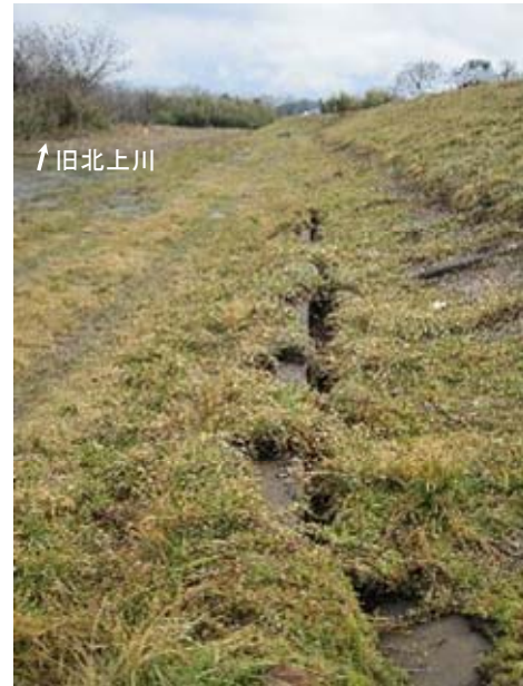
写真-6.32 護岸下部に生じた隙間
