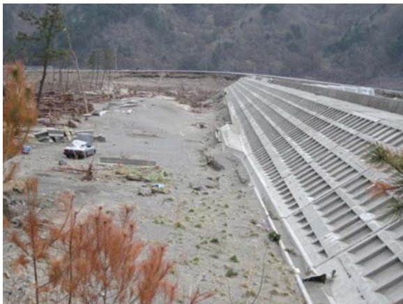
写真-5.4.38 南側堤防裏法尻被災
