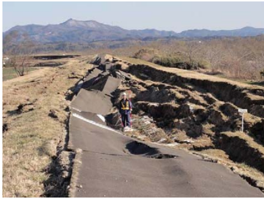
写真-6.4 堤防天端の縦断亀裂と沈下
