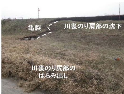
写真-6.84 裏のりの状況(下流側、関東地方整備局提供)
