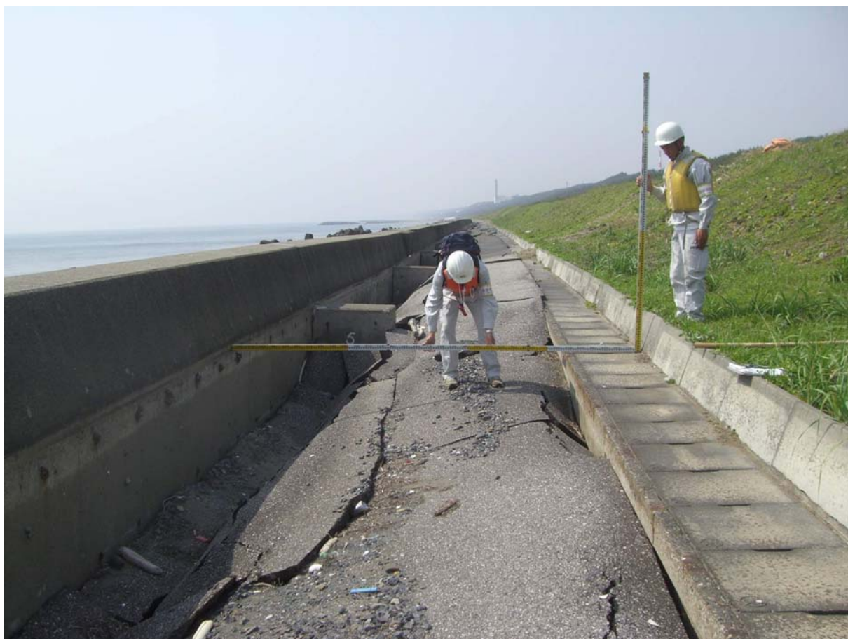
写真-5.4.122 天端陥没（大貫海岸）
