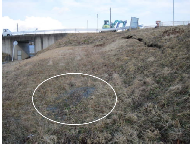
写真-6.41 裏のり中腹部の噴砂
