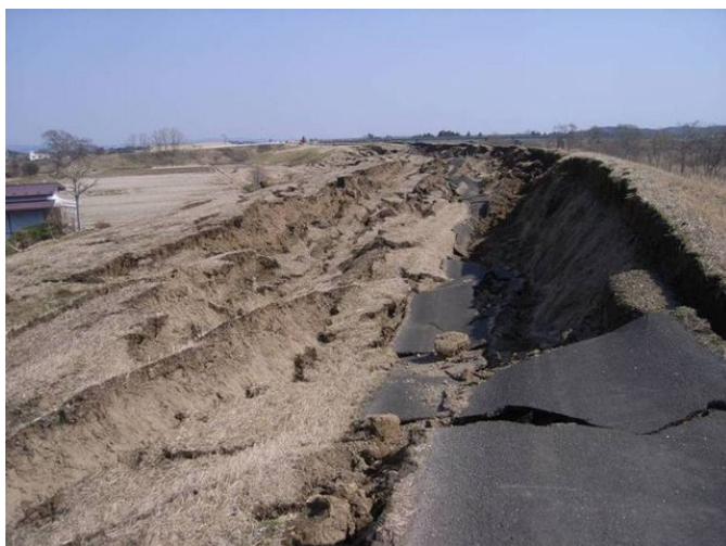
写真-6.21 天端から裏のりにわたる崩壊
