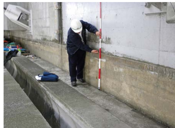
(f) 護岸の沈下 (約 70cm)
