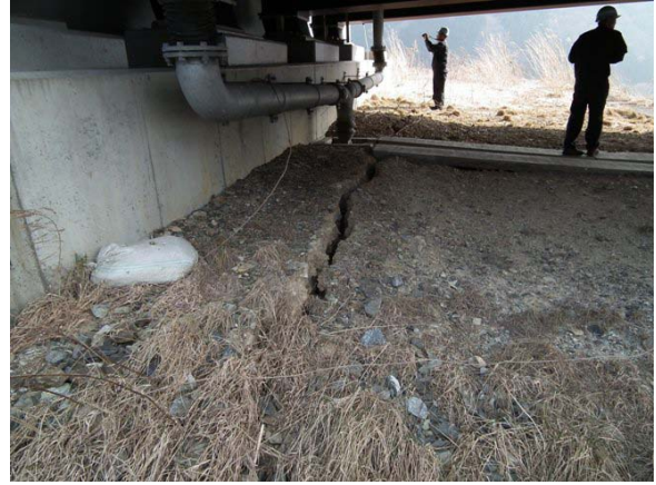
写真-9.83 橋台前面地盤のひび割れ
