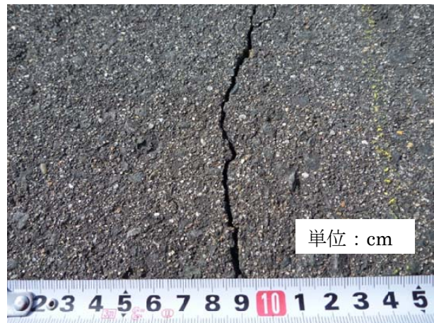
写真-7.2 ダム天端舗装クラックの接写 (摺上川ダム)
