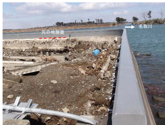
写真-6.10 津波による堤内地盤の侵食 (閑上水門の直上流)
