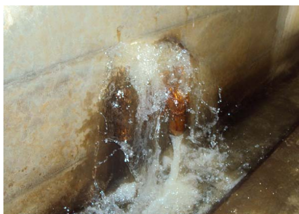
写真-7.12 横継目 (J2J3) からの漏水の状況 (神室ダム)
