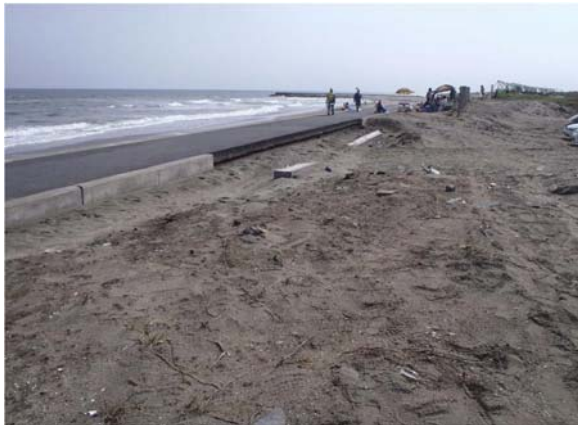
写真-5.4.145 護岸施工端被災（川辺海岸）
