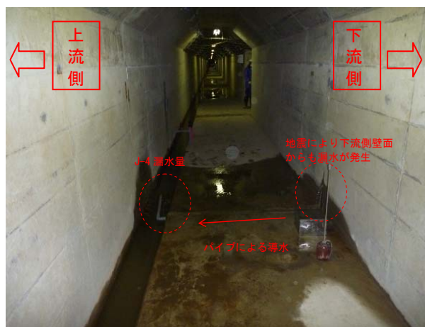
写真-7.7 重力式コンクリートダム部継目(J-4)の漏水(御所ダム、重力式コンクリートダム部)
