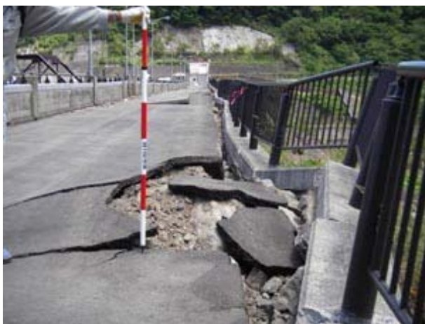
写真-7.3 石淵ダム天端(2008年の地震) 3)
