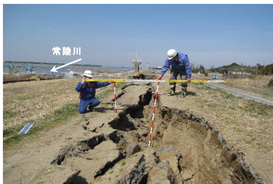
写真-6.67 天端の沈下および縦断亀裂(関東地方整備局提供)
