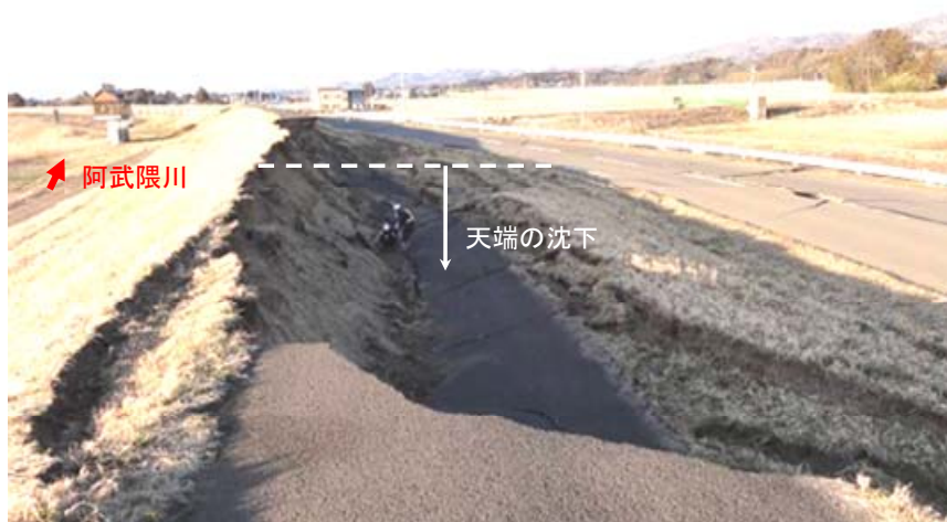
写真-6.6 天端の沈下
