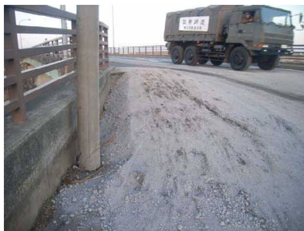
写真-6.48 江合橋の橋台アプローチ部に生じた段差
