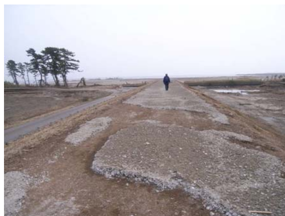
◆天端舗装の剥離・流送：その下の堤体土の侵食は軽微
