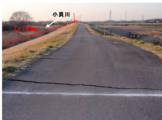
写真-6.78 天端の横断亀裂(関東地方整備局提供)
