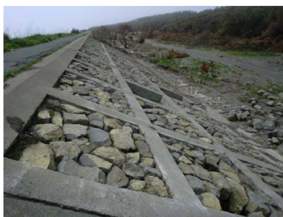
写真-5.4.11 格子枠工裏法被覆工の被災
