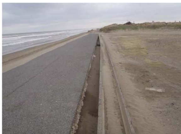
写真-5. 4. 153 裏法排水溝移動（片貝海岸）
