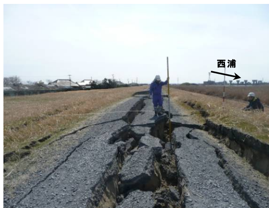
写真-6.75 天端の縦断亀裂、沈下および段差(関東地方整備局提供)
