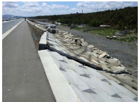
写真-5.4.2 裏法被覆工のずり落ち
