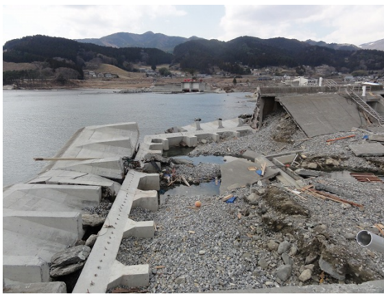
写真-5.4.67 表法被覆工倒壊状況
