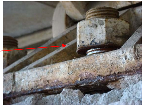
写真-9.34 アンカーボルトの引き抜き (上り線A 2 橋台)
