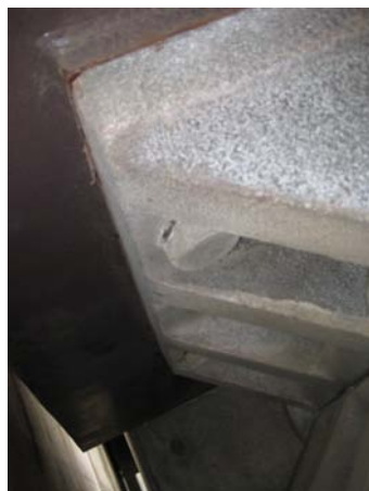
(f) 支承部(背面側)のボルトのゆるみ
