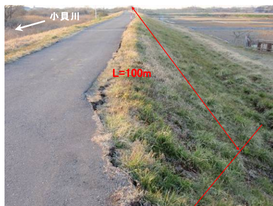
写真-6.79 裏のり肩の縦断亀裂(関東地方整備局提供)
