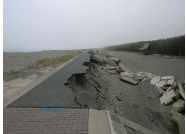
写真-5.4.6 裏法被覆工と天端保護工の被災
