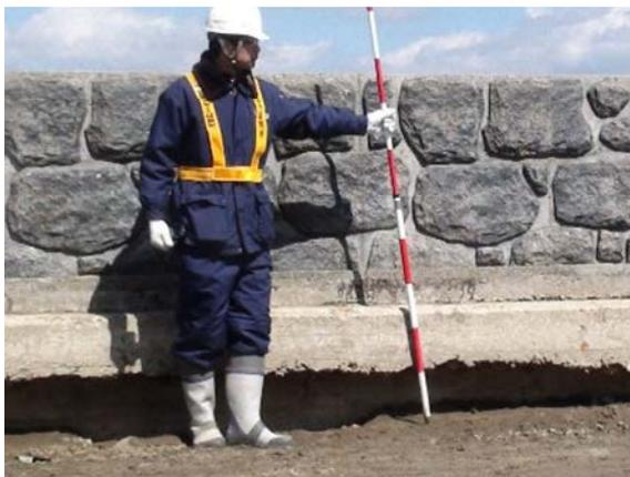
写真-6.11 パラペット背後の沈下
