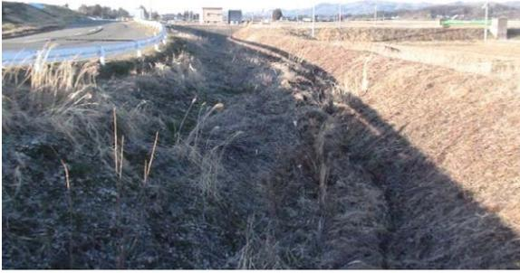
写真-6.7 水路を閉塞した崩土
