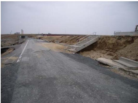
◆のり面の侵食状況：R-6に比較して侵食が進行している。のり尻部では舗装によって洗掘が抑制されたと考えられる
