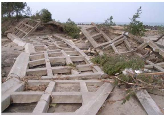
◆河川堤防に接続する海岸堤防の被災：裏のり側から内部の土砂が抜け出してコンクリート枠がつぶれるように倒壊
