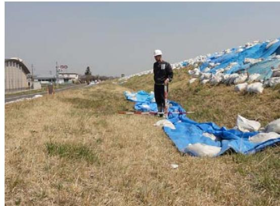
写真-6.2 裏小段の傾斜と縦断亀裂
