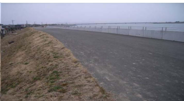
◆パラペットの手すりに痕跡ほとんどなし：のり面の侵食が軽微、落堀は見られない（R-2→R-3→R-4と越流による堤防の侵食の程度が徐々に小さくなる傾向が見られる）
