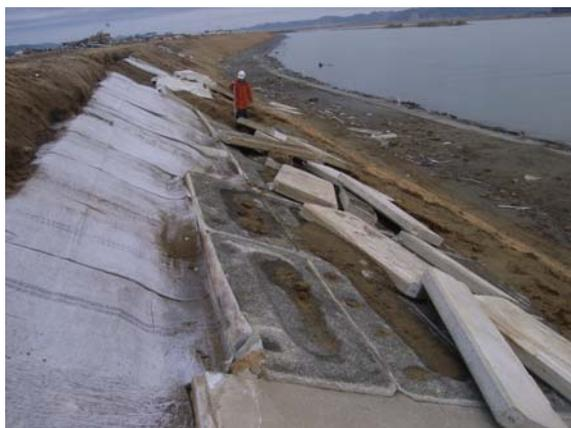
◆覆土下の高水護岸が露出：天端側のブロックがのり尻側に移動（堤内側からの越水による）
