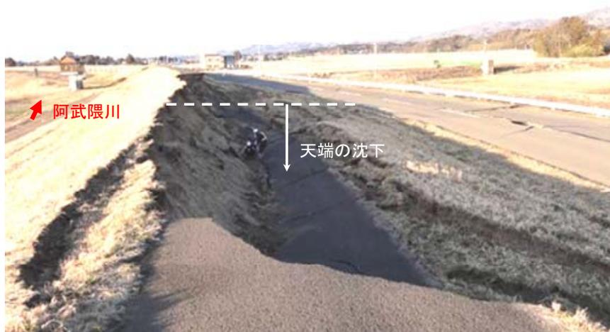
写真-6.6 天端の沈下
