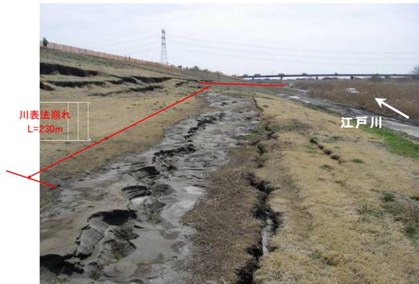
写真-6.97 表のり尻部の噴砂痕（関東地方整備局提供）
