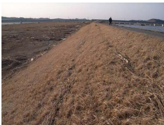
◆川側のり面の2筋の水位痕跡：複数回の津波遡上が生じたことを示唆
