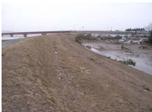
◆堤内側のり面には越水による侵食・植生の倒伏が見られた。痕跡水位は小段上程度。
