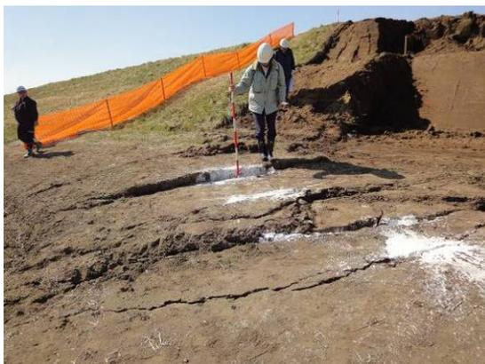
写真-6.82 裏のり尻付近の亀裂
