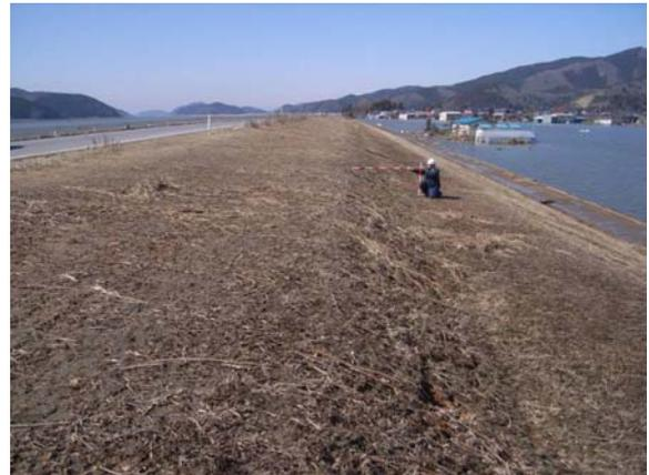
◆堤内側のり面：越水によって植生がのり尻に向かって倒れ、溝状に堤体が侵食されていた
