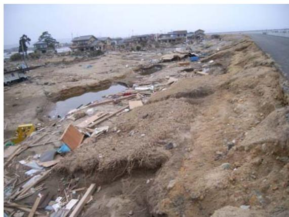
◆パラペットは流失せず、手すりに痕跡が見られる：越水によるのり面侵食と落堀形成
