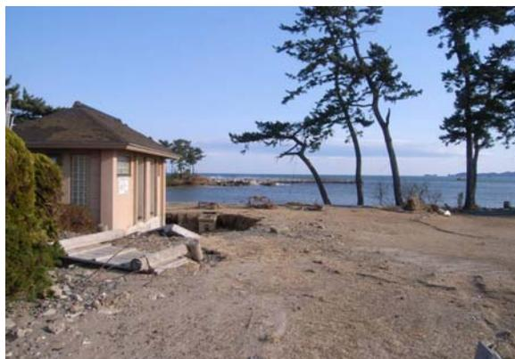
◆堤防天端際に設置された施設：屋根の損壊から水位痕跡を把握(天端から約2mの高さ)
