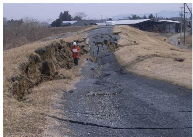
写真-6.13 天端の沈下
