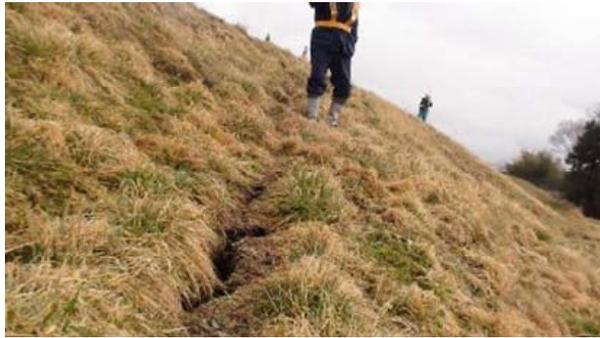
写真-6.31 裏のりの亀裂
