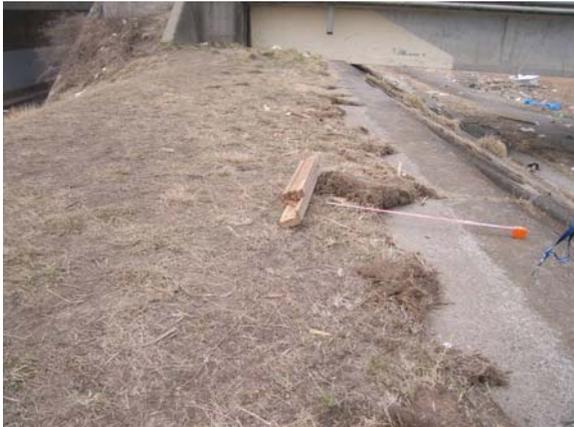
◆護岸天端部での植生のめくれ上がり：ほぼ堤防満杯で遡上した津波が橋桁でせき上げられて越水したと推定される。
