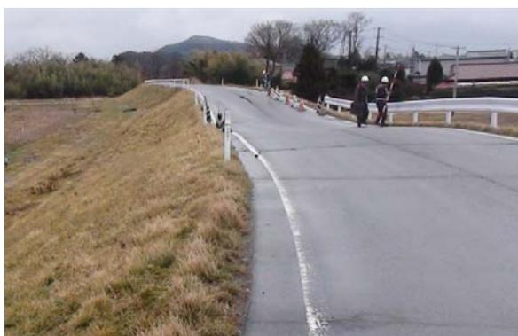
写真-6.29 天端の沈下
