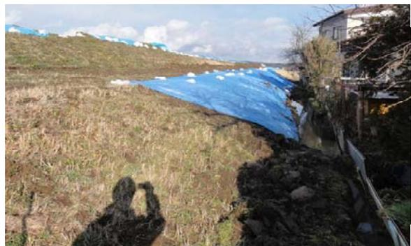
写真-6.38 裏のりの状況(撮影時は崩土を撤去済み)
