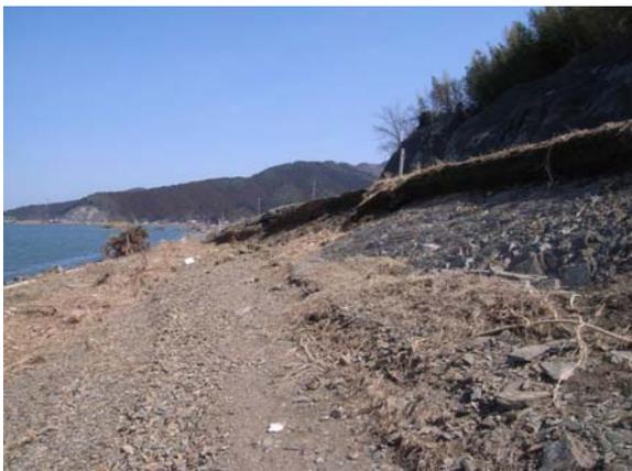
◆川側のり面：山付部では表土が流失し、岩盤面が露出
