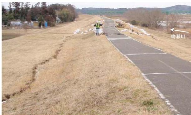
写真-6.15 天端の縦断亀裂、沈下および傾斜
