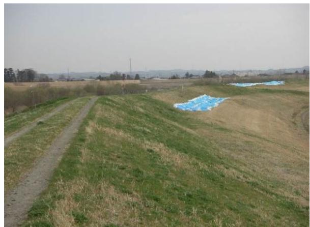
写真-6.103 対策区間に隣接する堤防の沈下(写真手前は対策区間)
