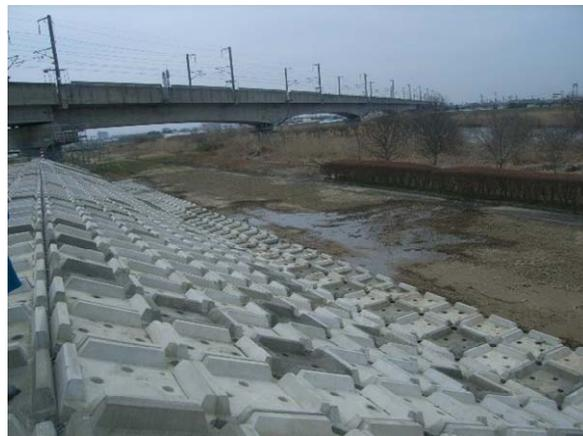
写真-6.51 護岸下部からの水のしみ出し
