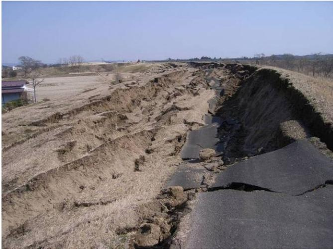
写真-6.21 天端から裏のりにわたる崩壊
