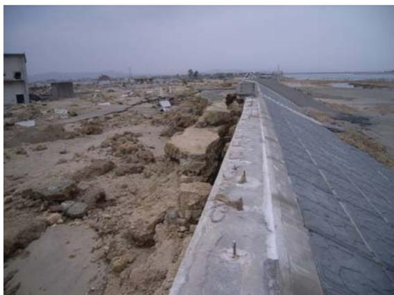
◆越水による土堤部の侵食状況：のり肩のパラペットが流失。天端まで侵食が及ぶ
