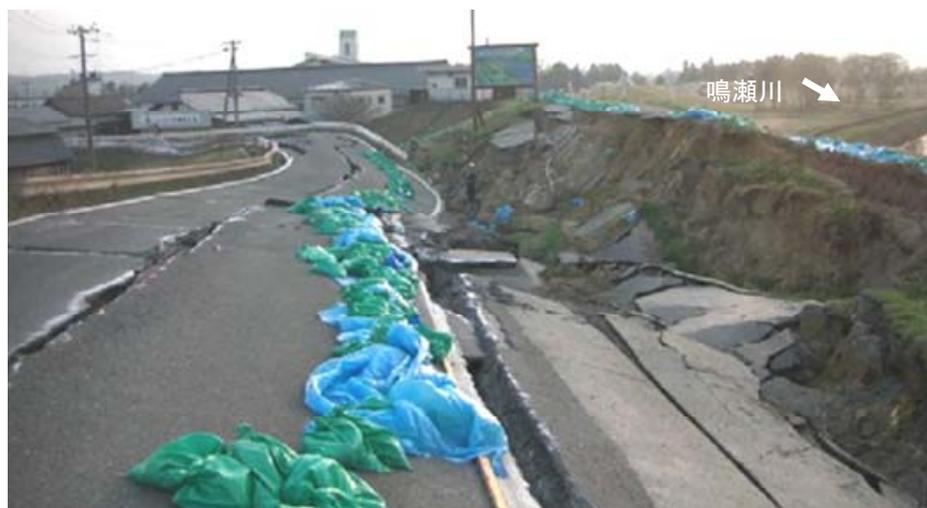
写真-6.18 堤防および道路盛土の崩壊
