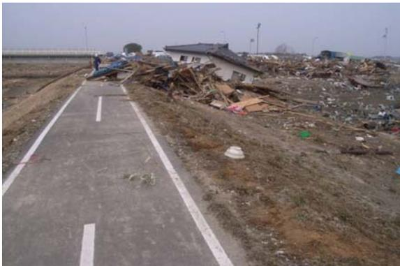
◆堤内側の津波遡上が道路盛土に阻まれて、川側に越水。その際に流送物が堤防に乗り上げる。
