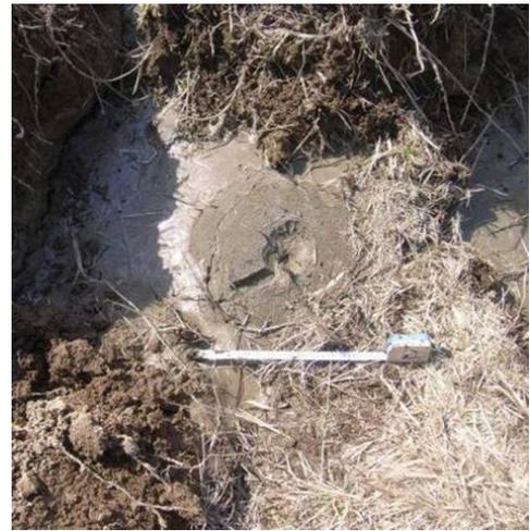
写真-6.22 縦断亀裂内の噴砂痕
