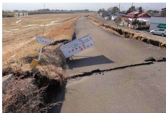
写真-6.40 天端の状況(上谷地橋から上流側を望む)
