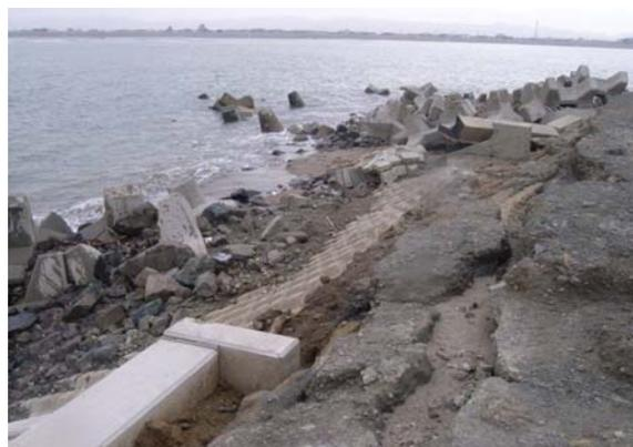
◆河川堤防：堤内側からの越水により損壊：根固ブロックも一部流失
