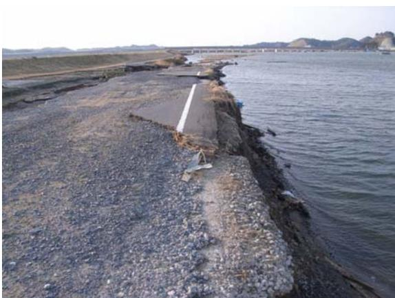
◆堤内側小段上の舗装の損壊とのり尻の侵食状況
