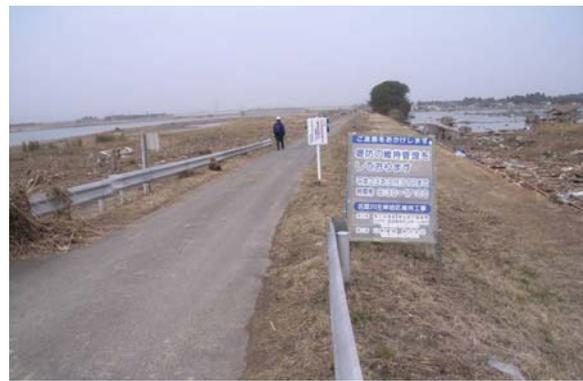
◆道路盛土上流では、川側から堤内側へ越流（写真左のガードレール上の痕跡から）
