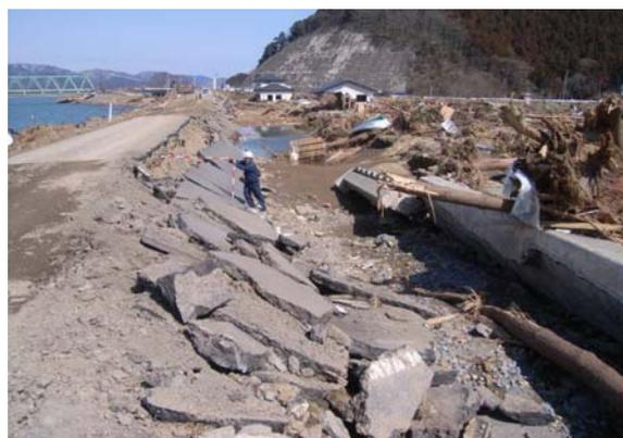
◆堤内側のり面の侵食状況：下流側（写真奥）では落堀が形成されていた
