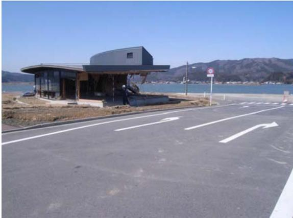
◆堤防天端際に設置された施設：津波遡上により側壁が損壊（地表から約 2m の高さ）
