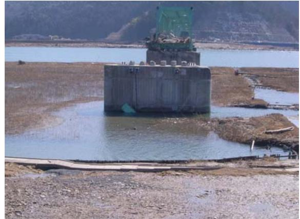
◆左写真の道路に続く新北上大橋の橋桁の流失。高欄に流送物が集積している。
