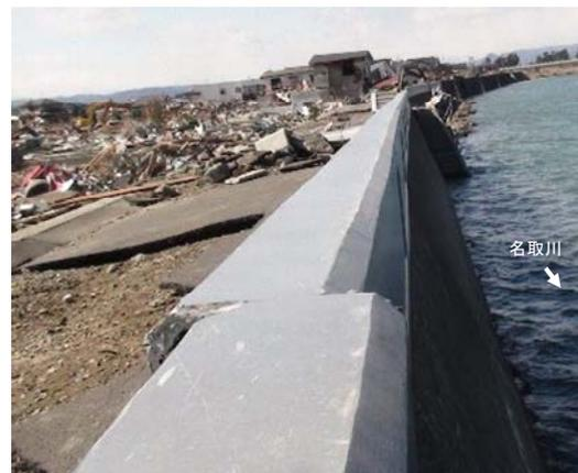
写真-6.12 パラペットの目地ずれ
