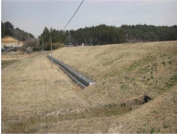
写真-6.106 ドレーン工設置状況
