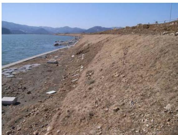
◆川側のり面の侵食：覆土下から護岸ブロックが露出
