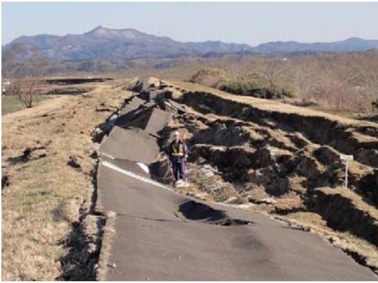
写真-6.4 堤防天端の縦断亀裂と沈下
