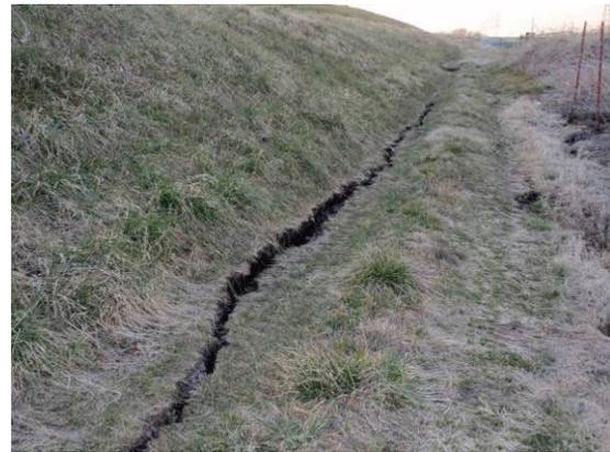
写真-6.81 裏小段の亀裂(関東地方整備局提供)
