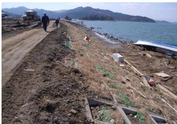
◆高水護岸は枠内の袋詰工が一部流失したが、コンクリート部には目立った損壊なし
