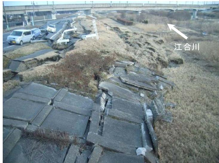
写真-6.46 天端および表のりの状況（江合橋から下流側を望む）
