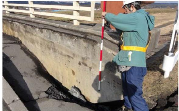
写真-6.36 上谷地橋の橋台アプローチ部に生じた沈下に
