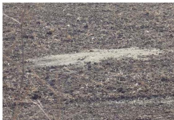
写真-6.92 堤内地側の噴砂痕
