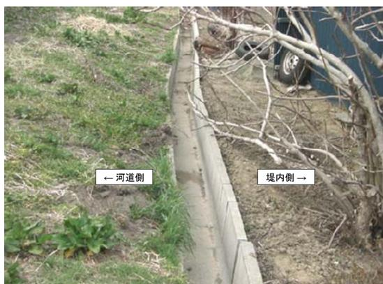
写真-6.16 堤脚水路に生じた水平変位
