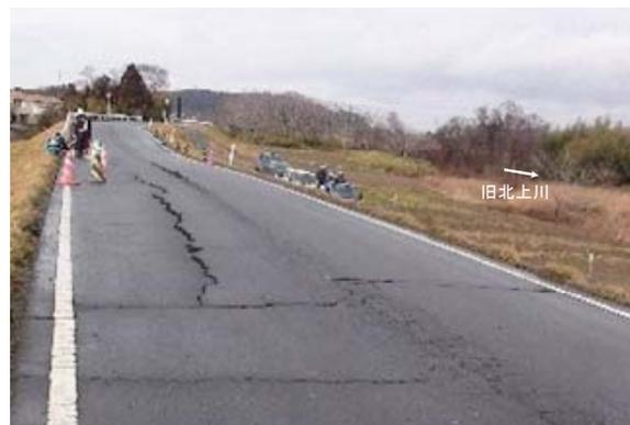
写真-6.30 天端の縦断亀裂
