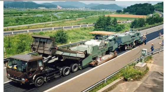
中温化剤の利用(上)や路上表層再生工法の品質・施工性向上検討(下)による舗装の低炭素化
