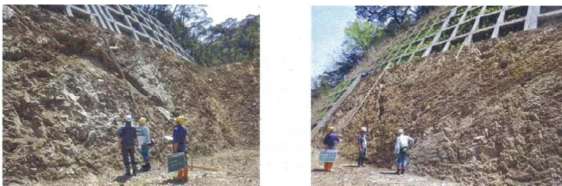
写真－3 のり面観察時の発注者，施工者，地質技術者合同の現地立会の例
