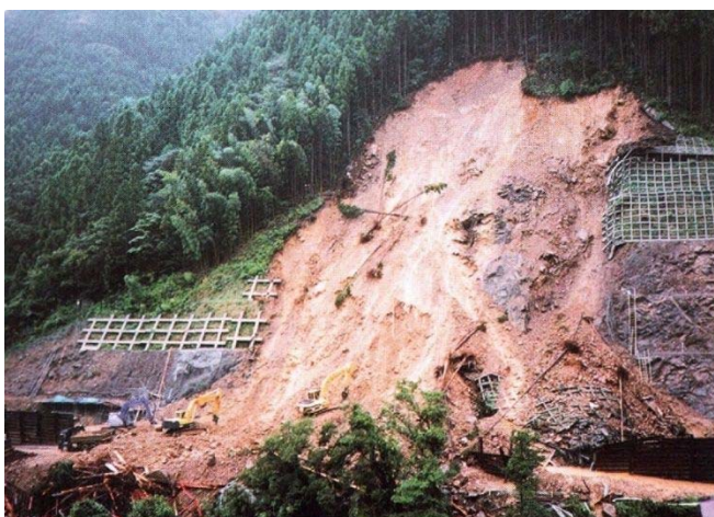
写真-2 県道安田東洋線で発生したのり面崩壊 6)
