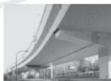
サイレントロード 高架道路の裏面に反射して拡散する騒音の斜入射吸音率0.95を実現した高架道路裏面吸音板です。
