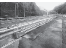
レーンオープナー 自動車専用道路の事故対応などの緊急時、クレーンや工具等を使用せずに短時間で簡単に着脱・移動可能な防護柵です。
