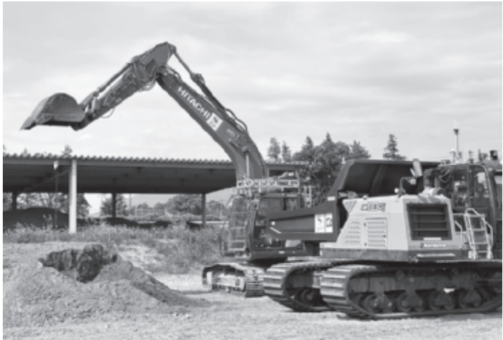
油圧ショベルが掘削した土砂をクローラキャリアダンプに積み込む様子
