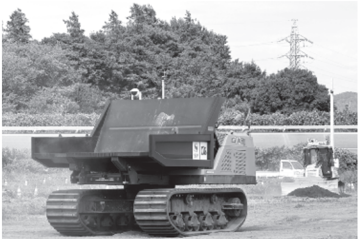
施工管理システムにそって、積み込んだ土砂を敷きならし場へと運ぶクローラキャリアダンプ
