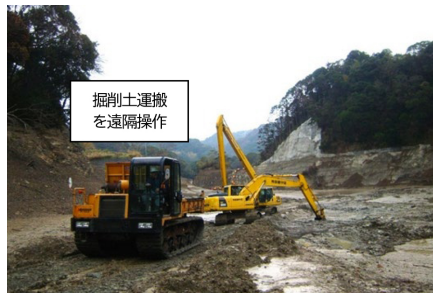
図4 Aダムでの取水施設周辺の陸上掘削
