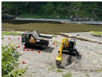
図2 遠隔施工中の重機
