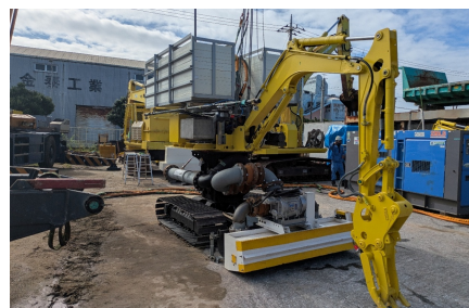
図2 遠隔操縦型浚渫機
