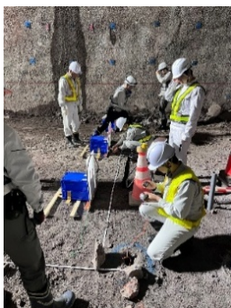
図2 新及位トンネルでの通信試験状況
