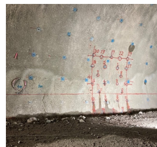
図6 発破試験状況
