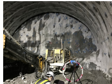
図5 模擬発破試験状況
