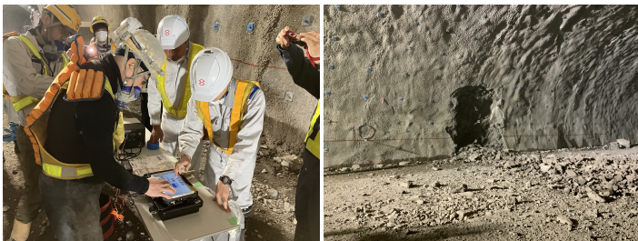
図1 トンネル側壁での試験発破 (左: 取扱指導、右: 発破後の側壁)
