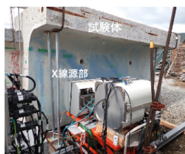
図9 調査した試験体一例
