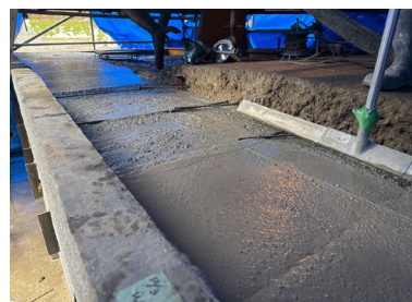
図2 耐震補強 (RC巻立て) のモックアップ
