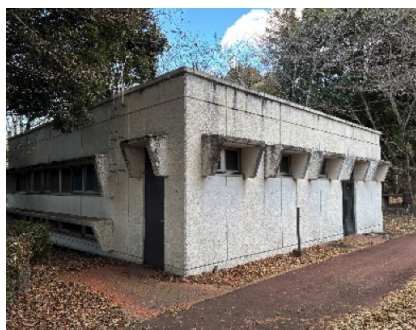
図1 R6年度に調査を実施した建物の例
