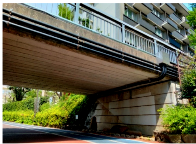
多くのPC桁が連結されたコンクリート橋 (目視点検では内部状況が把握困難な構造)
