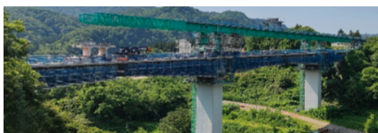
図1 対象橋梁(妙高大橋旧橋)
