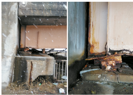
図1 能登半島地震で被災した腐食損傷鋼桁端部
