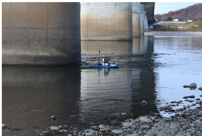
▲橋脚基礎洗掘点検ロボットの様子
