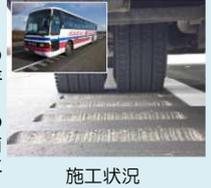
大型車対応ランブルストリップスは、大型バスや大型トラック等の大型車両に対する警告効果を高めたランブルストリップスで、既存規格よりも車内振動レベルを10%程度向上させたものです。
