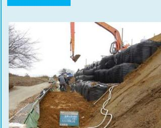
道路盛土等の大規模土砂災害の復旧において、施工性に優れた耐水性大型土のうが応急復旧に使用されるケースが多くなっています。しかしながら、耐水性とはいえ大型土のうは仮設部材とされており、後日、本復旧を行う際には大型土のうと裏込めを撤去掘削する手戻りが生じてしまいます。本技術は、応急復旧から本復旧への過程における手戻りをなくすため、応急復旧の際に設置した大型土のうを残置した状態でその前面に腹付け盛土を構築して復旧を図る工法です。
