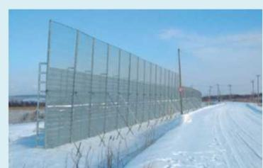
吹雪危険地域の高盛土・広幅員道路において、視程障害対策に供する新型防雪柵です。上部にメッシュパネルを設けた大型の吹き止め柵で、防風・防雪範囲が従来型よりも広く得られるので高規格道路や多車線道路に最適となっています。
