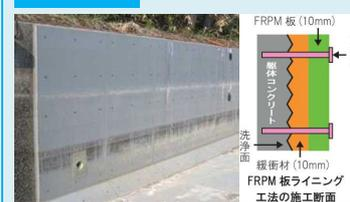
建設後数十年が経過し、老朽化が進んでいる寒冷地の農業用コンクリート水路(開水路)の補修技術です。
