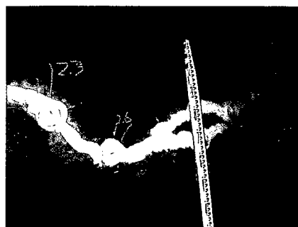
写真-2.3.6 シール材の残存事例
