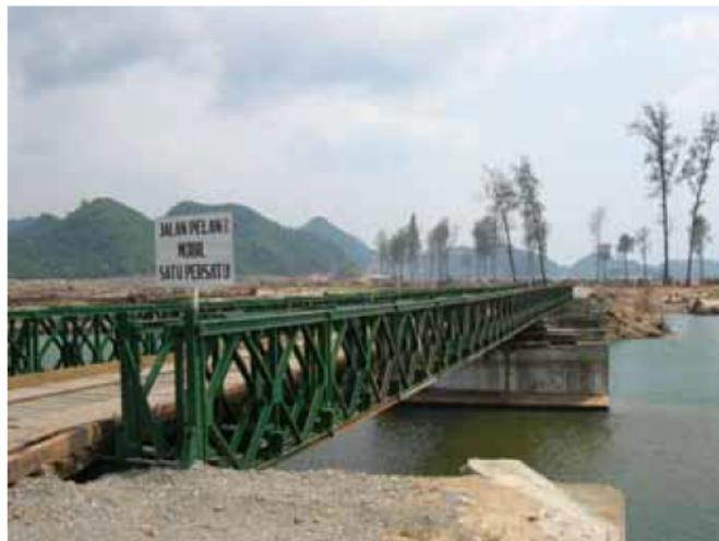
流出したトラス桁の跡に架けられた仮橋
