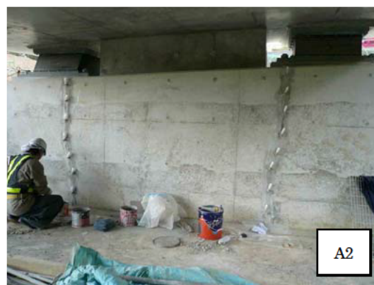
橋台壁前面のひび割れ注入工事
