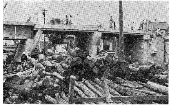
写真-4.8 八千代橋（左岸側 取付橋梁の下部工傾斜） 20)
