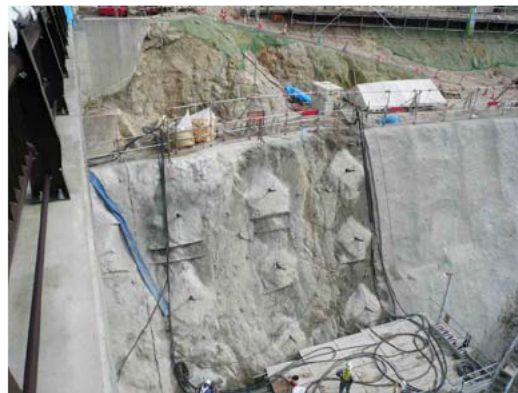
地山に対する斜面安定対策工事（補強工事）
