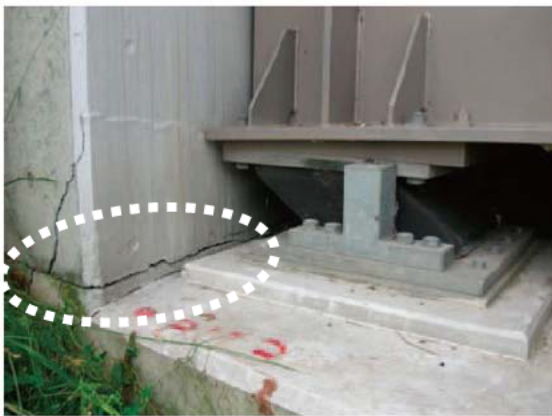
支承の残留変形と橋台パラペットの損傷（左），背面土沈下による段差（右） 写真-4.21 なごみ橋 32)
