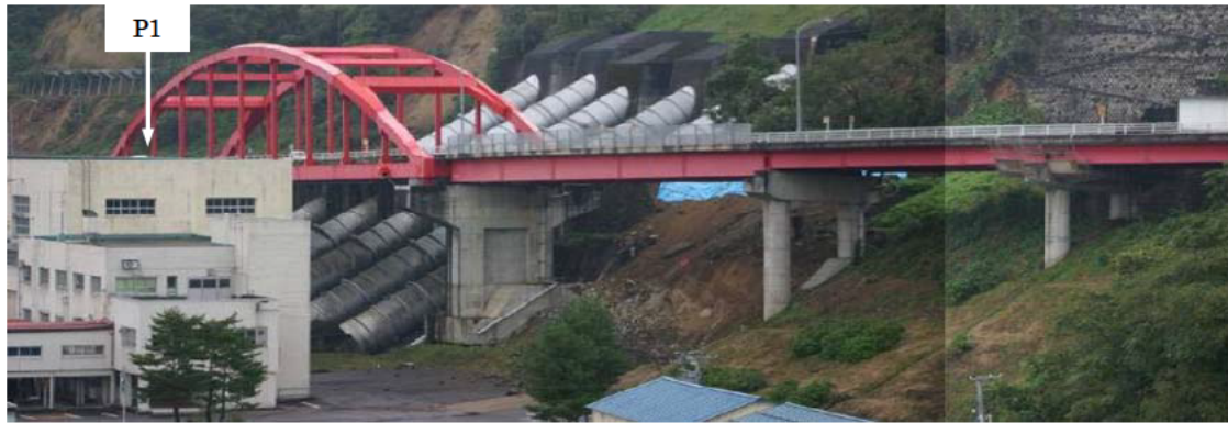
山辺橋の全景
