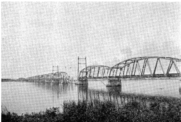
写真-4.9 (新) 松浜橋（落橋） 20)
