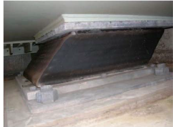
橋とボックスカルバート間の盛土の沈下 (左), 支承の残留変形 (右) (地震直後)
