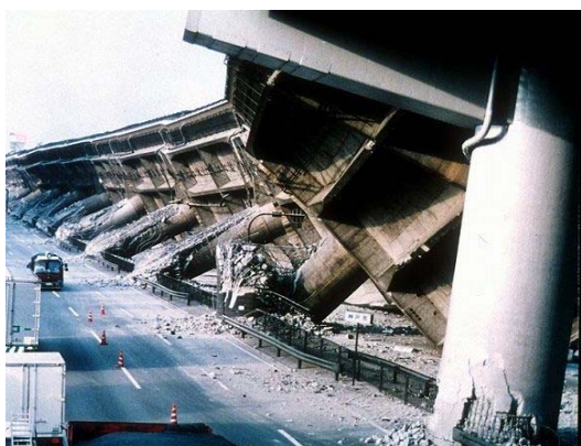
橋脚倒壊（ピルツ区間）
