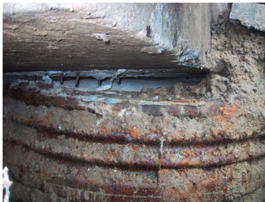
斜面崩壊による A1 橋台深礎杭の露出
