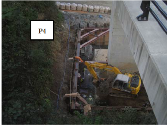
橋脚および橋台部の増し杭補強工事 (復旧工事)
