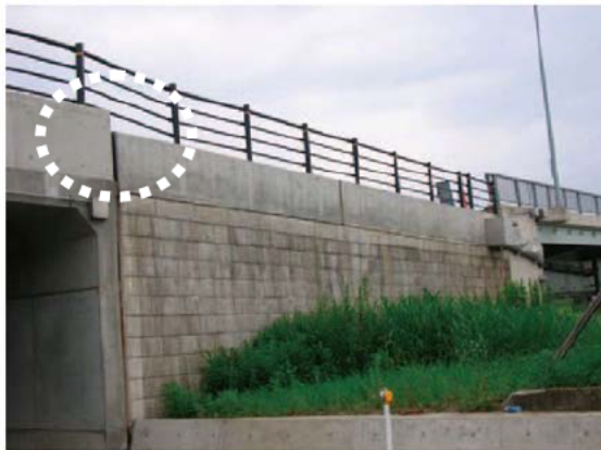
橋とボックスカルバート間の盛土の沈下 (左), 支承の残留変形 (右) (地震直後)
