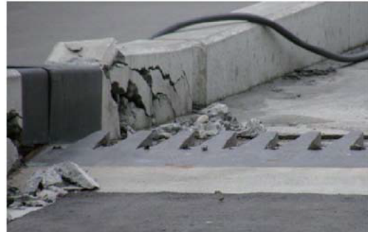
A1 橋台周辺地盤の地すべりによる直接基礎橋台の沈下，橋脚変形による桁衝突（地震直後）
