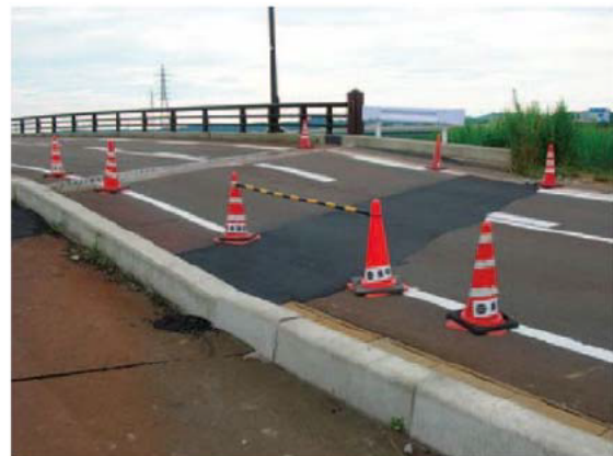
支承の残留変形と橋台パラペットの損傷（左），背面土沈下による段差（右） 写真-4.21 なごみ橋 32)
