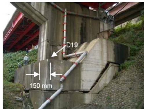
P1 橋脚断面急変部での損傷
