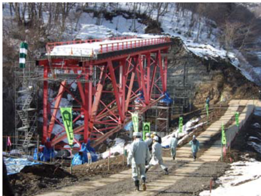
損傷した主構交換および橋台の新設工事（災害復旧工事の様子）
