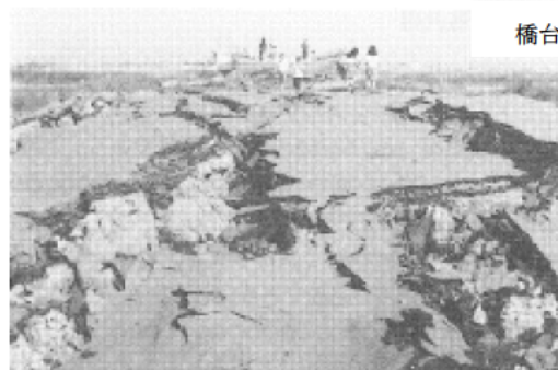
写真-4.14 五明光橋 (液状化による取付盛土の崩壊) 30)
