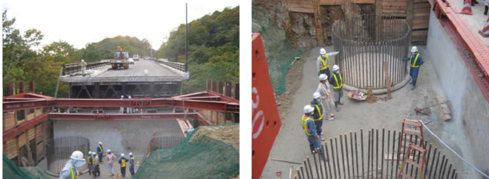
A1 橋台の復旧工事 (増し杭による補強)
