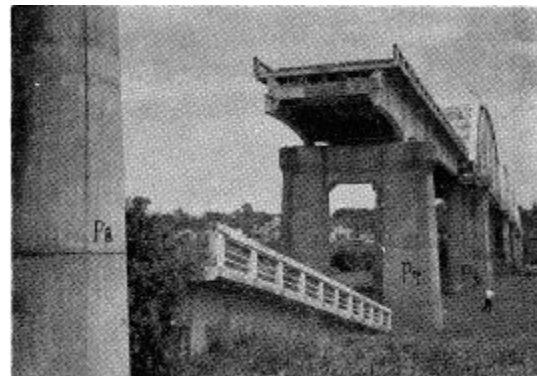
写真-4.13 錦桜橋（ゲルバー吊桁の落橋）29)
