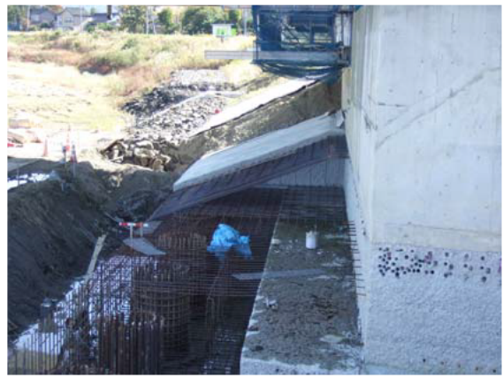
橋台の増し杭補強（復旧工事） 写真-4.20 豊田橋 32)
