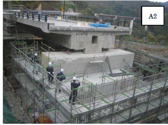
橋脚および橋台部の増し杭補強工事 (復旧工事)
