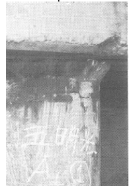
橋台杭頭部の亀裂
