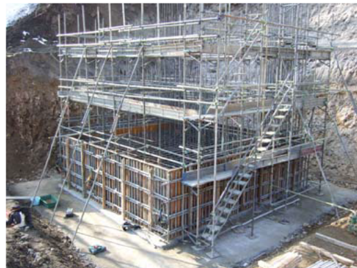
損傷した主構交換および橋台の新設工事（災害復旧工事の様子）
