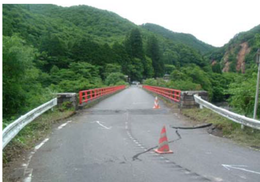
A2 橋台の段差・路面割れ、橋台パラペットコンクリートの剥落と剥離
