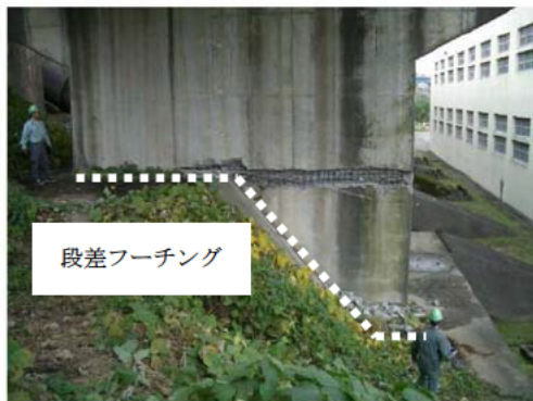
P1 橋脚断面急変部での損傷
