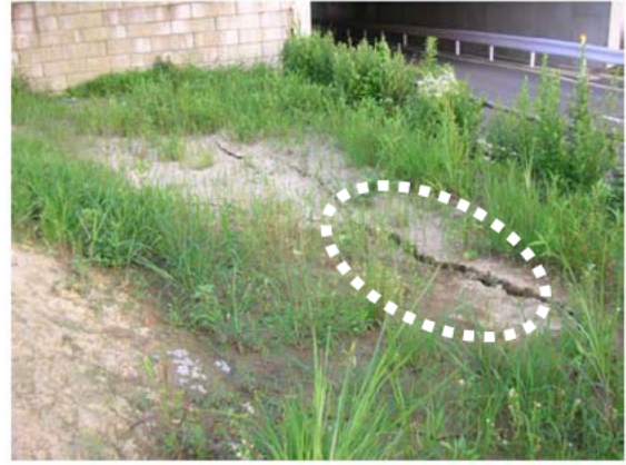
豊田橋全景 (左), 堤体の沈下 (右)
