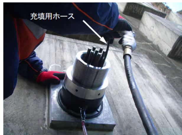
写真 5.14 防錆油の充填状況（例）
