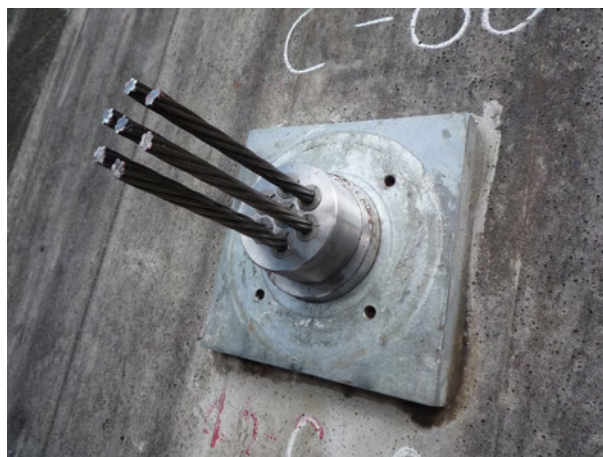
写真 5.2 防錆油の除去（例）
