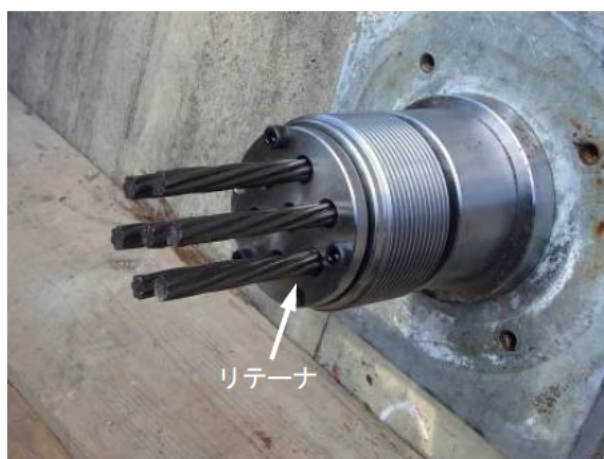
写真 5.4 リテーナの取付け (例)
