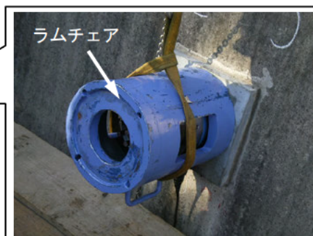
写真 5.8 テンションロッドの取付け（例）
