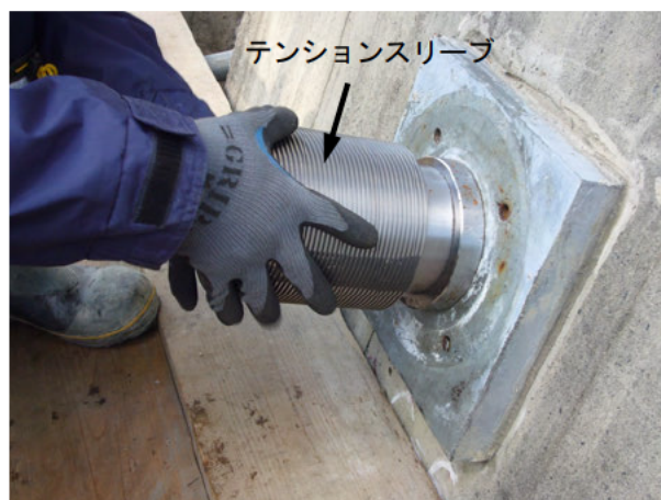
写真 5.5 テンションスリーブの取付け（例）
