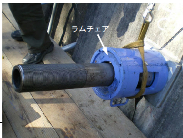
写真 5.9 ラムチェアの取付け（例）
