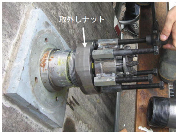
写真 5.18 ジョイントスリーブの取外し状況 (例)
