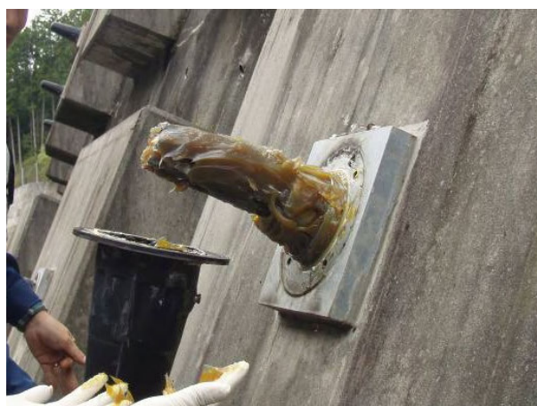
写真 5.1 アンカーヘッドキャップの取外し（例）
