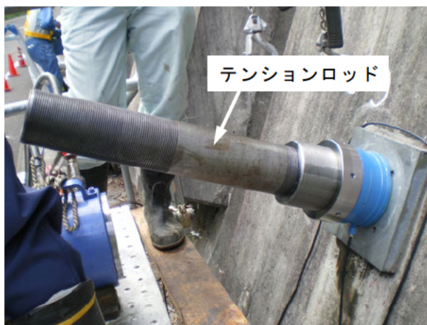
写真 5.8 テンションロッドの取付け（例）
