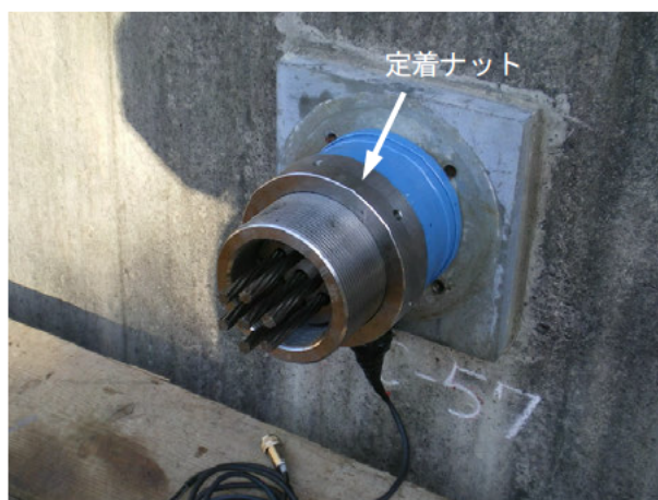
写真 5.7 定着ナットの取付け（例）
