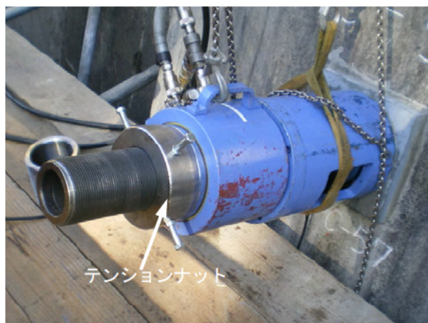
写真 5.11 テンションナットの取付け（例）
