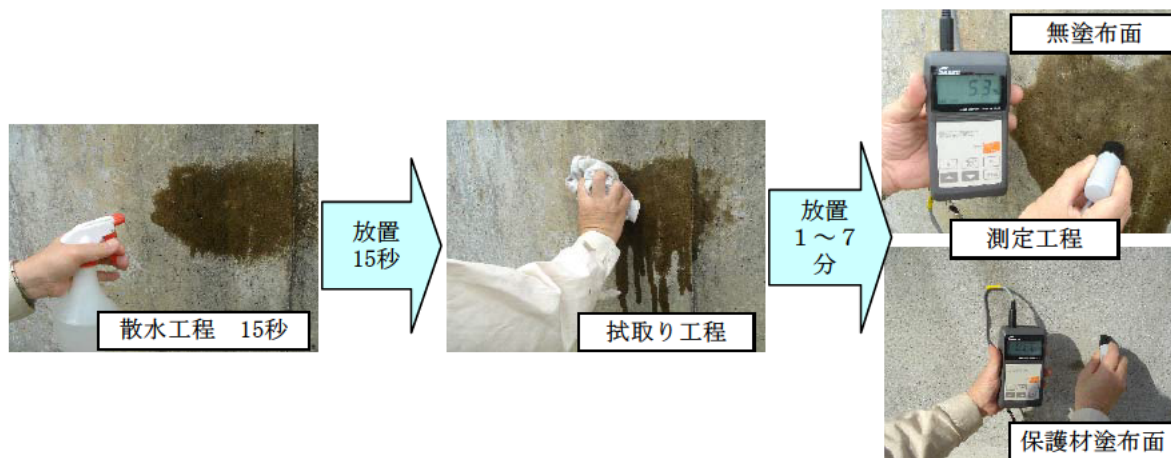
図－IV.2.14 測定状況
