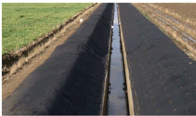
写真－29 防草シート
