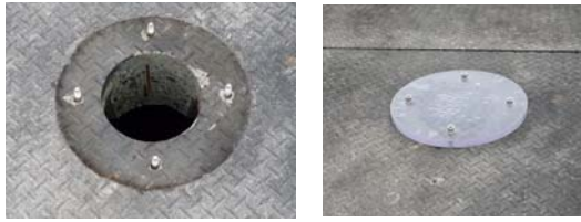
写真-24 カメラ挿入用点検穴
