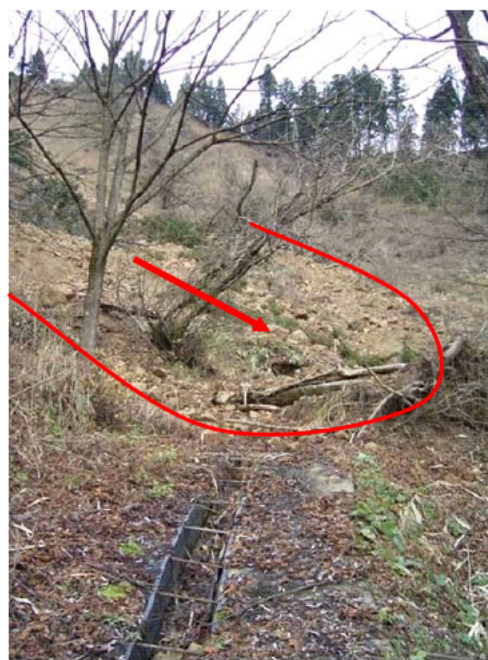
写真-4 小崩壊による土砂に埋まった水路
