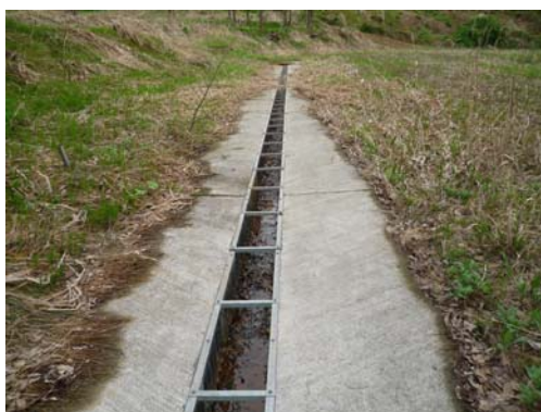
写真－28 水路両側面のコンクリート張り
