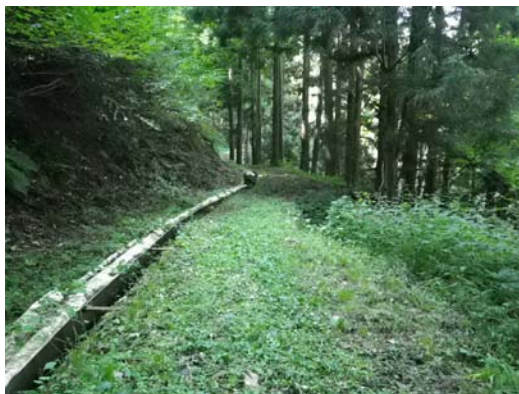
写真－32 廃棄されたガードレールを利用した水路の蓋
