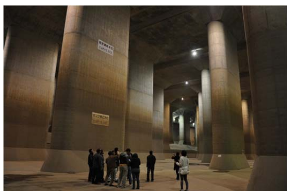
首都圏外郭放水路 調圧水槽
