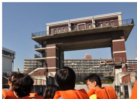
荒川ロックゲート
