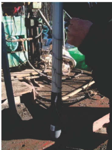
写真3-25 ワイヤ取り付けの事例
