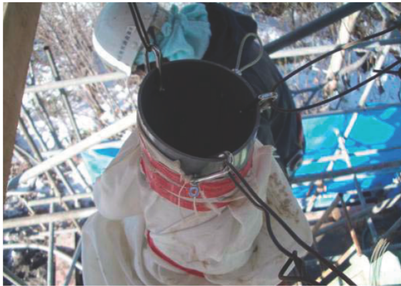
写真3-24 塩ビ管の吊るし部の例
