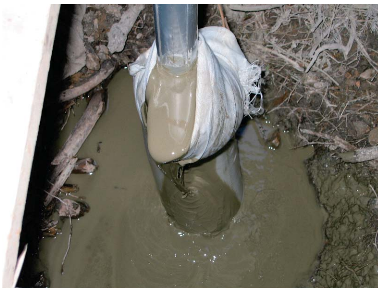
写真3-27 充填材が上昇している孔口の確認状況
