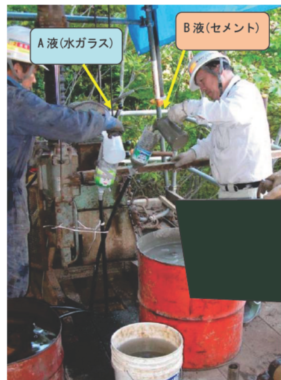
写真3-33 水ガラス・セメント注入状況
