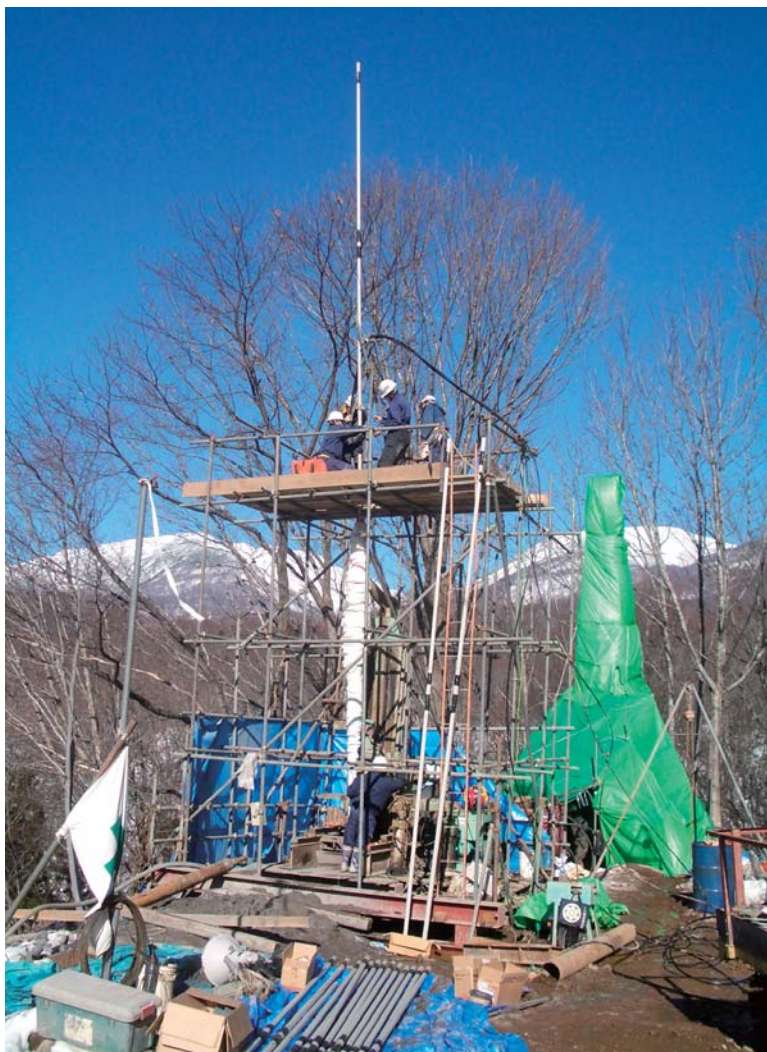
写真3-3 ガイド管の組立足場の仮設例
