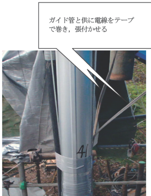
写真3-31 電線貼付け状況
