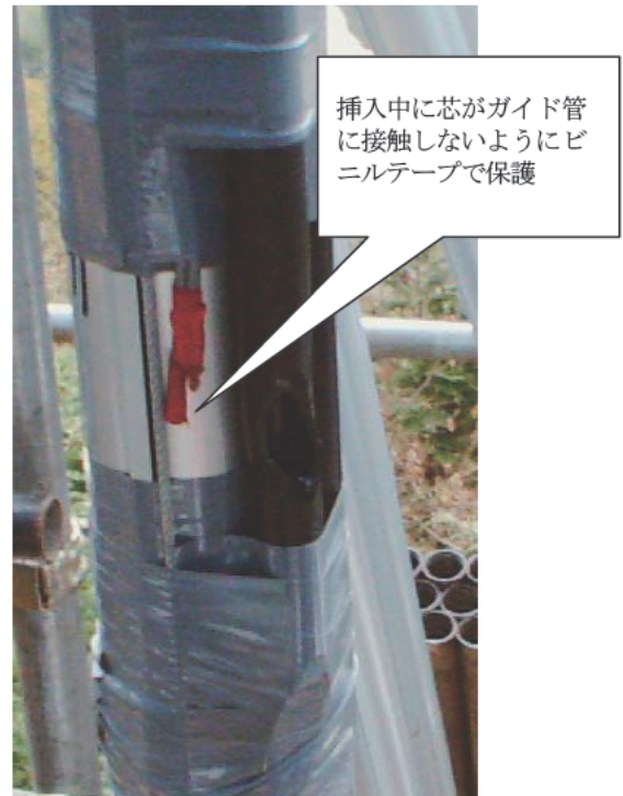
写真3-30 2芯電線設置状況
