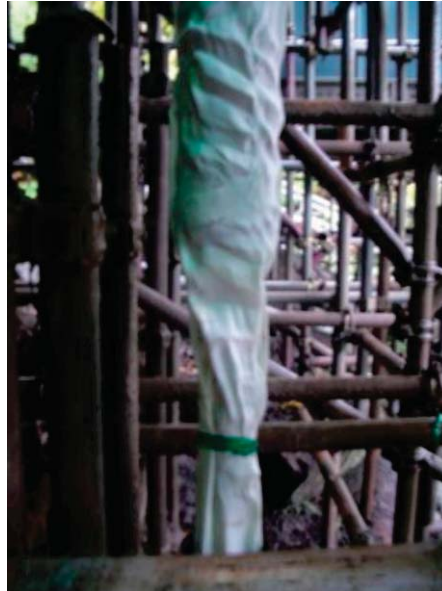
写真3-26 パッカーが膨らまないように軽く固定した事例
