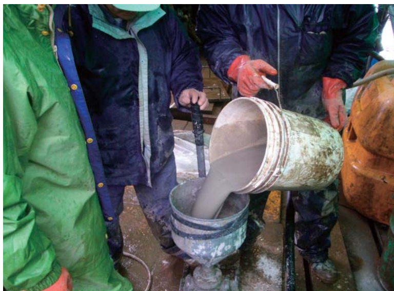
写真3-28 充填作業の状況の例 手押しポンプを使用 水100L, セメント2袋(50kg), 粘土2袋(50kg) 出来上がり量120L程度
