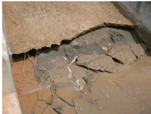
写真-3.21 短繊維混合補強土下側の状況
