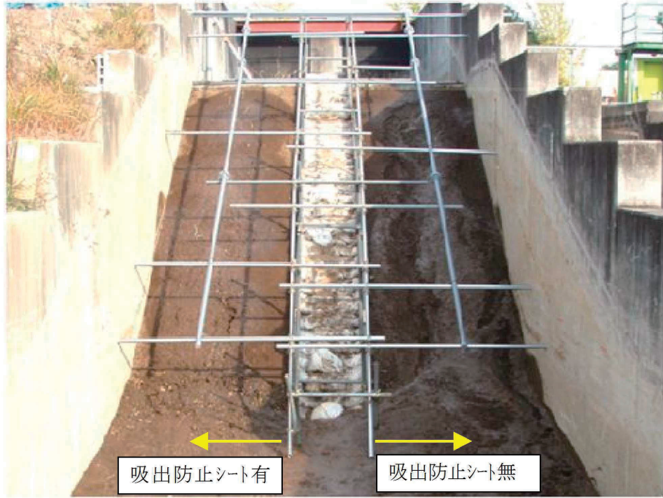
写真-2.23 堤防裏のり表面の状況（正面から）
