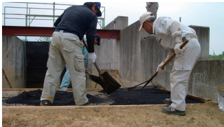
写真-3.12 アスファルトの投入状況
