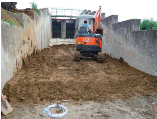
写真-3.10 堤体材料の敷均し状況
