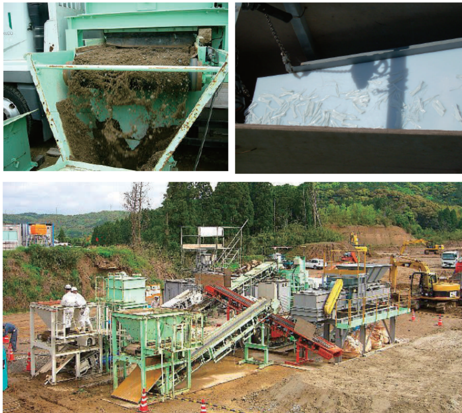
写真-3.3 回転式破碎混合方式（工法3）の施工例
