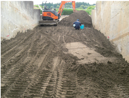
写真-3.6 基礎地盤転圧状況
