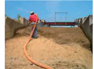
写真-9 施工状況(吹付)
