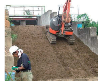
写真-9 施工状況(転圧)
