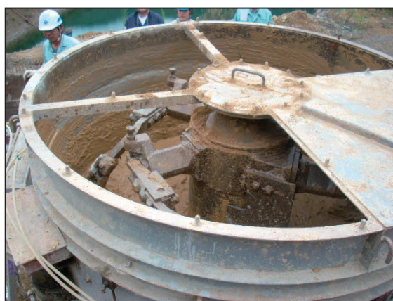
写真-5.1 強制攪拌方式の混合状況
