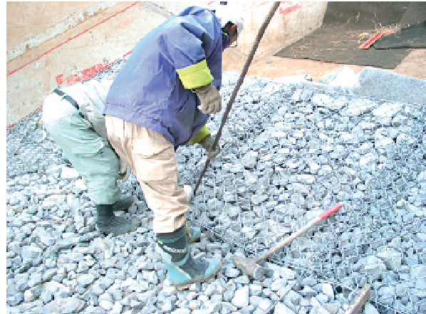
写真-4.2 のり尻工及びドレーン工 (中詰後にカゴ上蓋取付け)
