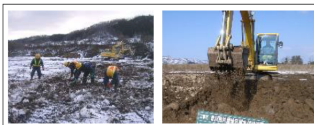
図-22 木片除去の状況 (人力(左)及びスケルトンバケット(右))
