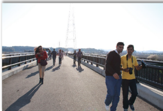
大河津分水路可動堰
