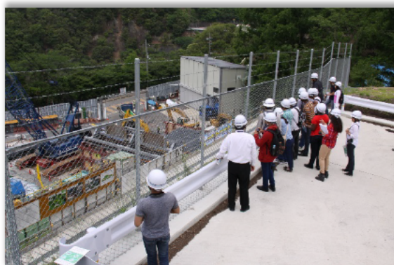
天ヶ瀬ダム再開発工事現場
