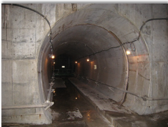
恩廻公園調節池
