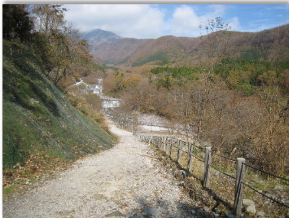
稲荷川砂防(日光砂防事務所)
