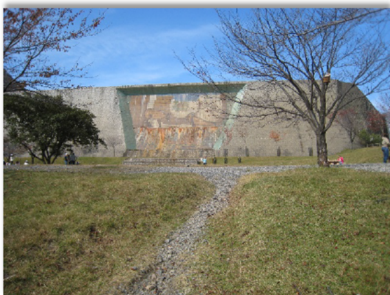
足尾砂防ダム(渡良瀬川河川事務所)
