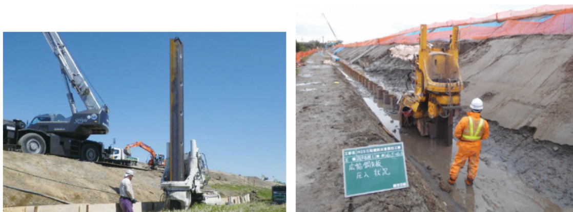
写真-9.4.1 矢板打設状況
