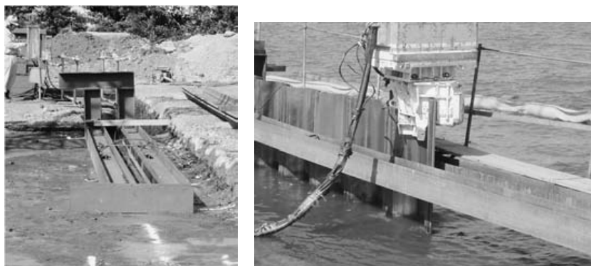
図-9.4.1 導枠工の例
