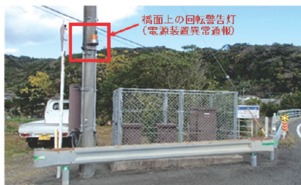
図－4 日常管理における通電の確認を支援する例 3)
