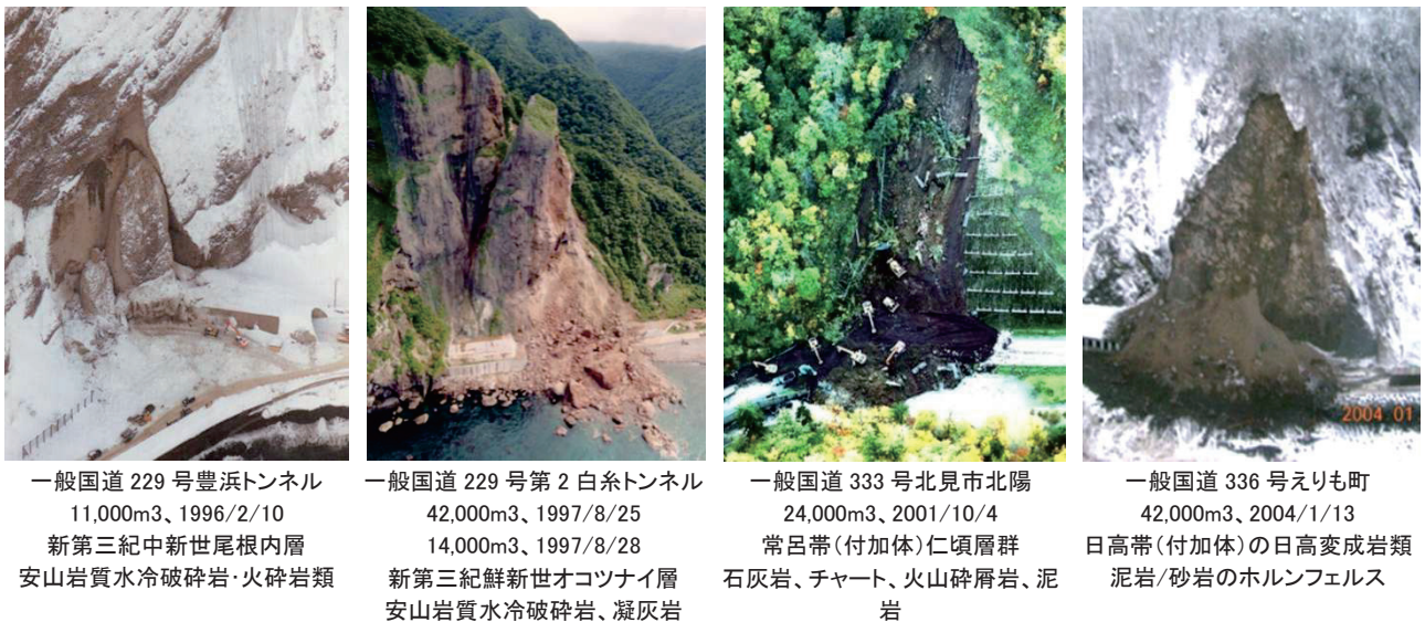
図－1 北海道における1万m 3 以上の大規模岩盤崩壊事例 1)2)3)4) (写真：北海道開発局)
