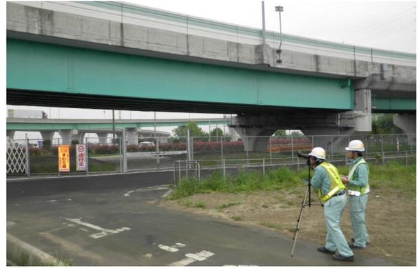
図 7.2.4 ウェブ外面の撮影状況
