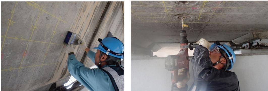
写真 4.2.1 鉄筋探査と削孔状況の例
