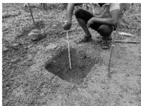
②穴の横に単管を取り付け、傾斜センサ取付金具を打込む
