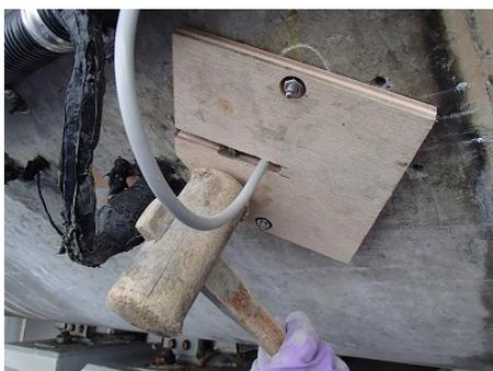
写真 3.2.2 モルタル充填後の養生板設置状況
