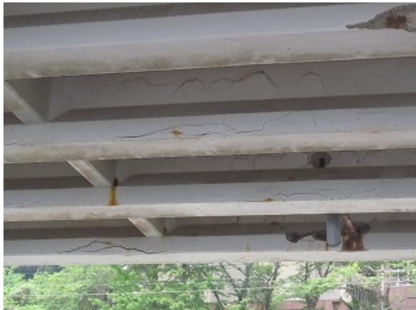
写真 5. 1. 1 断面修復・表面被覆箇所の再劣化の例
