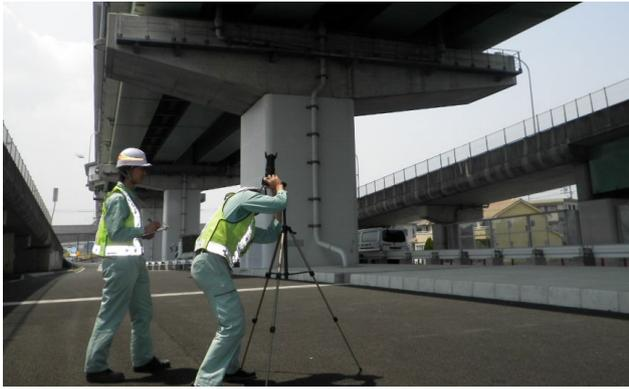
図 7.2.3 下フランジ下面の撮影状況
