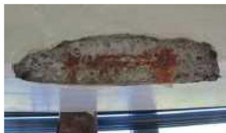
図 6.6.2 損傷状況 (剥離, 内部鋼材腐食)
