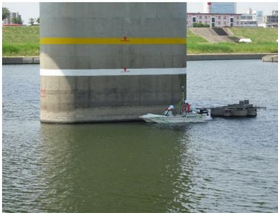
図 3.2.5 音響測深の実施例
