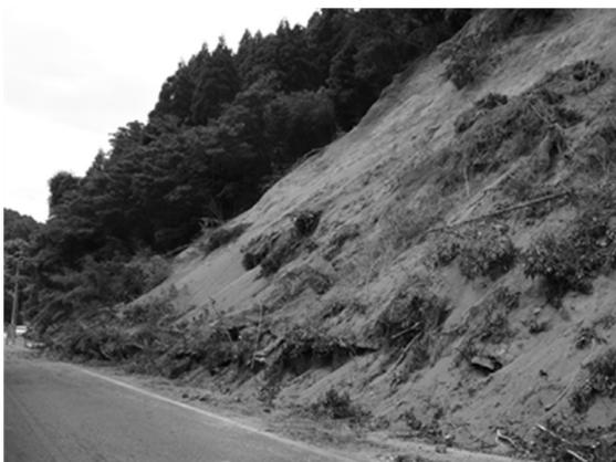
図 7.6.1 国道沿いのり面崩壊現場
