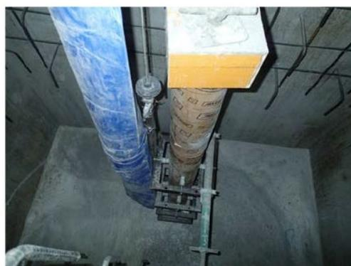
図 6.2.3 コンクリート充填補修の状況<sup>2)</sup>
