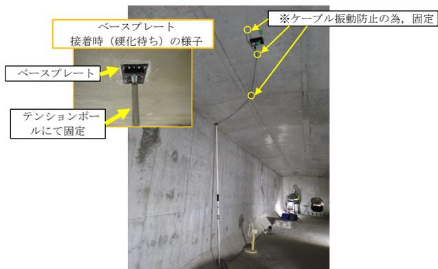
図 6.5.6 下フランジ面のセンサ設置状況
