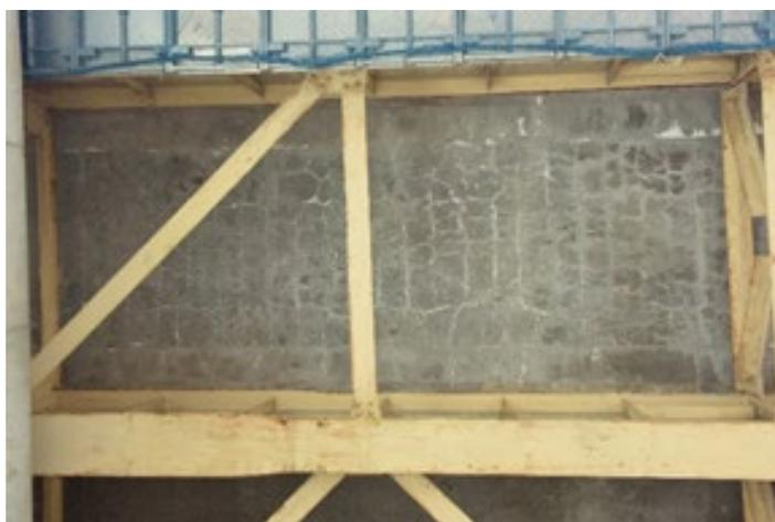
図 7.1.1 RC 床版の劣化状況 (床版下面)
