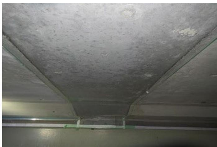
図 7.3.1 プレキャスト PC 床版の場所打ち接合部（床版下面）
