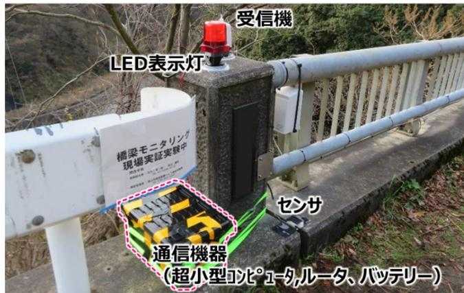
図 6.7.9 モニタリングシステムの設置状況
