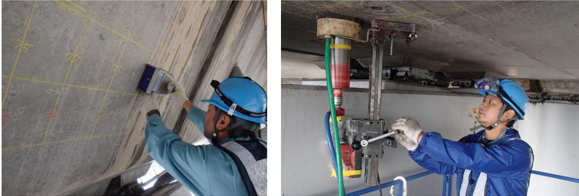
写真 3.2.1 鉄筋探査と削孔状況の例
