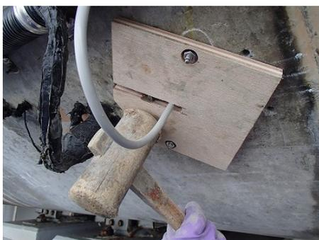
写真 4.2.2 モルタル充填後の養生板設置状況
