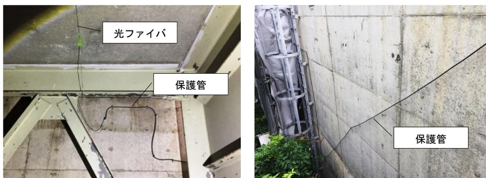
図 5.2.5 光ファイバの橋台部の配線状況
