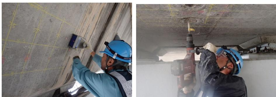
写真 5.2.1 鉄筋探査と削孔状況の例
