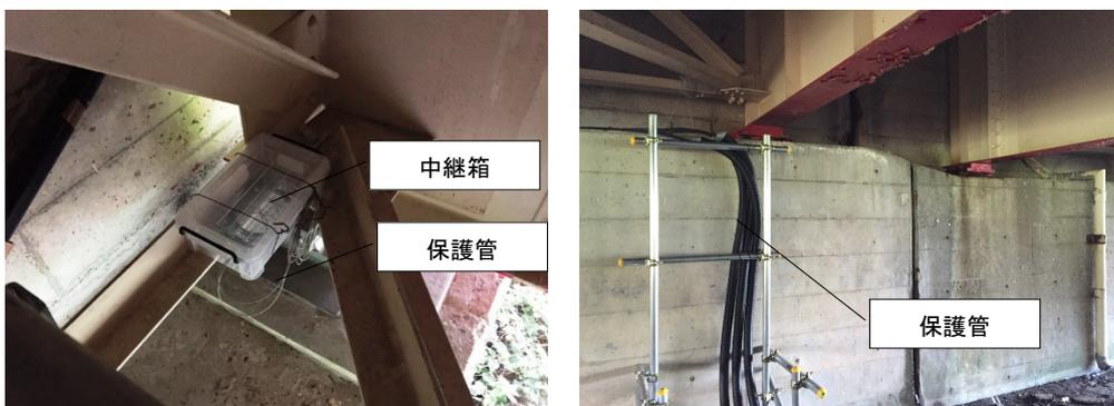
図 3.2.5 光ファイバの橋脚部の配線状況（左：中継箱，右：保護管での配線）
