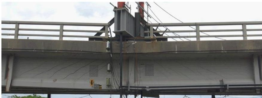
図 6.6.11 桁中央部の変形状況
