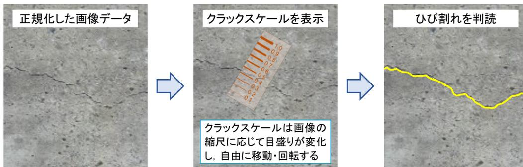
図 2.2.5 CADを用いたひび割れ判読の例
