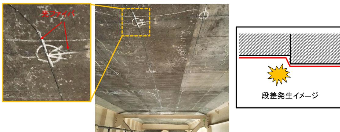
図 3.1.1 床版下面へ光ファイバの設置例
