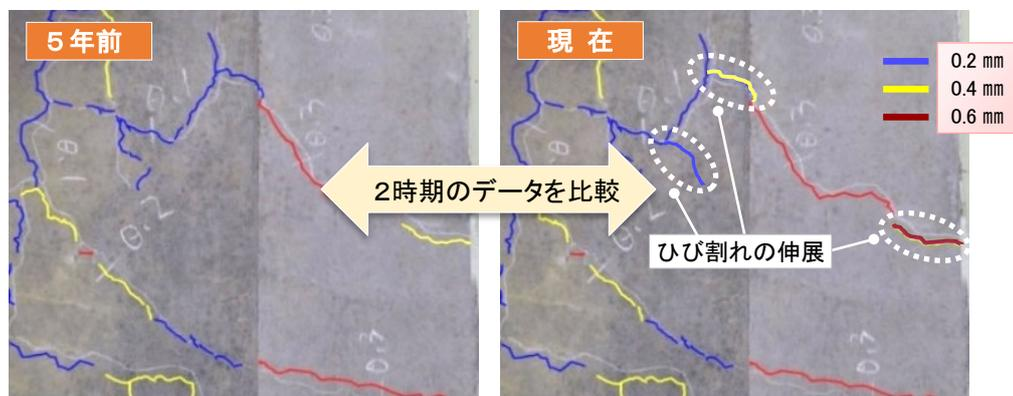
図 2.3.2 2時期のひび割れ分布図による比較例
