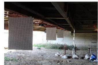
図 9.1.3 格子シート設置状況
