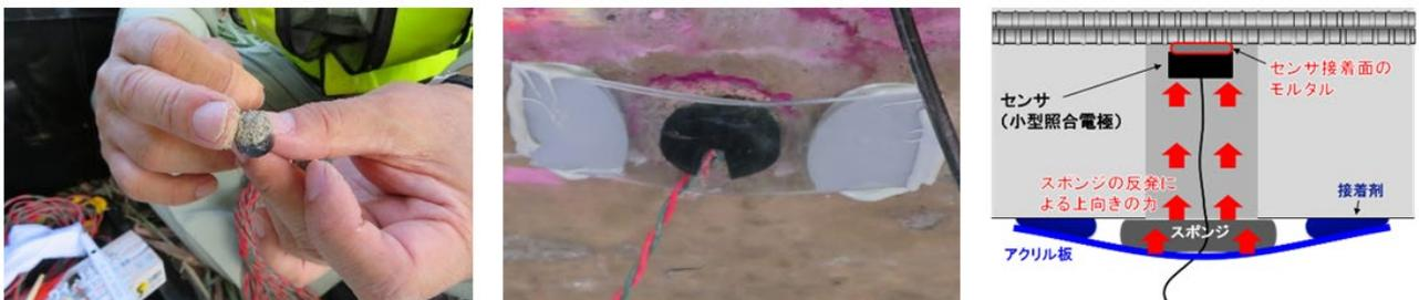
図 6.3.7 小型照合電極の設置時の状況
