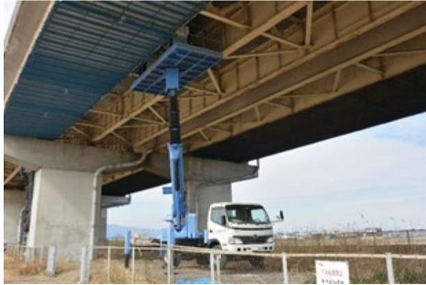
図 7.1.4 高所作業車による作業状況
