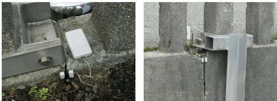
図 5.2.2 マグネット式センサの設置例
