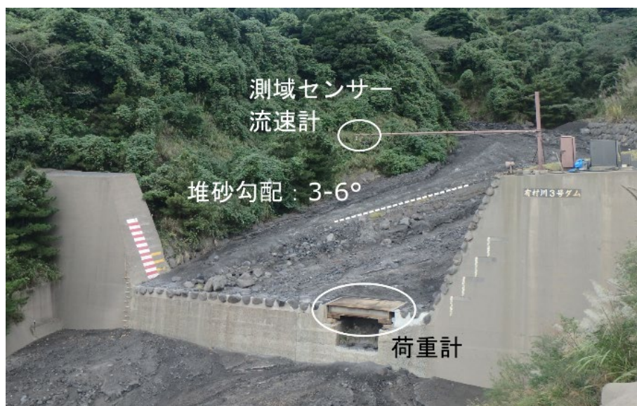
図 16 2019年10月18日に撮影した堰堤における観測機器の配置
