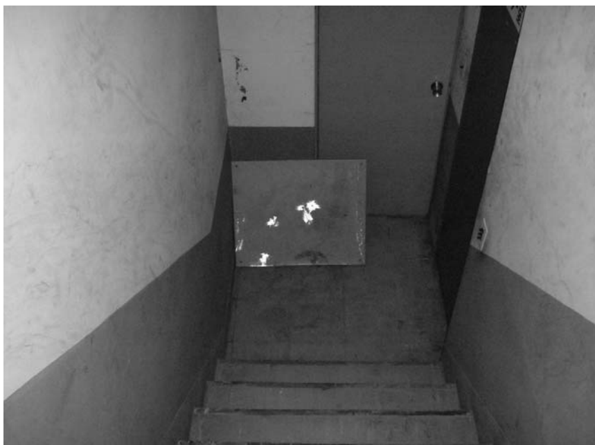
写真 5. 1. 11 フラッシュ撮影でのターゲット反射状況写真：撮影距離約 5m
