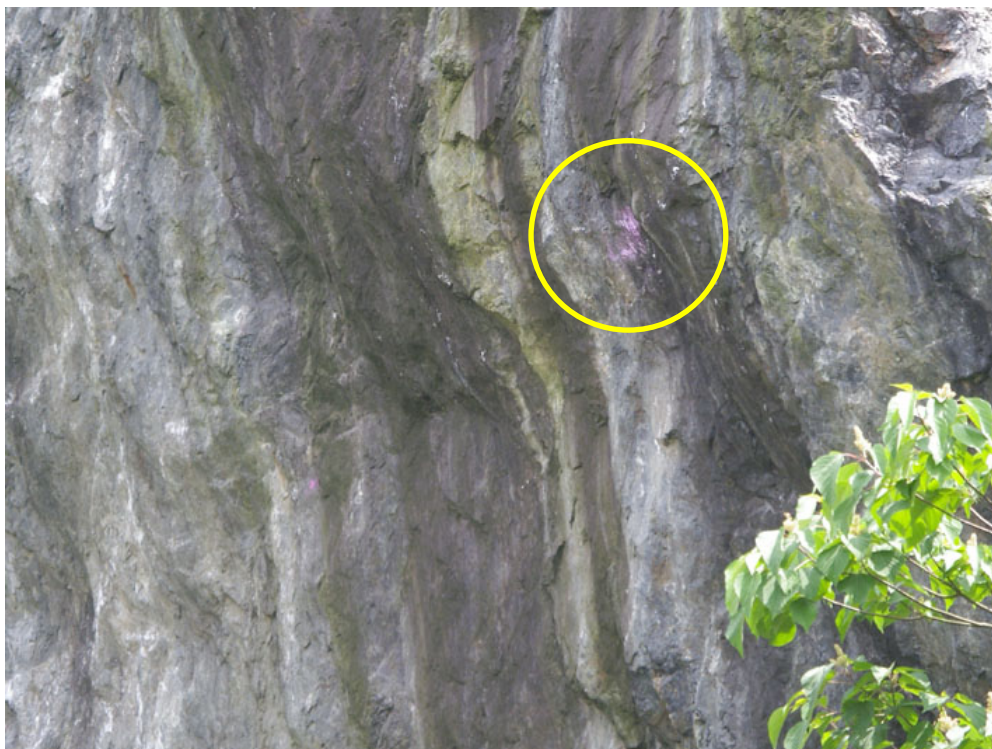
写真 6.2.3 (2) 設置 73 日後の状況（平成 19 年 6 月 27 日）
