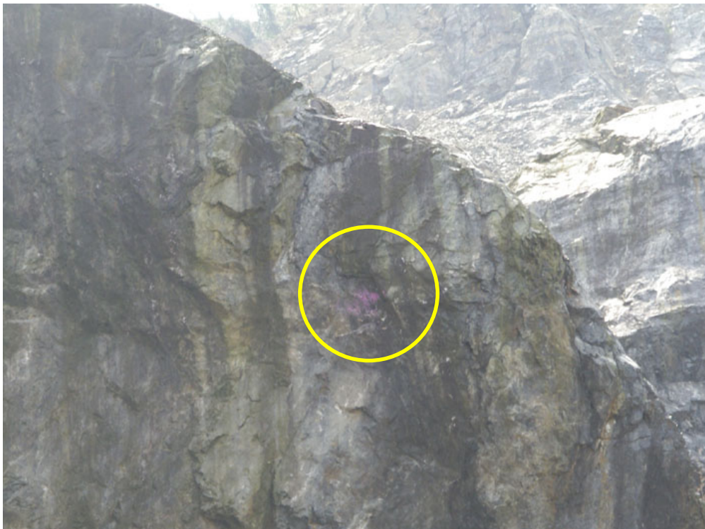
写真 6.2.3 (1) ターゲット設置直後の状況（平成 19 年 4 月 15 日）
