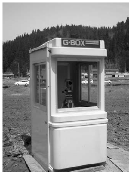
写真 2.2.3 測距儀の設置状況
