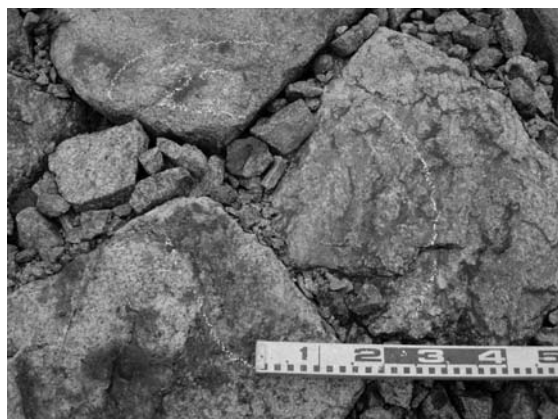
写真 3.5.15 計測用ターゲット設置例
