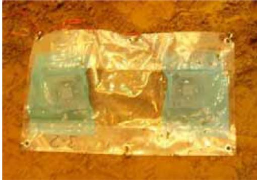
写真4. 2. 52 シート型センサ設置状況
