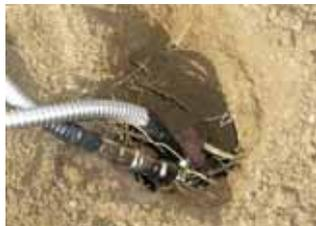
写真 4.1.9 埋設型設置状況
