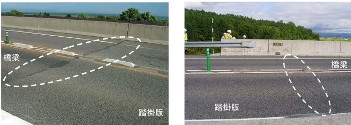
図 1.1.3 橋台背面の舗装のひび割れ状況
