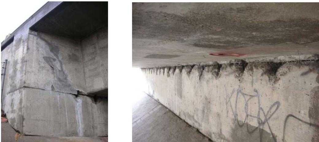
図 1.1.5 斜角を有する橋梁での損傷事例
