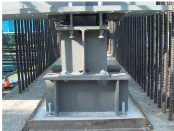
図 3.4.1 鋼上部構造の仮支承の例
