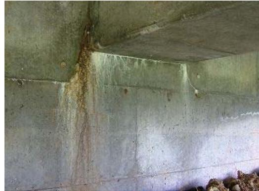
図 2.3.9 主桁下面からの遊離石灰，錆汁の析出
