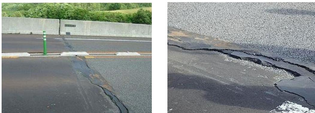
図 1.2.1 橋台背面の舗装の損傷例
