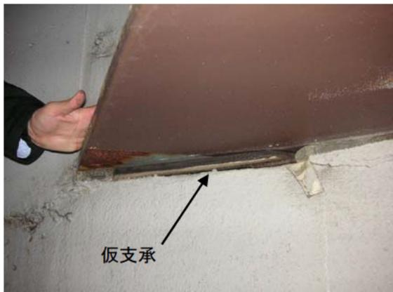
図 3.4.2 鋼桁下面に生じたひび割れ
