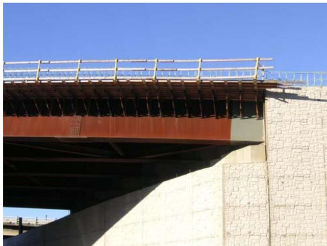
図 2.3.7 耐候性鋼材の桁端部塗装例 2
