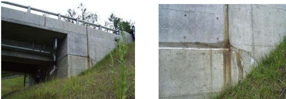
図 2.3.3 上部構造と橋台壁の接合部の損傷
