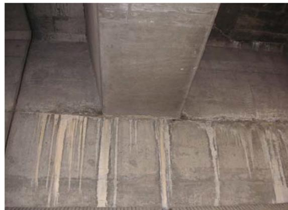
図 3.4.3 コンクリート桁打継目の遊離石灰の析出
