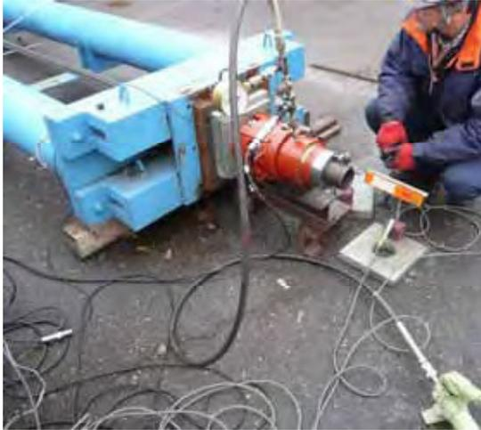
アンカーヘッド（緊張治具取付け）側
