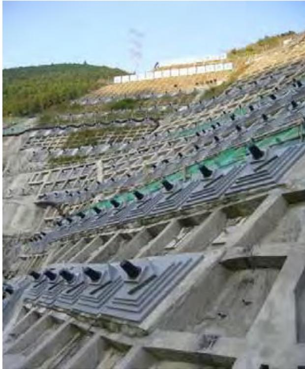
写真 11.14 ダム側面のグラウンドアンカー軸力測定実施状況 1
