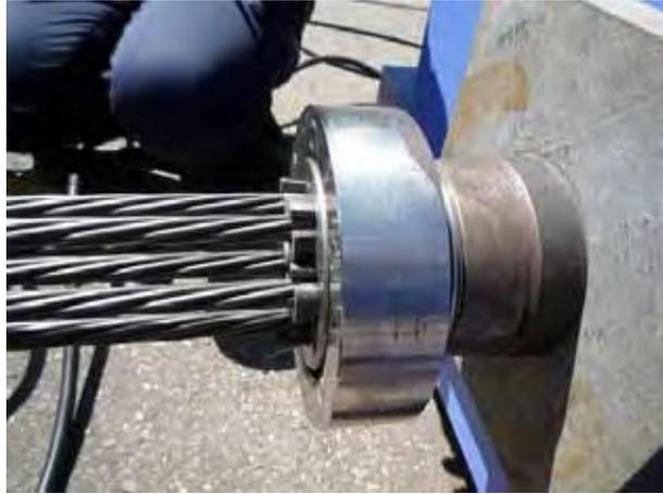
写真 11.31 取外し後のくさび状況
