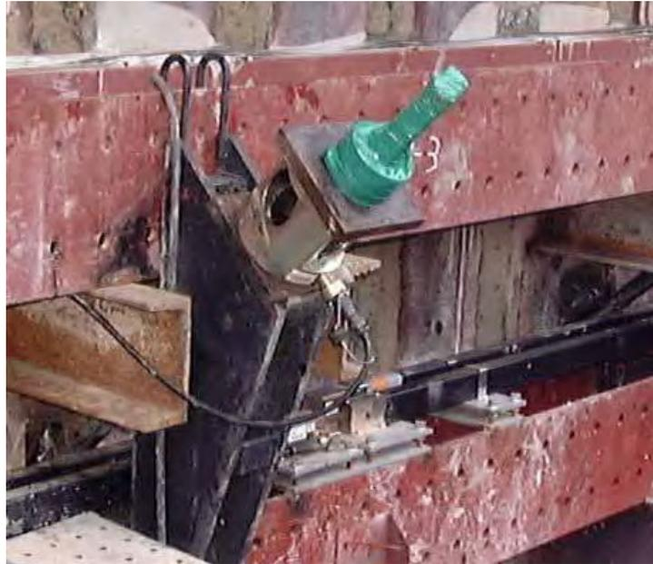
写真 11.12 山留め工事におけるアースアンカーの軸力測定実施状況
