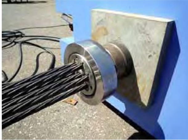
写真 11.25 取外しナットの取付け
