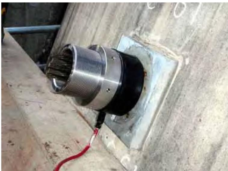
写真 10.65 荷重計取付け状況
