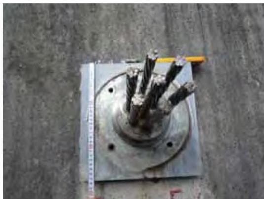
写真 10.4 アンカーヘッド構造 (正面)
