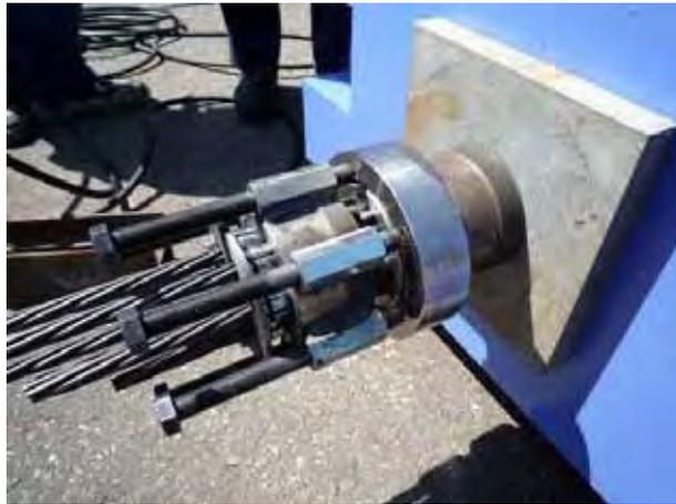
写真 11.29 ジョイントスリーブ取外し完了
