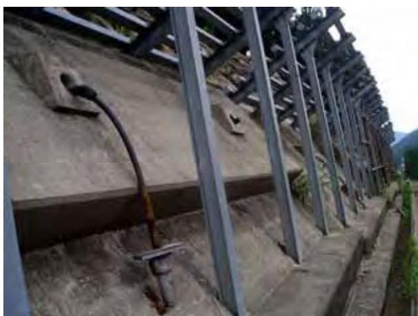
写真 1.1 地すべり滑動によるアンカーの破断事例
