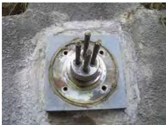
写真 10.2 アンカー頭部構造(正面)
