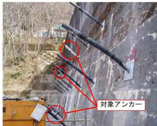
写真 11.17 砂防堰堤でのグラウンドアンカーの軸力測定実施状況
