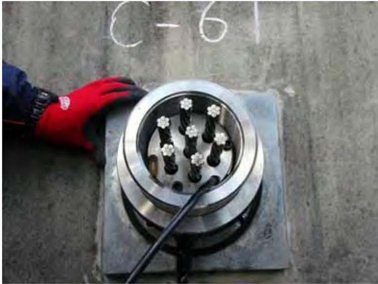
写真 10.95 防錆油充填状況
