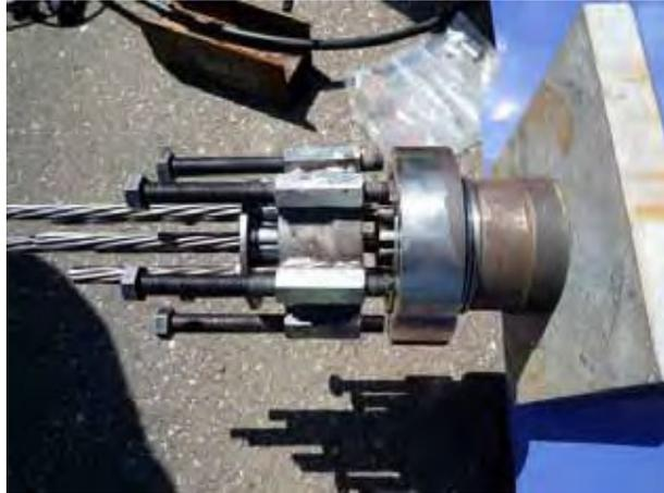
写真 11.28 ジョイントスリーブ取外し完了
