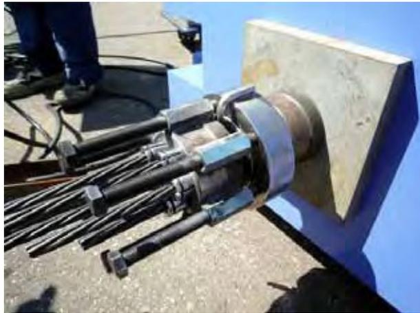
写真 11.26 反カスリーブの取付け
