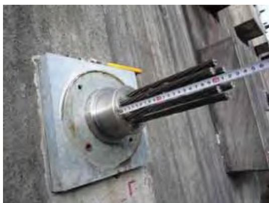
写真 10.3 アンカーヘッド構造 (斜め)
