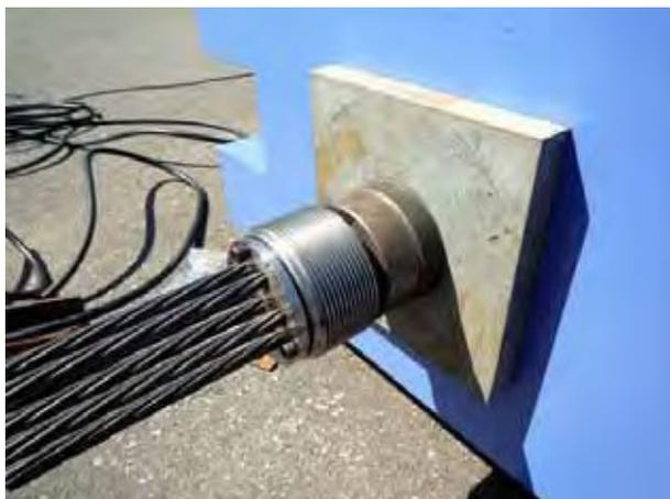
写真 11.23 ジョイントスリーブの取付け状況
