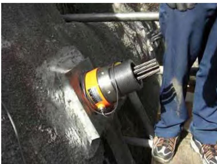
写真 10.15 荷重計取付け状況
