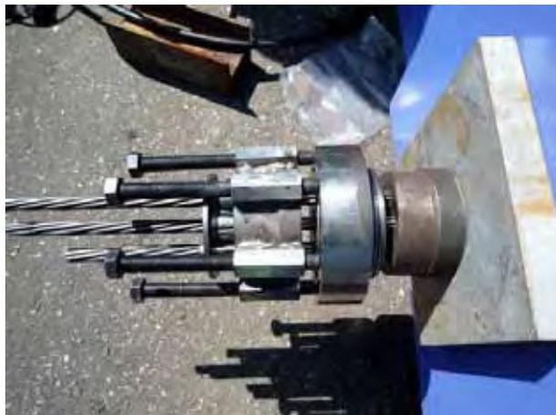
写真 11.27 反力ボルトの締付け
