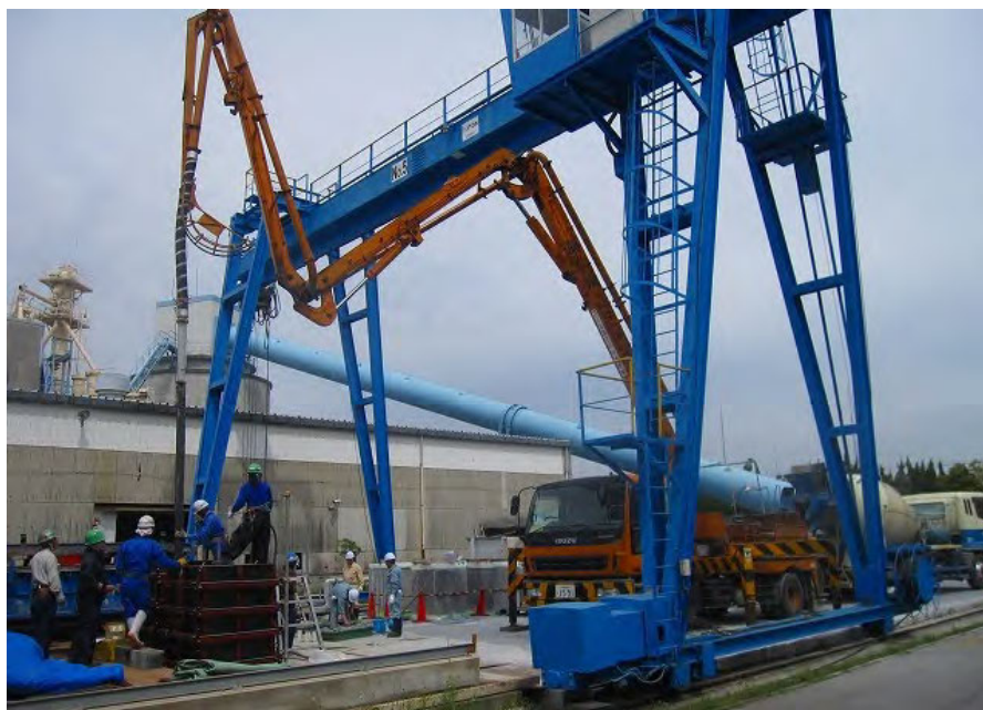
写真-5 コンクリートの打込み状況
