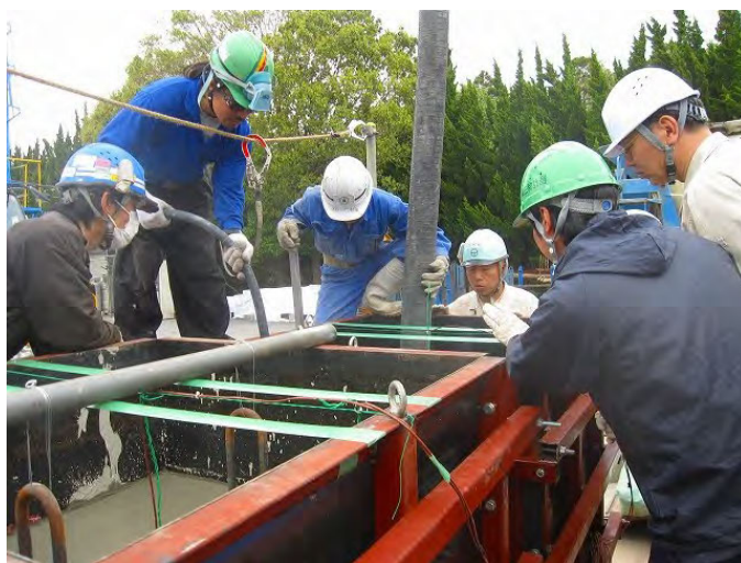
写真－8 コンクリートポンプ車による打込み状況
