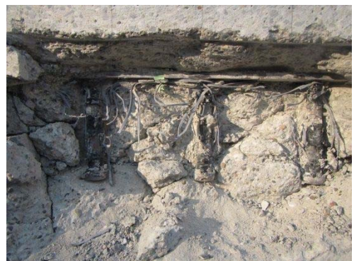
(d) 鋼桁下フランジ部スタッド
