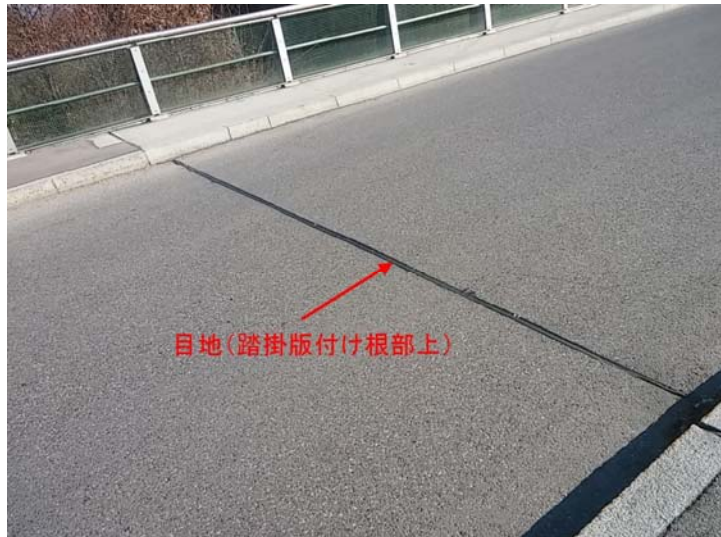
写真 2.4.2 ドイツでの踏掛版付け根部の目地設置例
