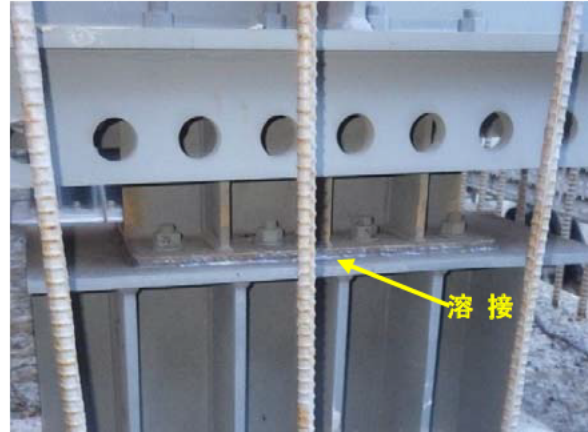
写真 3.4.3 溶接による固定
