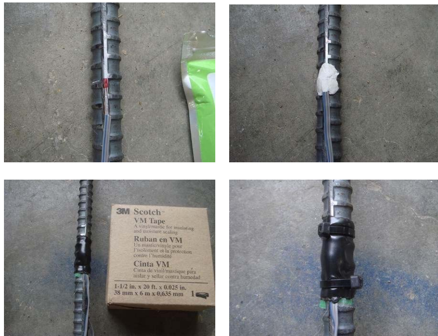
写真 4.2.1 ひずみゲージ貼付け養生状況
