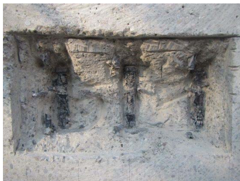
(c) 鋼桁上フランジ部スタッド
