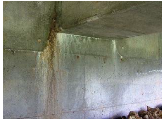
写真 2.3.3 上・下部構造接合部の主桁下面の損傷 写真 2.3.4 主桁下面からの遊離石灰, さび汁の析出
