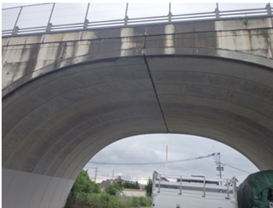
写真-2.16 クラウンでのヒンジの開き
