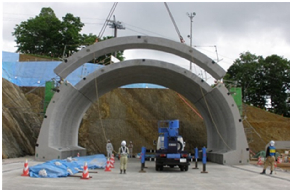
(b) 施工状況
