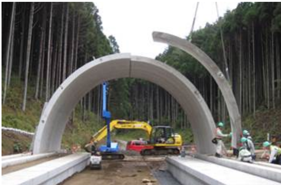
(b) 施工状況
