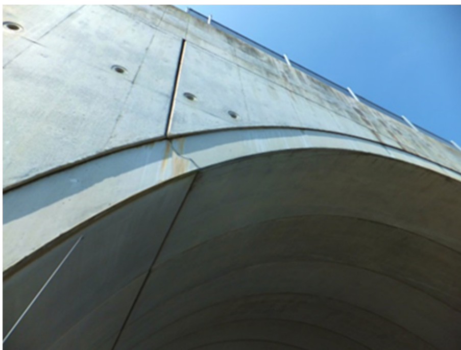
写真-2.10 面壁のはら見出し
