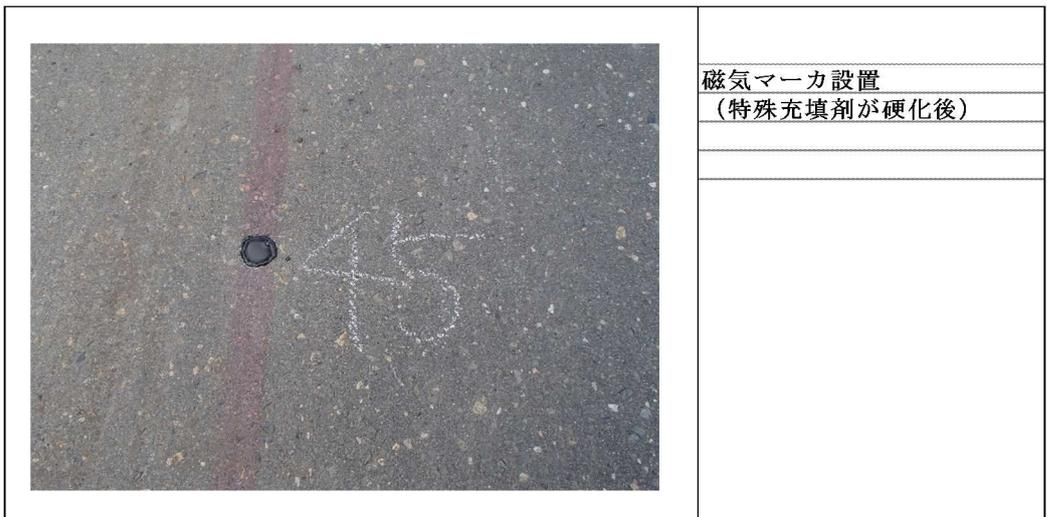
図-4.7 磁気マーカ（埋設タイプ）設置工
