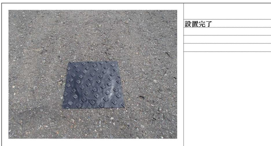
図-4.9 磁気マーカ（貼付タイプ）設置工
