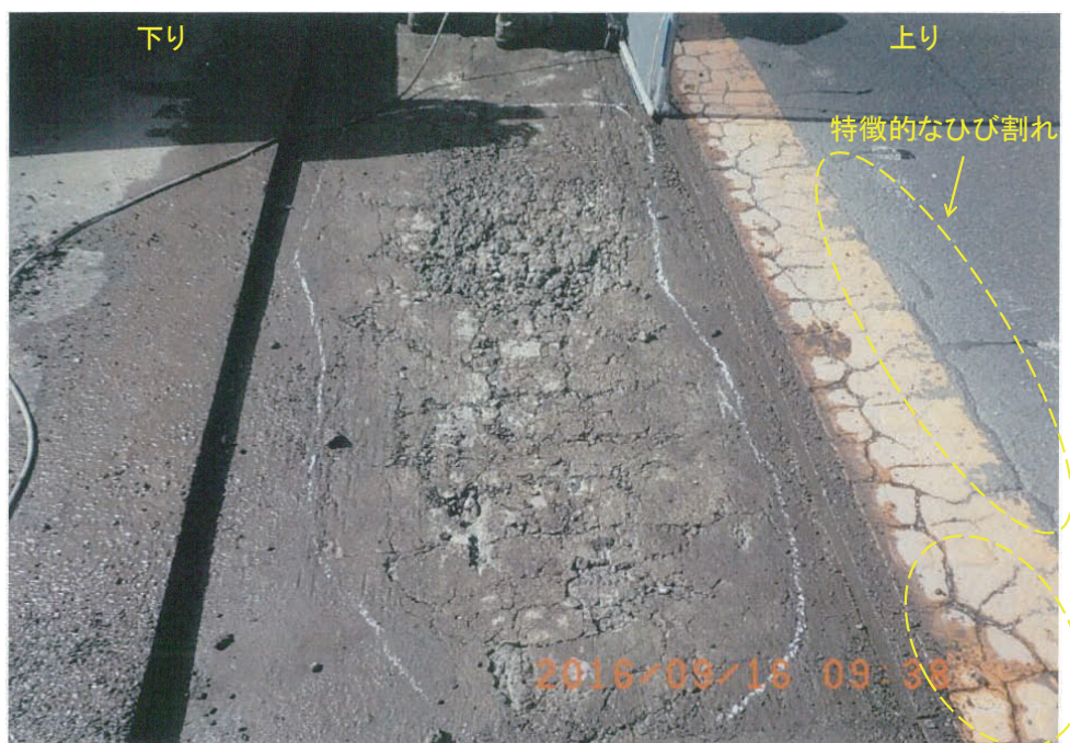
(a) 補修直前の床版上面，2016 年 9 月
