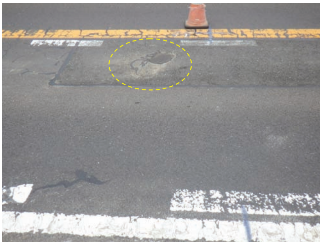
(a) 舗装の補修
