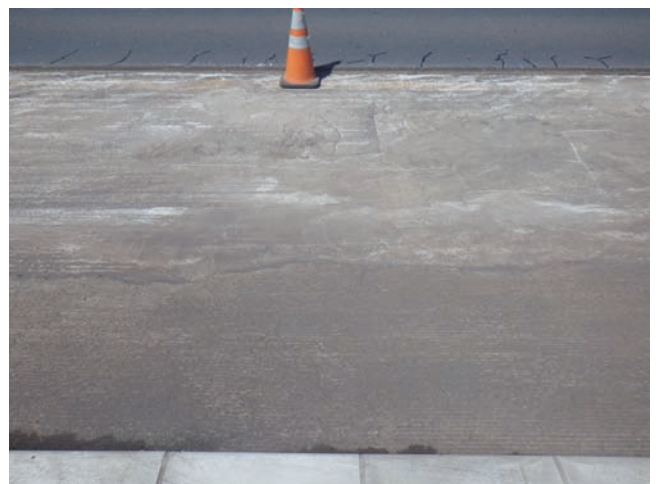
(b) 床版上面（下り側舗装除去時）
