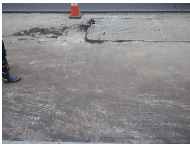
(b) 床版上面（下り側舗装除去時）
