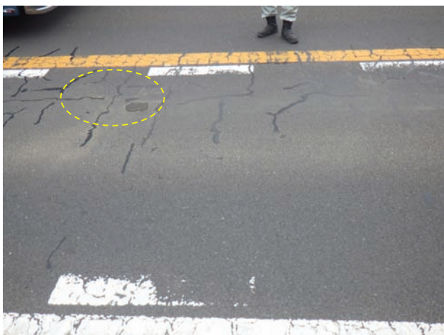
(a) 舗装の補修
