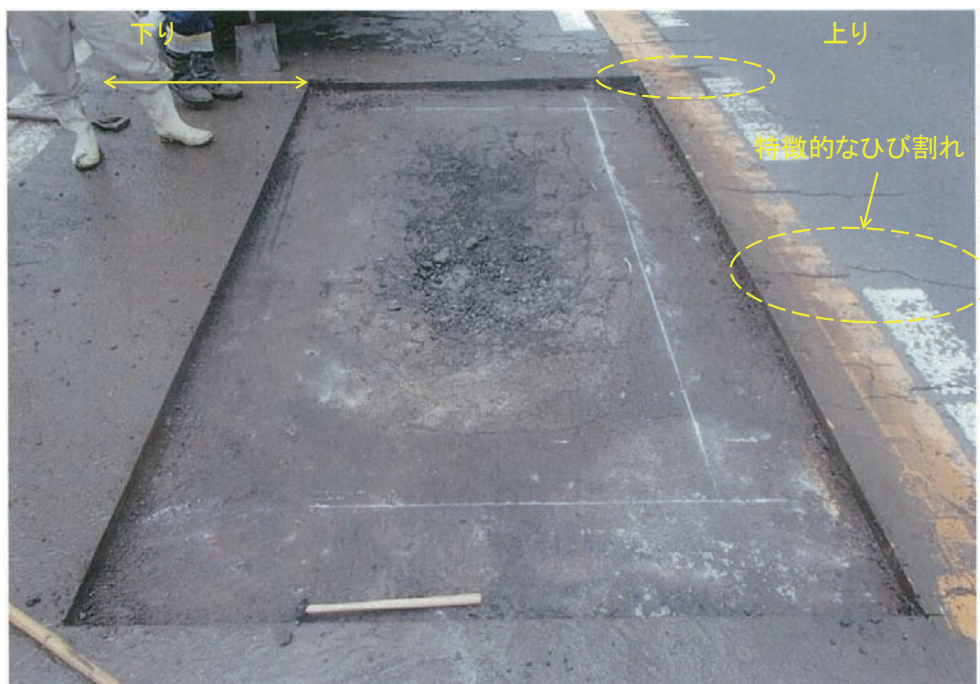
(a) 補修直前の床版上面，2015 年 9 月
