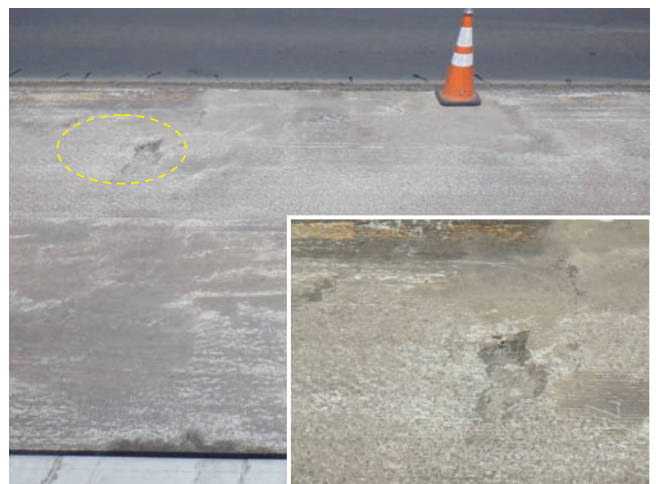
(b) 床版上面（下り側舗装除去時）
