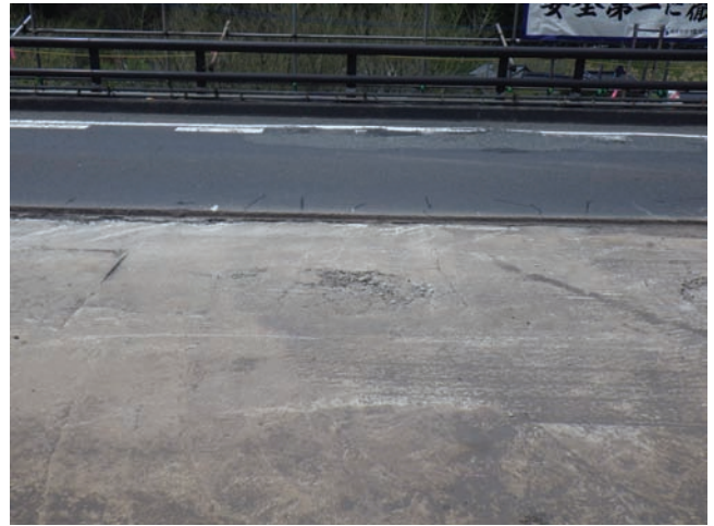
(b) 床版上面（下り側舗装除去時）
