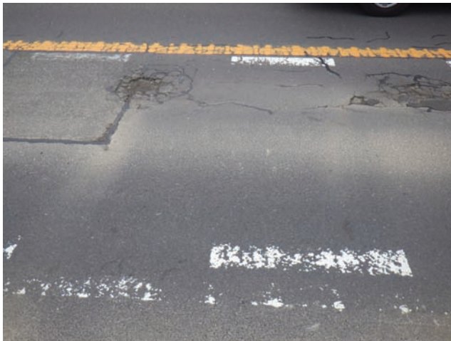
(a) 舗装の補修
