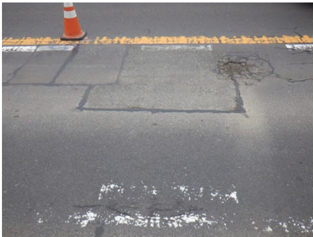
(a) 舗装の補修
