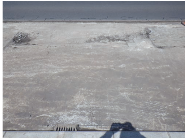
(b) 床版上面（下り側舗装除去時）
