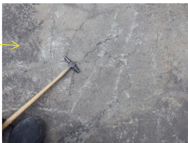
(e) センターライン付近の浮きとひび割れ
