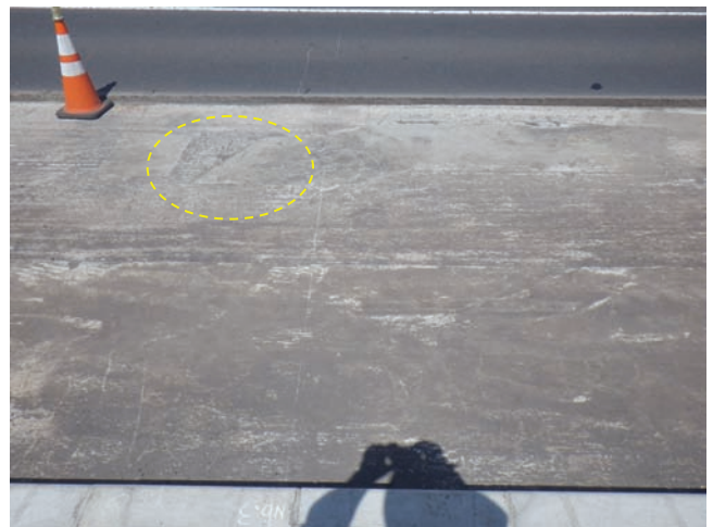
(b) 床版上面（下り側舗装除去時）
