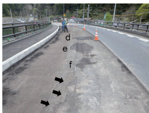
図-4.4.5 電磁波レーダのタイムスライス断面，床版上面写真，及び，床版上面の滞水の様子 (2)
