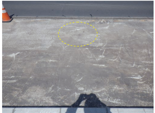
(b) 床版上面（下り側舗装除去時）
