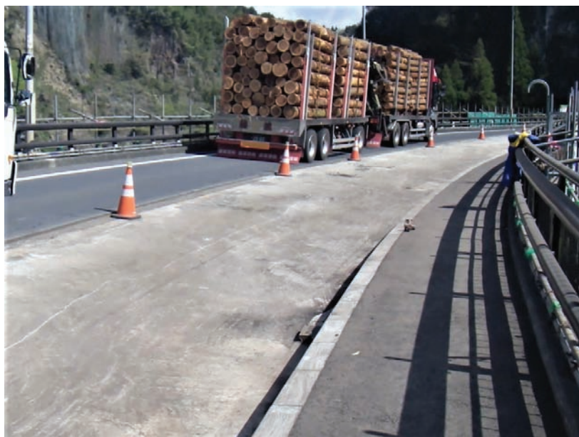
図-2.1.4 対象橋梁における大型車両の例（2019 年調査時）
