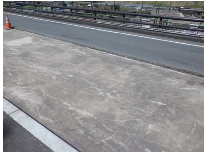
(b) 床版上面（下り側舗装除去時）
