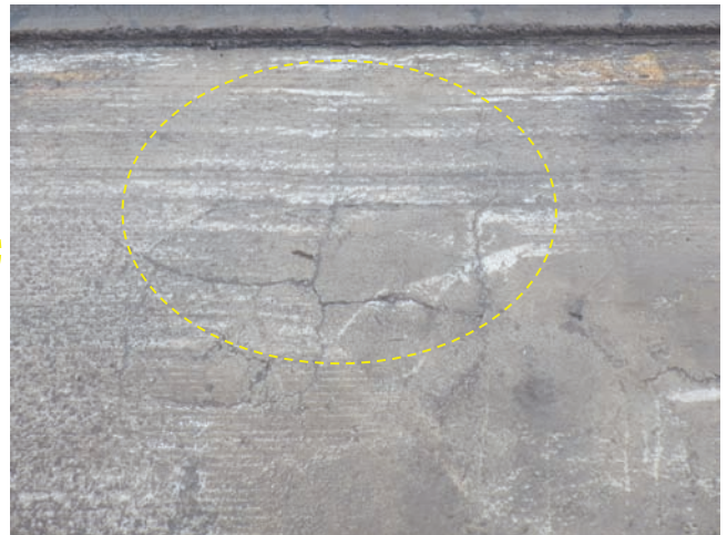
(b) 床版上面（下り側舗装除去時）
