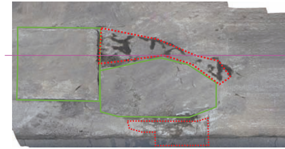
(a) 床版上面写真（舗装撤去後）
