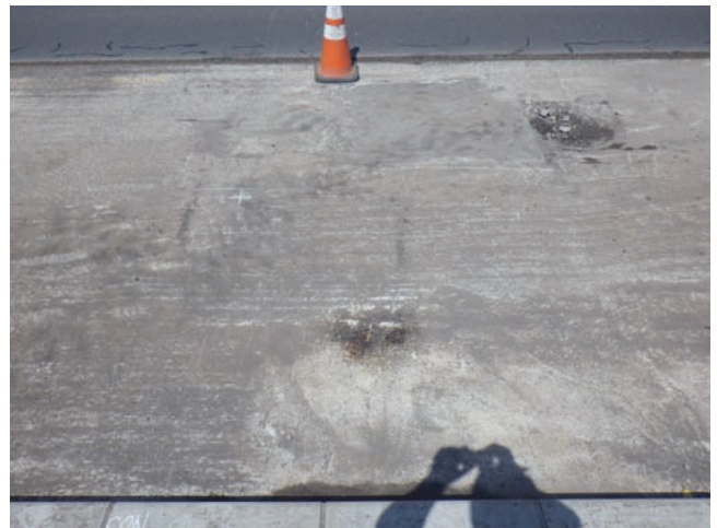
(b) 床版上面（下り側舗装除去時）
