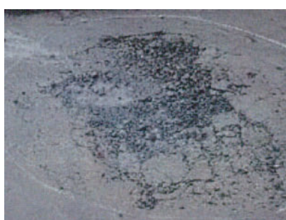
図-5.4.3 Y橋における床版コンクリートの土砂化の過程（想定）
