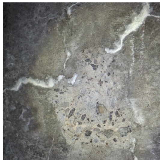
(a) 床版下面のポップアウトの例（右は黄色破線枠の範囲を拡大）
