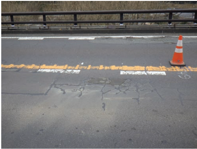
(a) 舗装の補修
