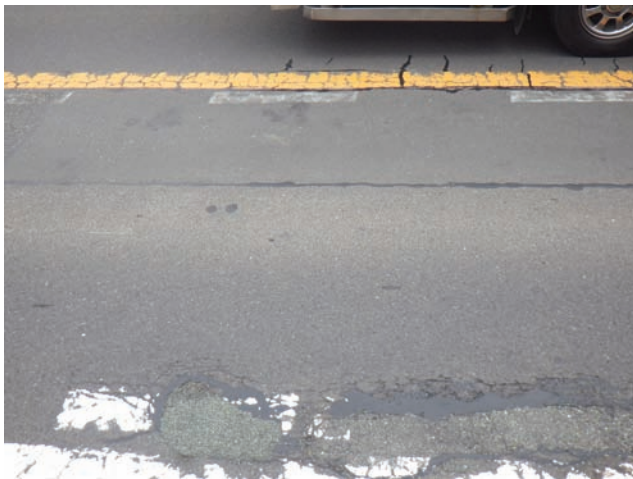
(a) 舗装の補修
