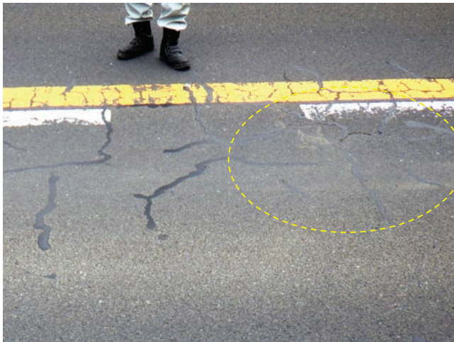
(a) 舗装の補修
