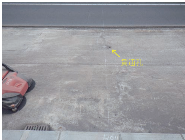
(b) 床版上面（下り側舗装除去時）
