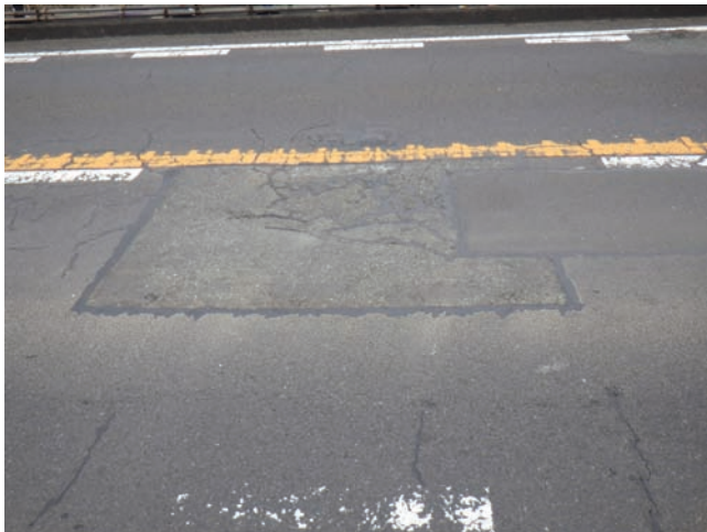
(a) 舗装の補修
