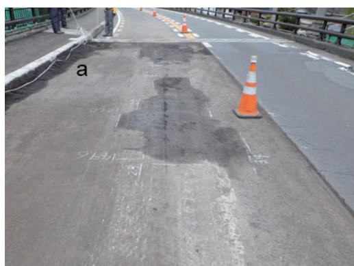
(d) タイムスライス断面1の滞水の様子
