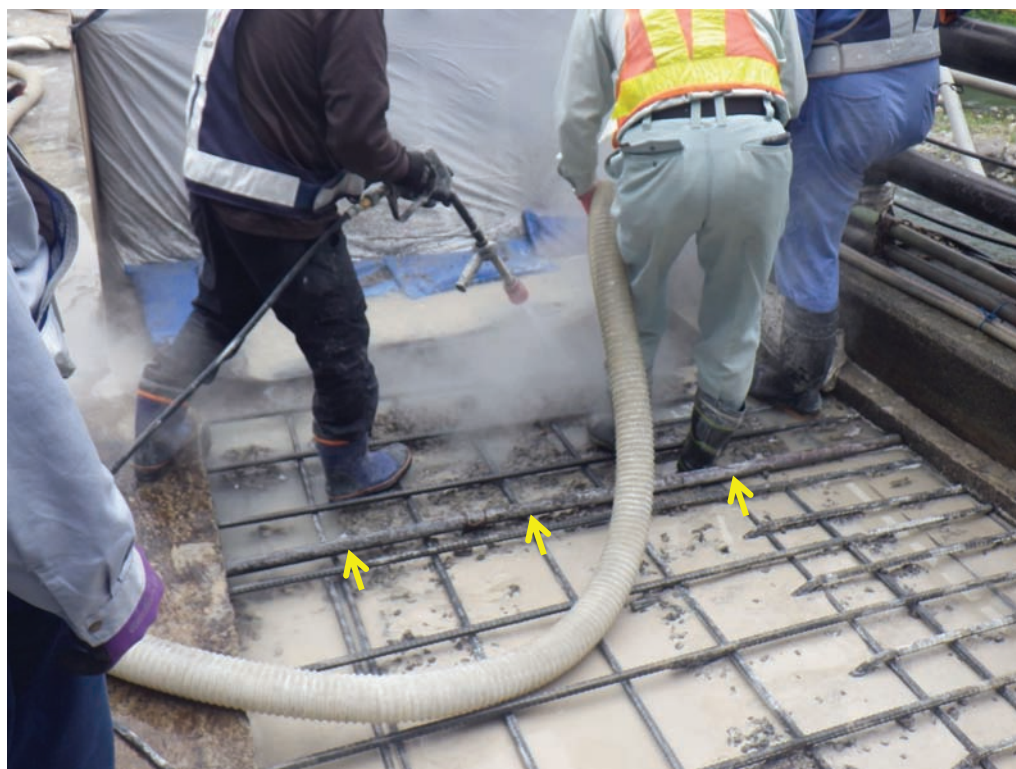
図-A1.4 A1-P1 間の RC 床版の貫通ひび割れ箇所に埋設されていた照明用電線管
