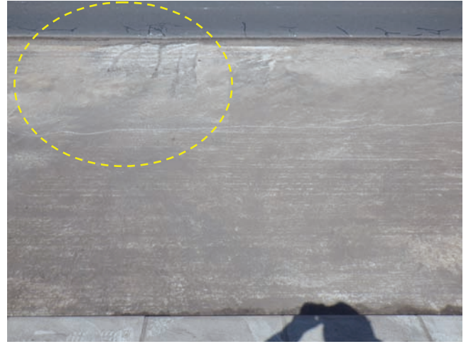
(b) 床版上面（下り側舗装除去時）
