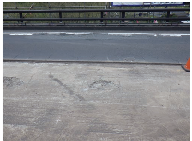
(b) 床版上面（下り側舗装除去時）
