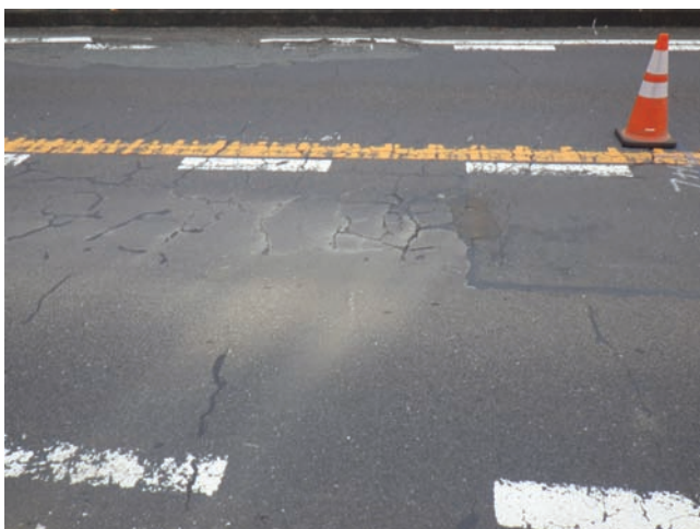
(a) 舗装の補修
