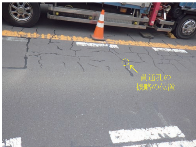
(a) 舗装の補修
