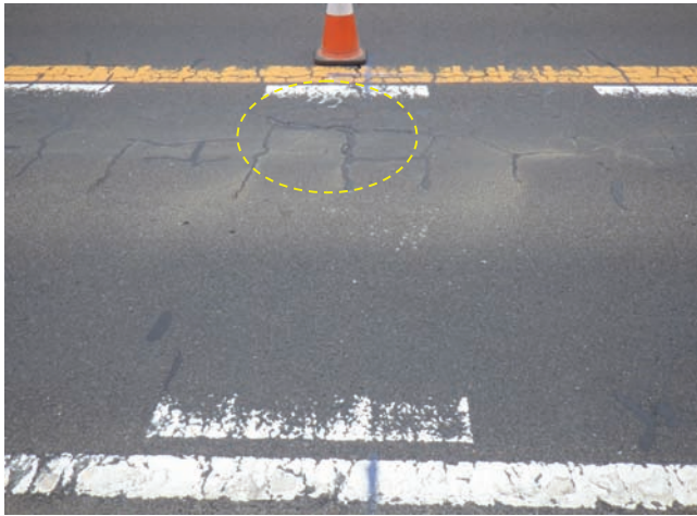
(a) 舗装の補修
