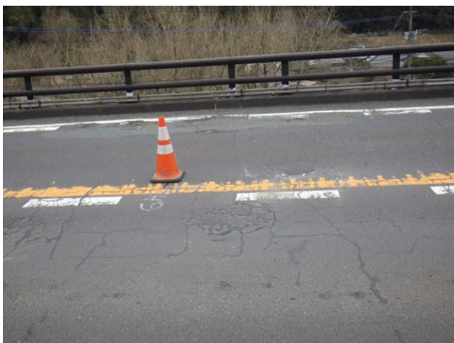
(a) 舗装の補修
