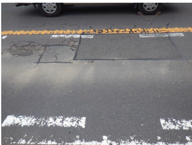
(a) 舗装の補修
