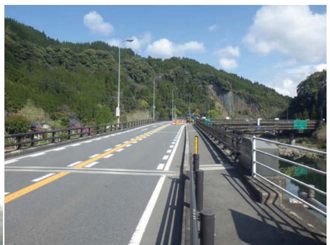
(d) 第7径間 (A2側から撮影)
