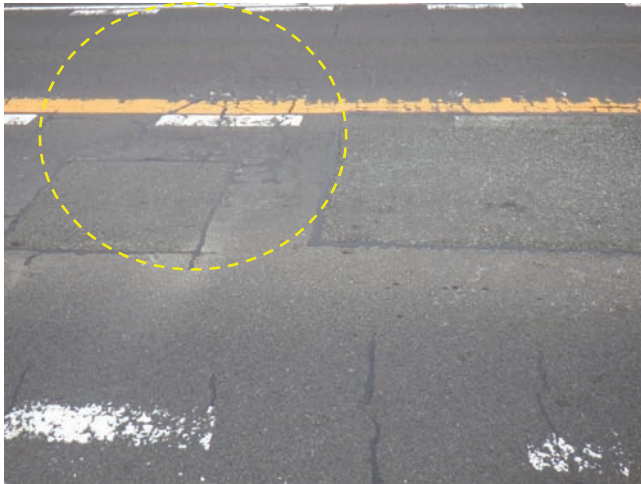
(a) 舗装の補修
