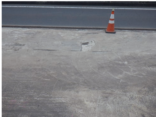
(b) 床版上面（下り側舗装除去時）
