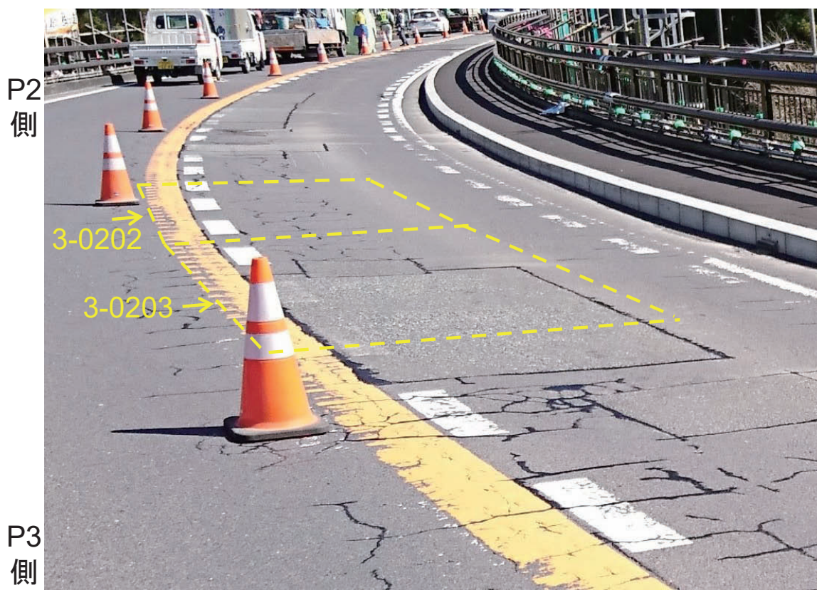
図-5.1.2 比較対象とした床版パネルの路面状況
