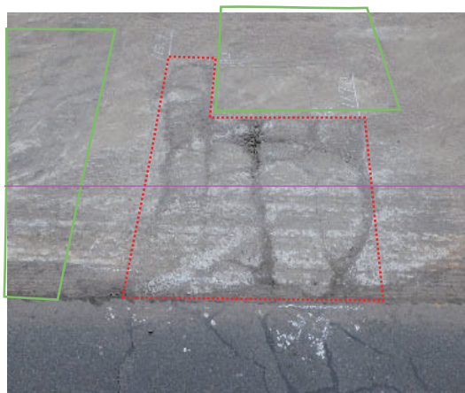
(a) 床版上面写真（舗装撤去後）
