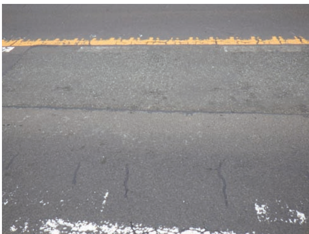
(a) 舗装の補修
