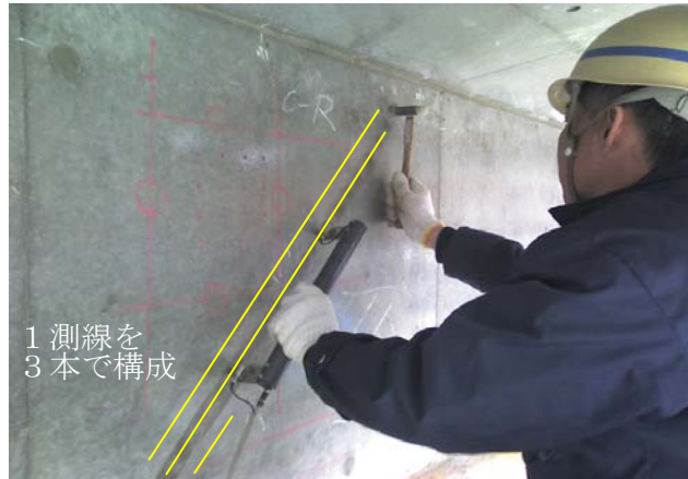
写真-5 表面2点法における測線の取り方
