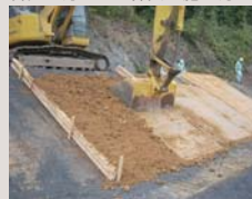
斜面上方からの締め施工方式
