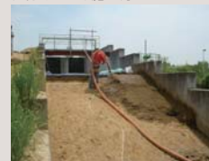
吹付けによる施工方式
