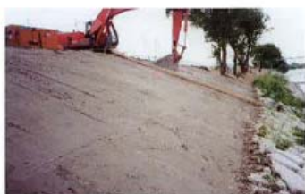
HGS 短繊維混合補強土被覆状況
