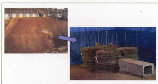
改良体と模擬樋管が一体化した状況
