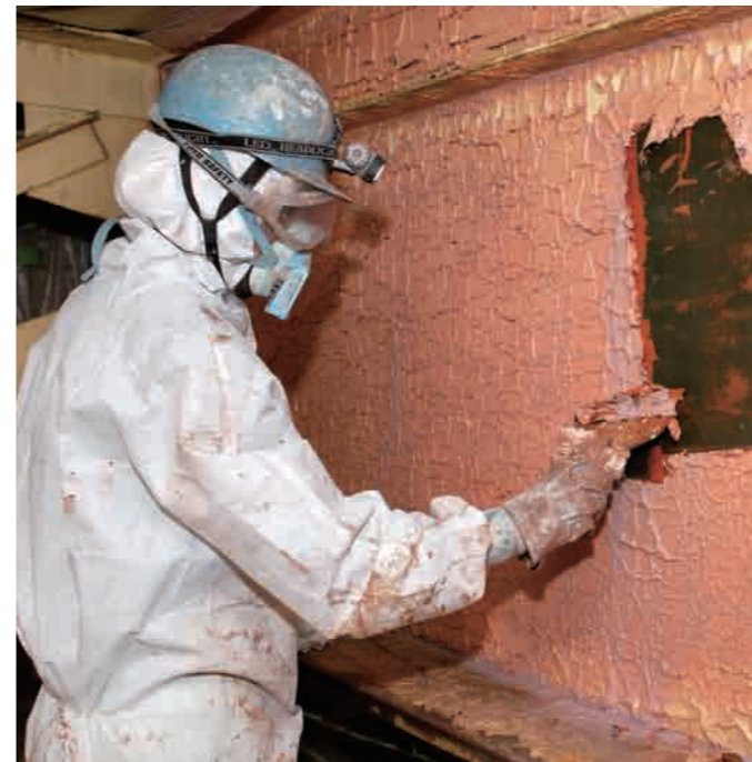
スクレーパーで容易に旧塗膜が除去できるため、電動工具処理に比べて騒音は低く抑えられました。
