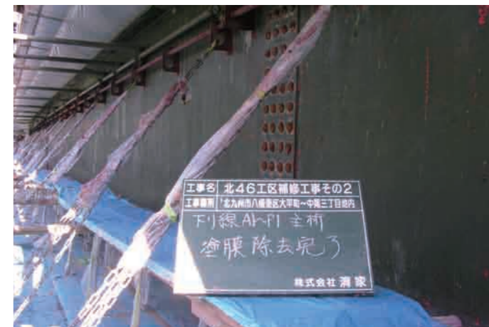
塗膜を除去したことで、インバイロワン工法は完工です。さび部の処理は電動工具を使用しました。
