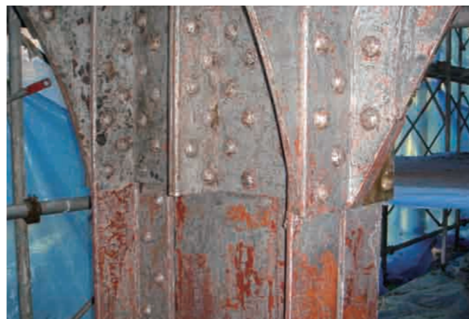
2回目の塗膜の除去作業完了。
