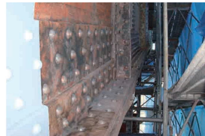
塗膜の除去が完了した部分から順次重防食塗装を施しました。写真の手前(左側)が塗装した部分です。
