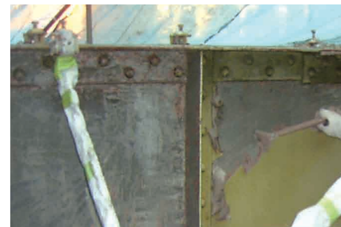
2回目も同様にスクレーパーで塗膜の除去を行いました。
