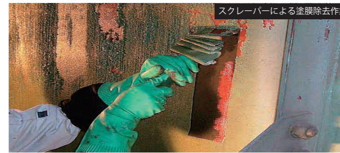
スクレーパーによる塗膜除去作業
