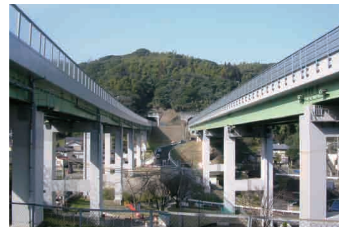
塗替え塗装完了後の金山橋。
