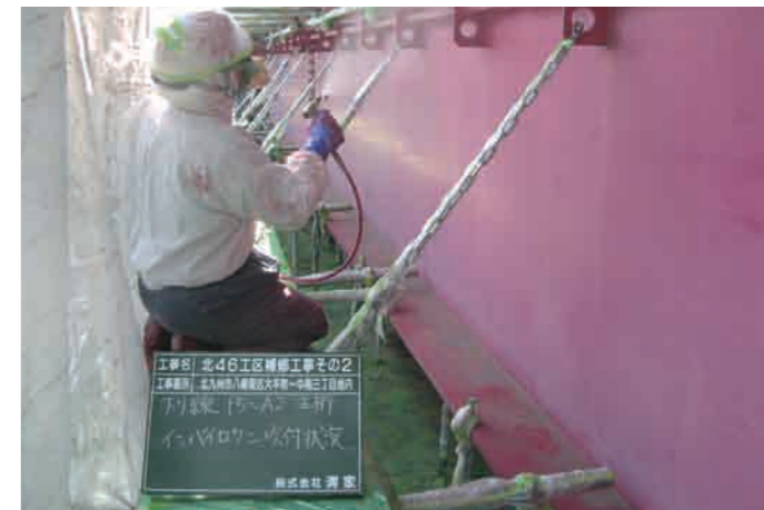
インバイロワンはスプレーにより容易に塗付できました。
