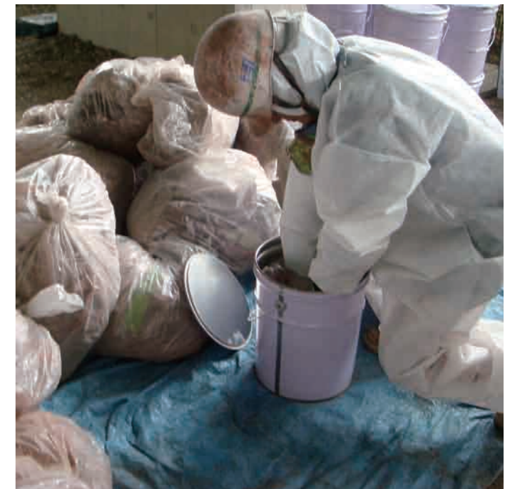
旧塗膜を飛散させずに容易に回収できました。
