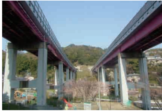
北九州高速4号線 金山橋
