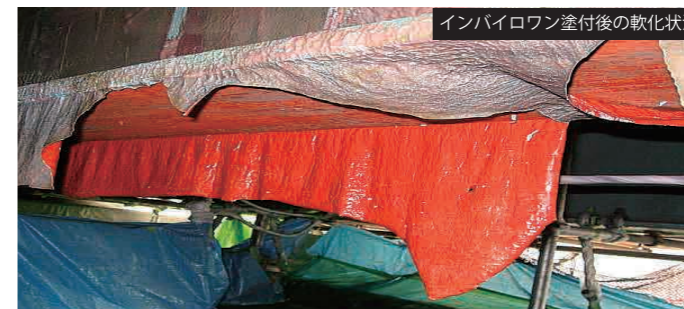
スクレーパーによる塗膜除去作業
