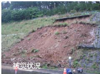
図-6 狭い集水地形で崩壊した箇所の事例
