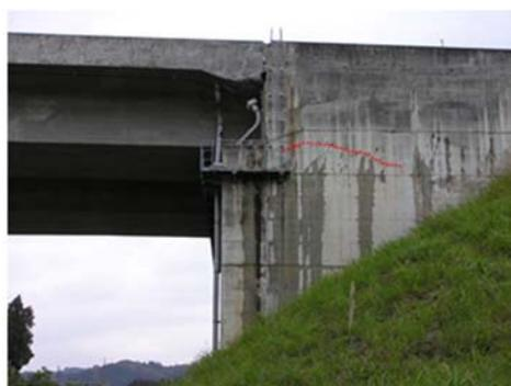
(赤点線は押し抜きせん断によるひび割れ位置)
