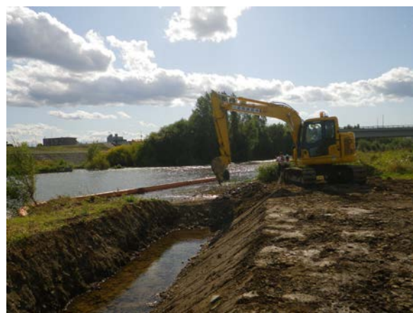
写真-2 alcove 上流に堆積した砂州の掘削路造成作 業(施工最終日の2017年9月26日に本調査 地の左岸砂州上から本流上流方向を撮影)
